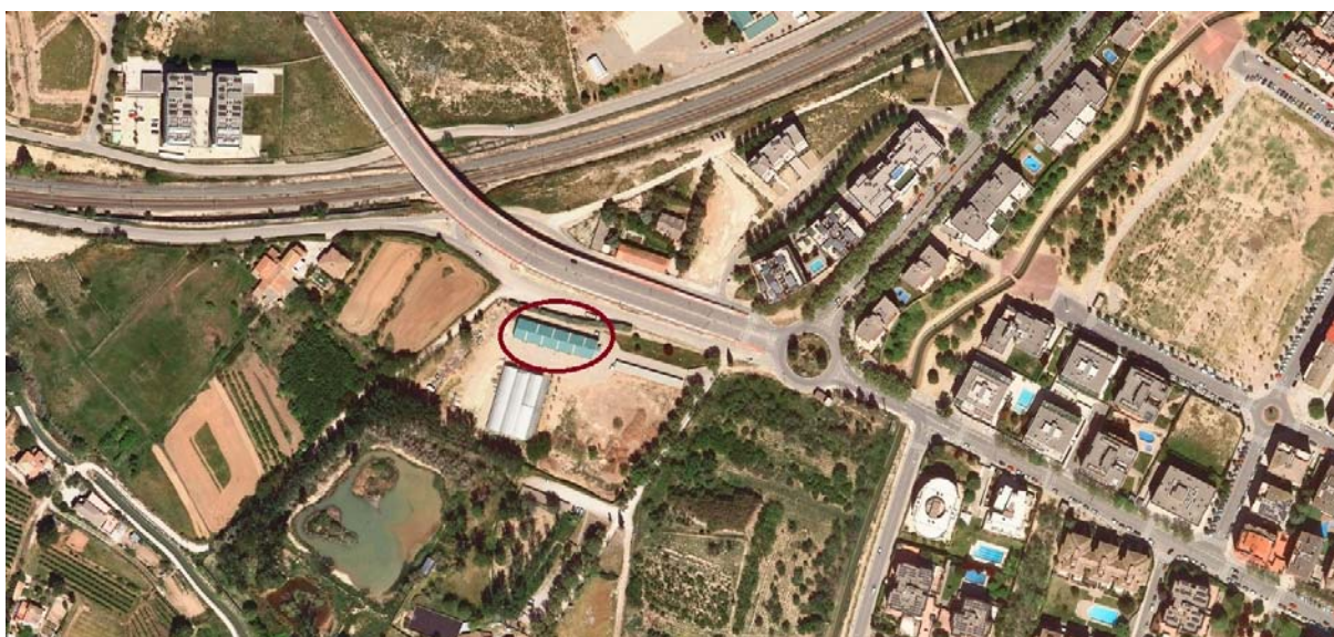
A sobre s'observa la situació de l'obra segons imatge obtinguda de l'Institut Cartogràfic i Geològic de Catalunya.
