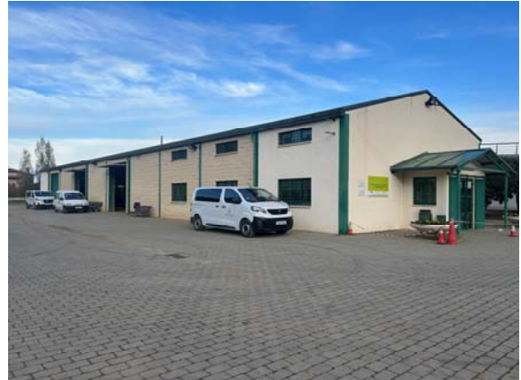
Visió de la vessant sud de la nau objecte d'actuació.
