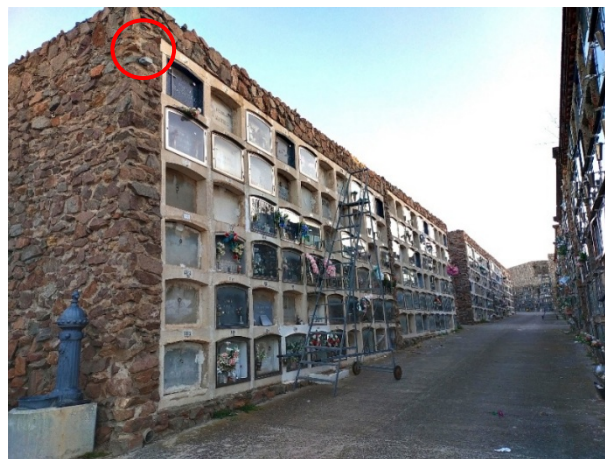
Vista de la façana principal del Bloc 14 – Clinòmetre 14A
