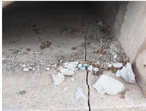
Esquerdes en el nínxol 4191 primer pis del bloc 14
