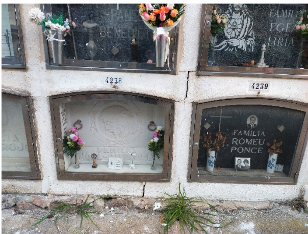
Esquerdes en el nínxol 4238 primer pis del bloc 13
