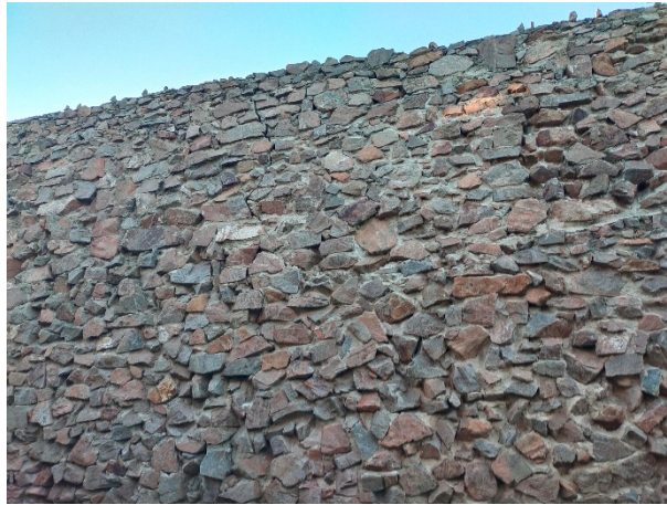
Esquerda en tram del mur dels Blocs 10 – 11 - 12
