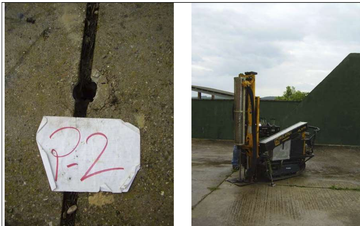
Fotografia 3. Màquina de penetròmetre treballant en el punt P-2 i testimoni del forat de sondeig.
