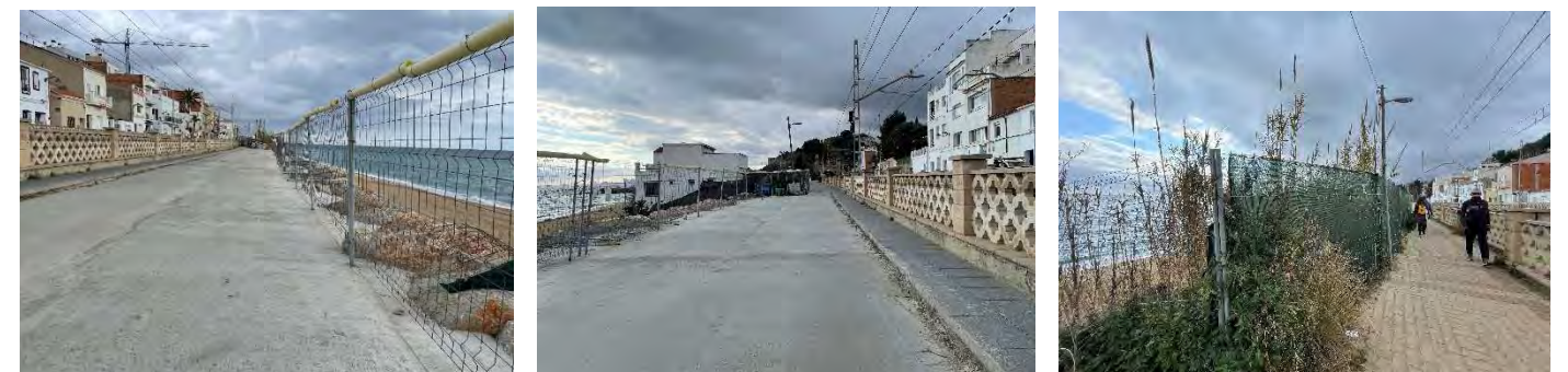
Imatges de l'estat actual del passeig superior on s'executarà l'actuació de pavimentació i disposició d'enllumenat del present projecte.
