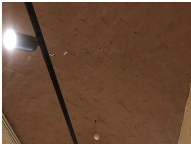
230920-59 i 230920-45. Exemples d'esquerdes i fissures a voltes del sostre de la planta baixa, a àmbits oest i central.
