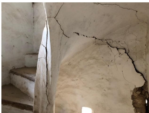
240626-36 i 240626-32. Esquerdas a les trobades de murs de tancament de la torre sud-oest amb els mur del front sud del volum central de l'edifici.
