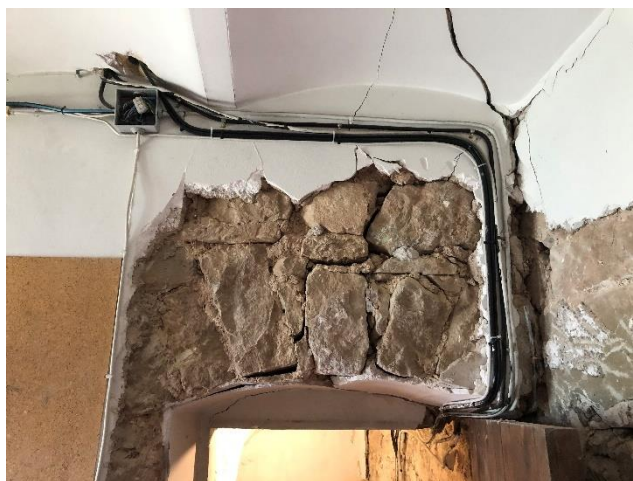
240626-36 i 240626-32. Esquerdas a les trobades de murs de tancament de la torre sud-oest amb els mur del front sud del volum central de l'edifici.
