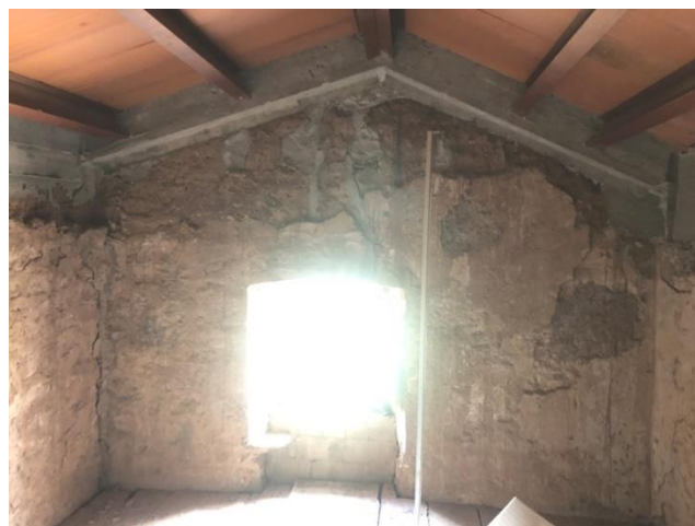
230920-117 i 230920-114. Afectació d'esquerdes de directriu vertical als murs de la planta sotacoberta del volum annex nord-oest.
