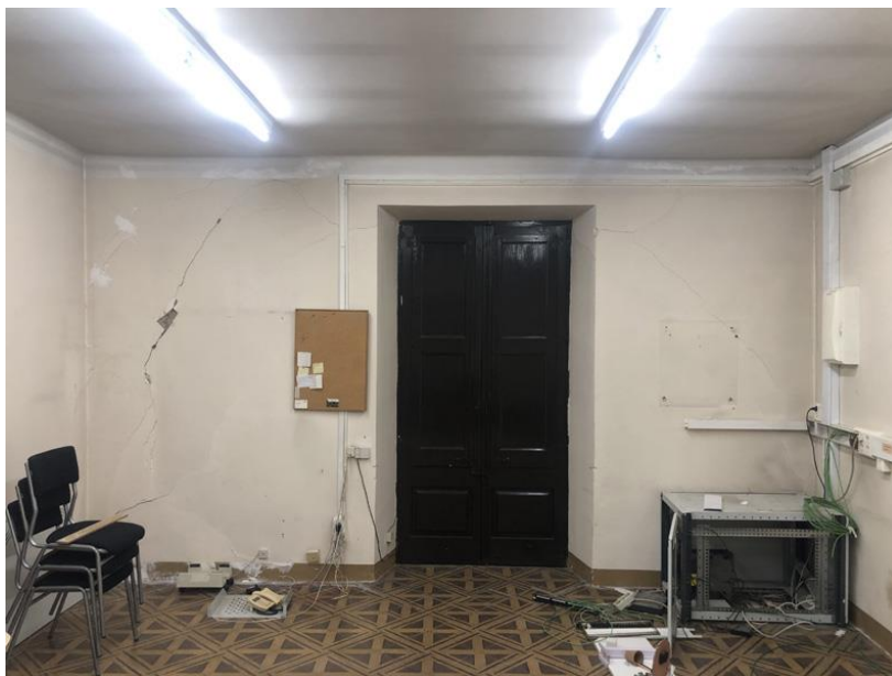
230920-148 i 230920-152. Afectació d'esquerdes de directriu vertical als murs de la sala nord-est de la planta primera.
