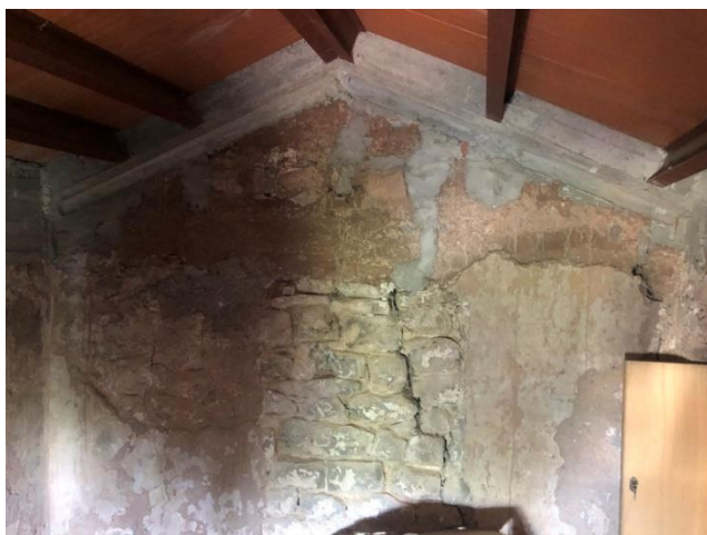
230920-117 i 230920-114. Afectació d'esquerdes de directriu vertical als murs de la planta sotacoberta del volum annex nord-oest.
