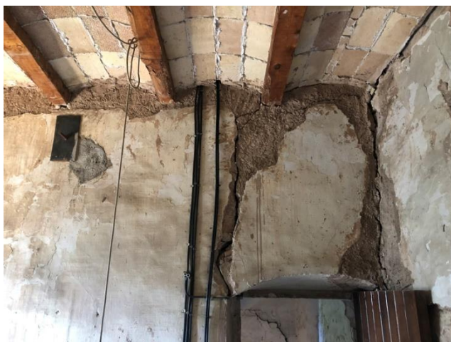
240626-36 i 240626-32. Esquerdas a les trobades de murs de tancament de la torre sud-oest amb els mur del front sud del volum central de l'edifici.
