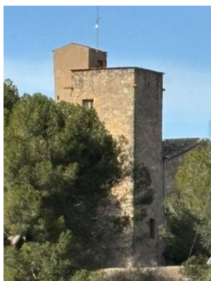
Imatge 240228-36 on es pot apreciar l'existència de desploms parcials entre el volum de la torre nord-est, el volum adjacent de la caixa d'escaleres de la torre i el volum central de l'edifici. Al costat un esquema gràfic explicatiu de la tendència de deformació dels volums edificats.
