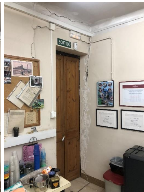
230920-148 i 230920-152. Afectació d'esquerdes de directriu vertical als murs de la sala nord-est de la planta primera.
