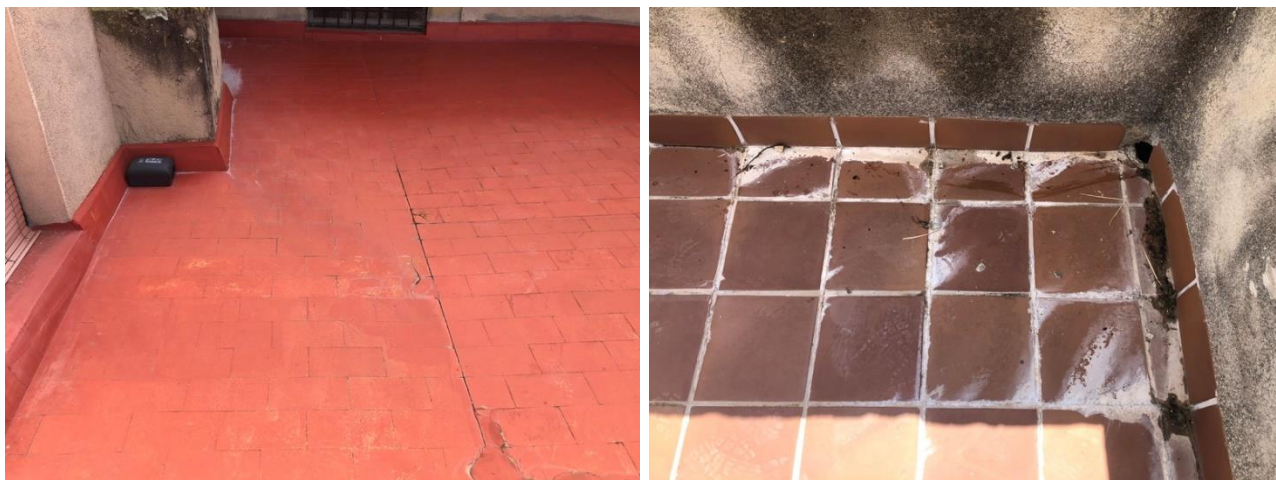
230920-168 i 230920-261. Exemples de trams de terrats a la planta primera i al capdamunt de la torre, amb esquerdes als paviments, acumulació de dipòsits de sediments que indiquen entollaments freqüents, i afectacions de filtracions de diversa magnitud als sostres inferiors.
