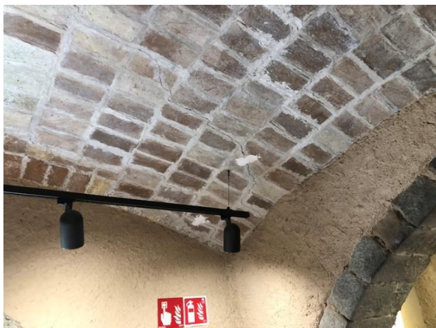
230920-59 i 230920-45. Exemples d'esquerdes i fissures a voltes del sostre de la planta baixa, a àmbits oest i central.
