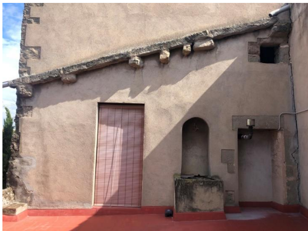
230920-160 i 230920-163. Esquerdas a les trobades dels murs dels volums edificats nord-est i nord-oest respectivament, respecte del volum central, des de la terrassa de la planta primera.
