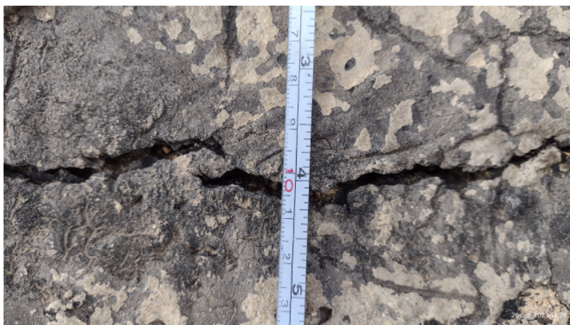
Inspecció zona final plint de formigó
