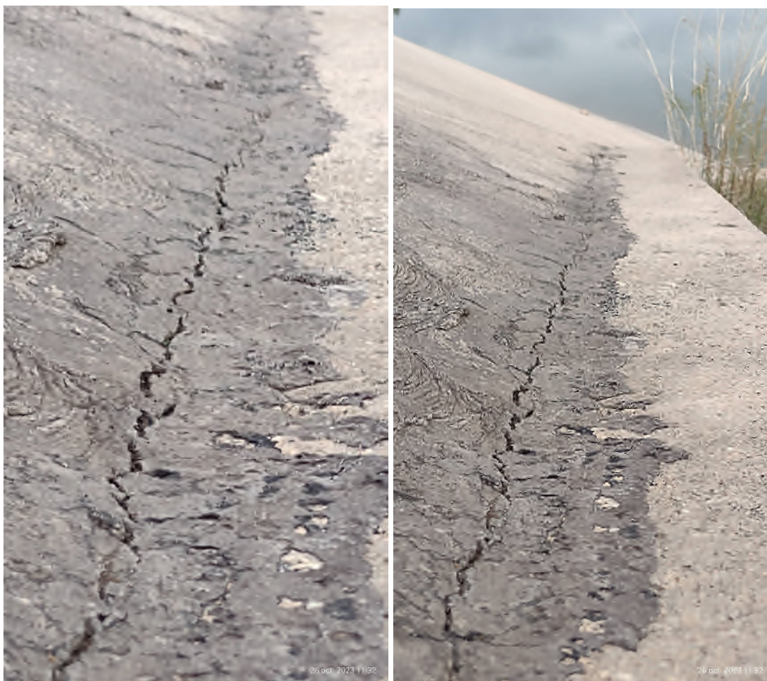
Inspecció detallada esquerra pantalla asfàltica / mur zona sobreeixidor (octubre 2023)
