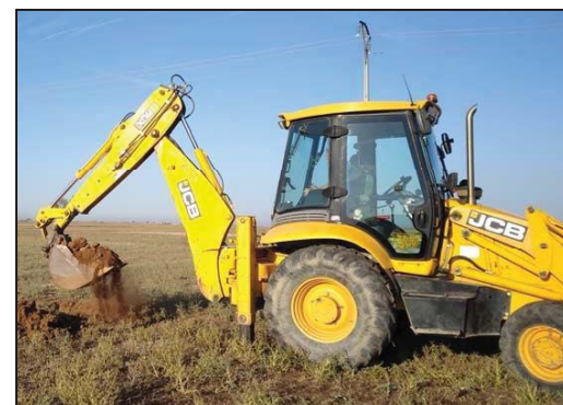
Fotografia 4. Detall de la màquina que realitza les calicates mecàniques.
