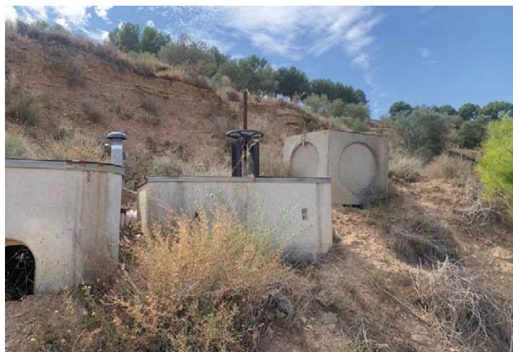
Fotografia 5 Detall de les arquetes de distribució actual de la xarxa principal de Sant Jaume.
