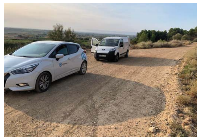
Fotografia 7 Nova vista dels camins municipals per on s'instal·laran les noves canonades d'impulsió i distribució del reg.
