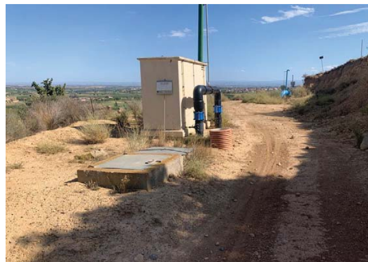
Fotografia 6 Camí de servei per on s'executaran les rases de les noves canonades a instal·lar.
