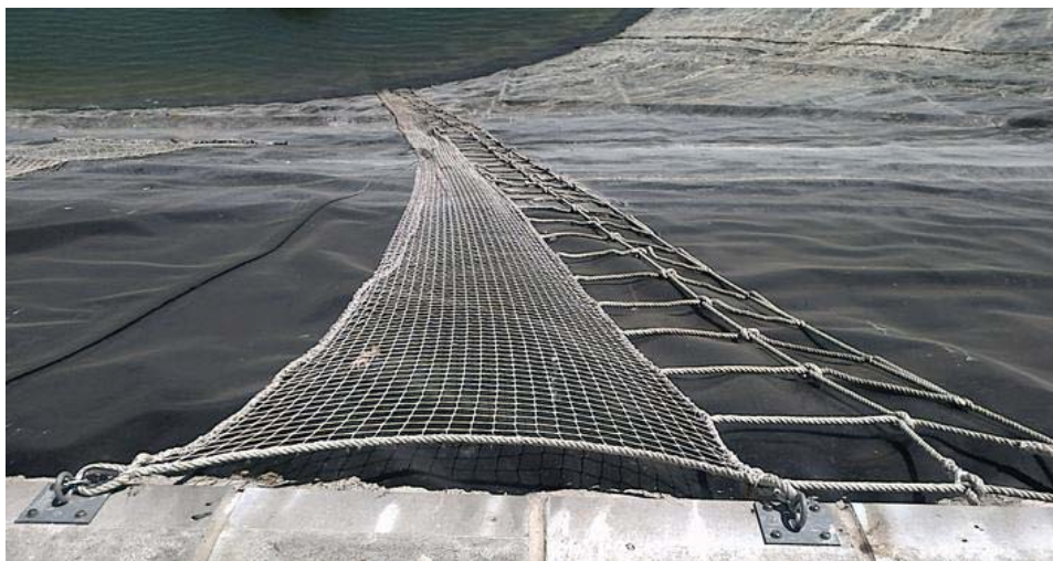
Fotografia 1 Exemple tipus de malla a instal·lar.
