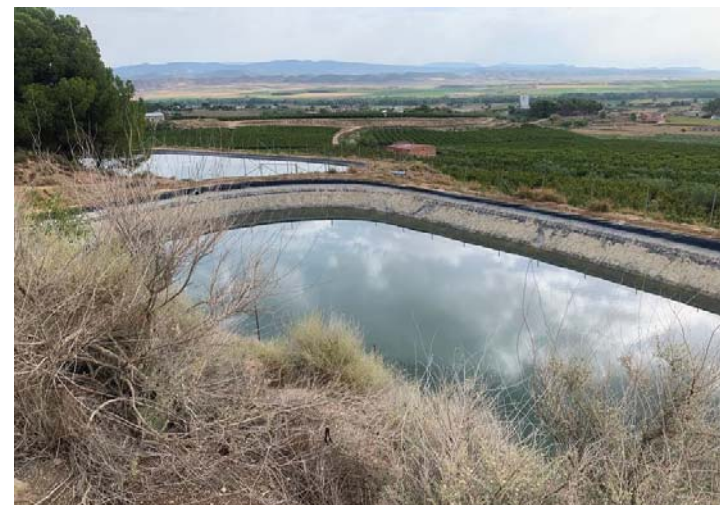
Fotografia 3 Visual de les basses on s'instal·larà el sistema d'impulsió d'aigua fins a la bassa de regulació.
