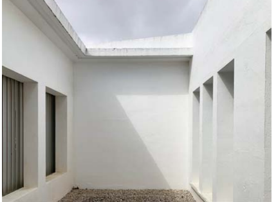
Pati amb la portella d'accés a la cambra d'aire sota coberta
