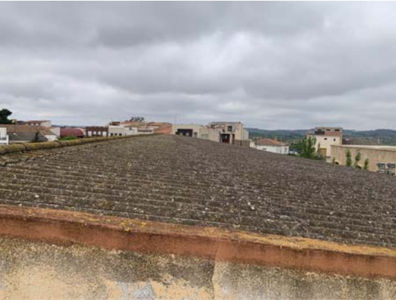
Detalls de coberta
