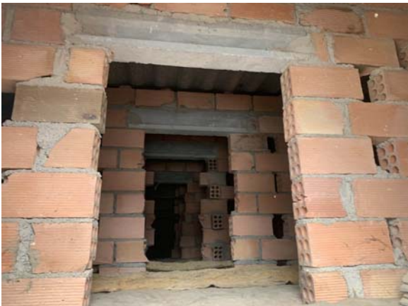
Detall dels envanets de sostre-mort i de la cambra d'alre sota coberta
