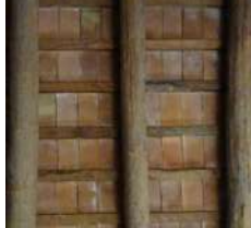
11 Coberta amb biguetes de fusta, llates de fusta, tauler de rajoles ceràmiques i teules ceràmiques
