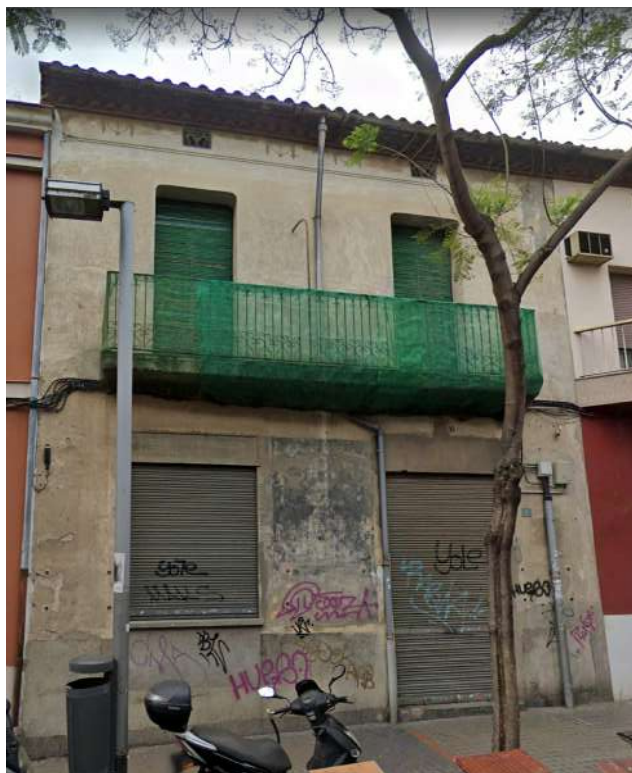
Foto façana existent carrer de l'Estació
