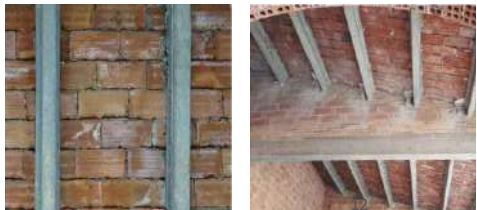
12 Coberta de teula ceràmica amb biguetes de formigó armat, tauler de rajoles ceràmiques i teules ceràmiques
