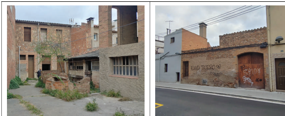
Vistes de la part posterior de l'edifici existent a reformar (Ctra de l'Estació) i de la façana del carrer Dr. Gil.
