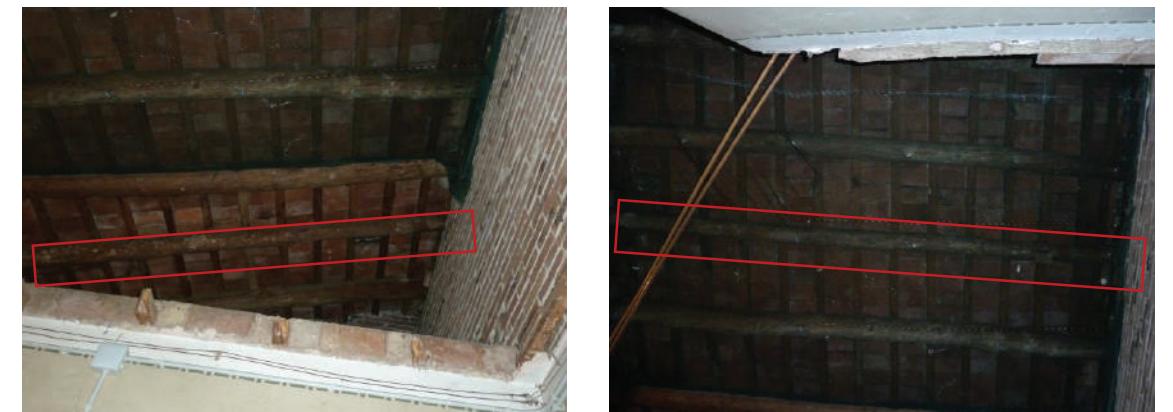
Figura 1.6 Identificació de les biguetes amb diàmetre Ø16 entre bigues de diàmetre Ø18.
