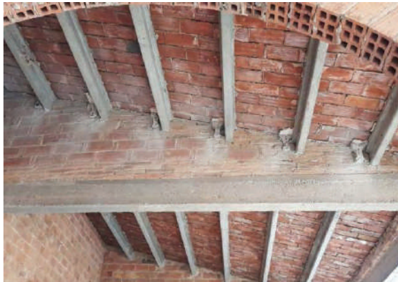
Figura 1.7 Imatge de les biguetes de formigó de la coberta del cos D.
