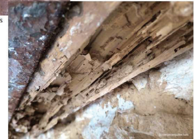
Degradació de la fusta causada pels tèrmits subterranis
