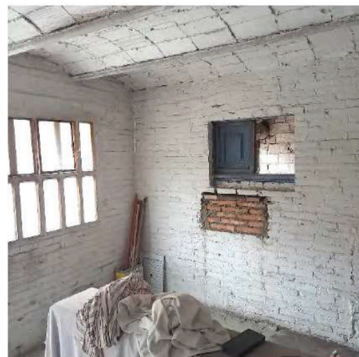
Extracció morter d'unió MO-1, paret M-1
