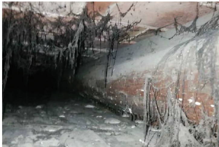
Figura 3.1 Element ocult pel cel ras del sostre de la planta baixa.
