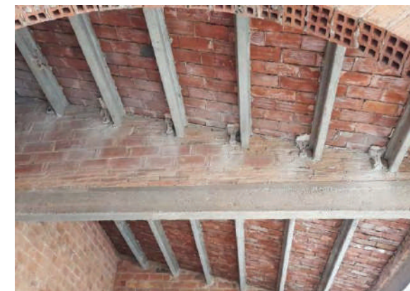
Figura 4.5 Imatge de les biguetes de formigó de la coberta del cos D.
