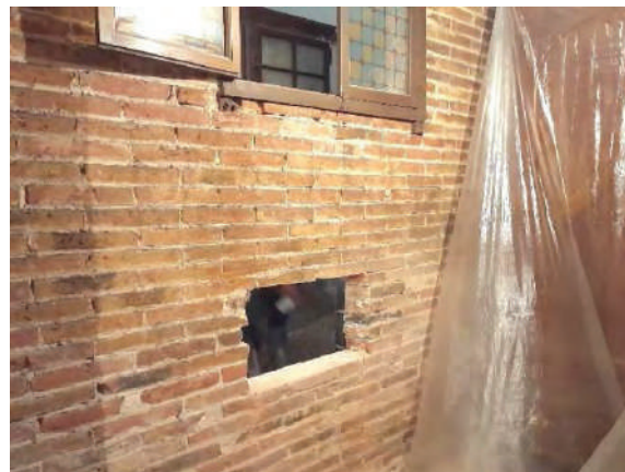
Figura 2.11 Cala ACM3 (paret M3 planta primera).
