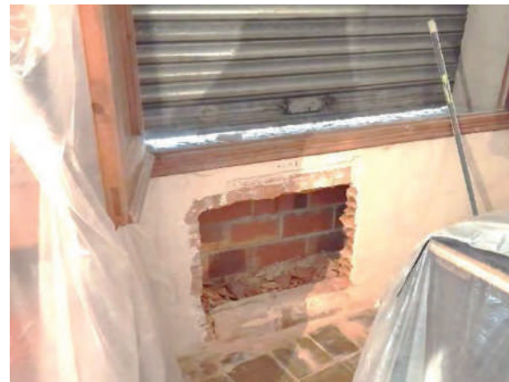
Figura 2.8 Cala ACM1 (paret M2).
