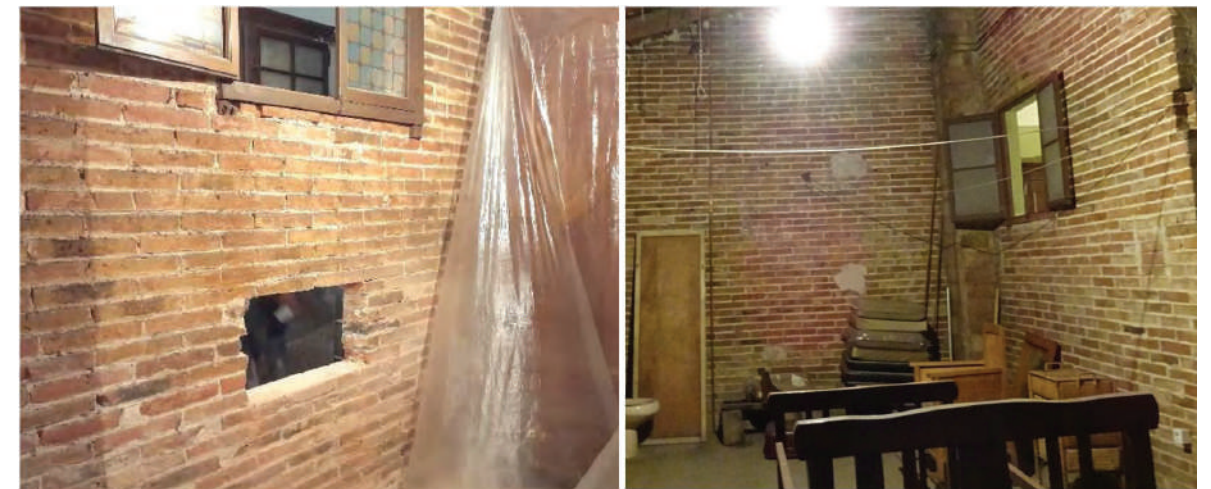
Figura 4.7 Murs de planta baixa i planta primera corresponents a la cala ACM3 (paret M3).
