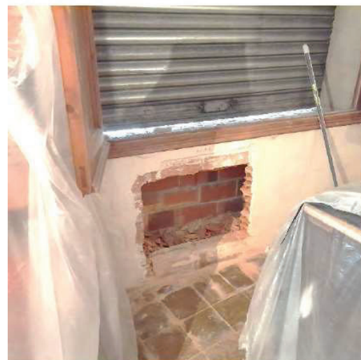
Extracció morter d'unió MO-2, paret M-2
