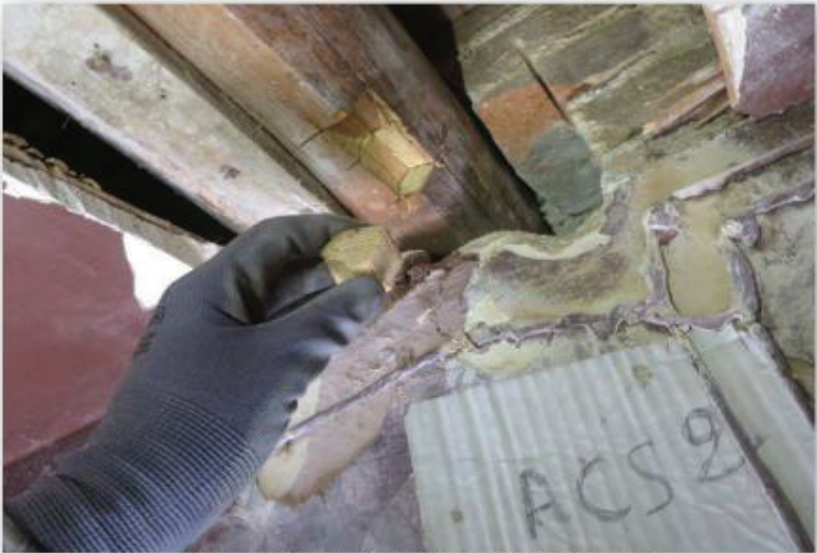
Sostre de la planta baixa (PB). Cala ACS2. Element PBC5. Imatge 462 Extracció d'una mostra de fusta
