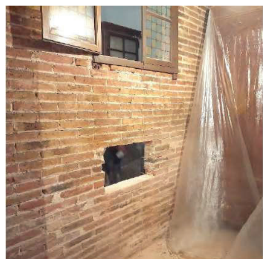
Extracció morter d'unió MO-3, paret M-3
