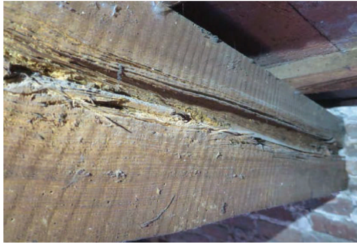
Figura 2.3 Fenedura central present a la biga del sostre de la planta primera.
