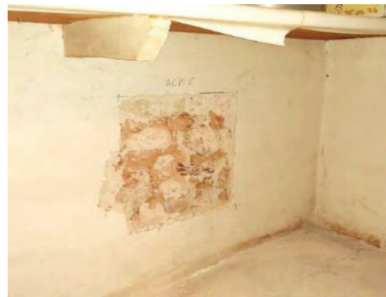
Figura 2.10 Cala ACM6 (MO-6).
