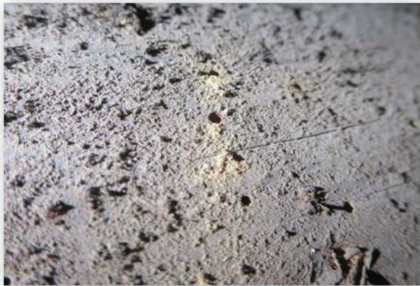
Sostre de la planta 1 (P1). Element P1C4. Imatge 379 Forats de sortida de corcs de petita grossària Serradures produïdes per la sortida de corcs adults
