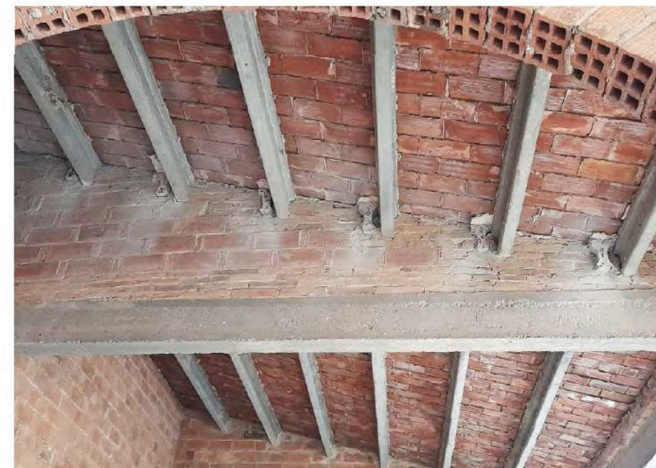
Lloc d'extracció. Extrems de bigueta tallats, numerats de l'1 al 6
