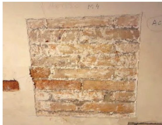
Figura 2.9 Cala ACM7 (MO-4).
