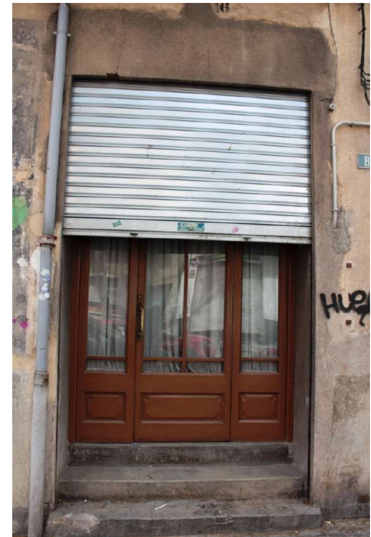
Detall de l'obertura que conté la porta d'accés a l'interior de la finca, que es realitza salvant el desnivell de tres graons. Observi's com el primer graó sobresurt lleugerament del pla de façana. (No s'ha pogut pujar la persiana totalment per poder mostrar la factura de la porta)
