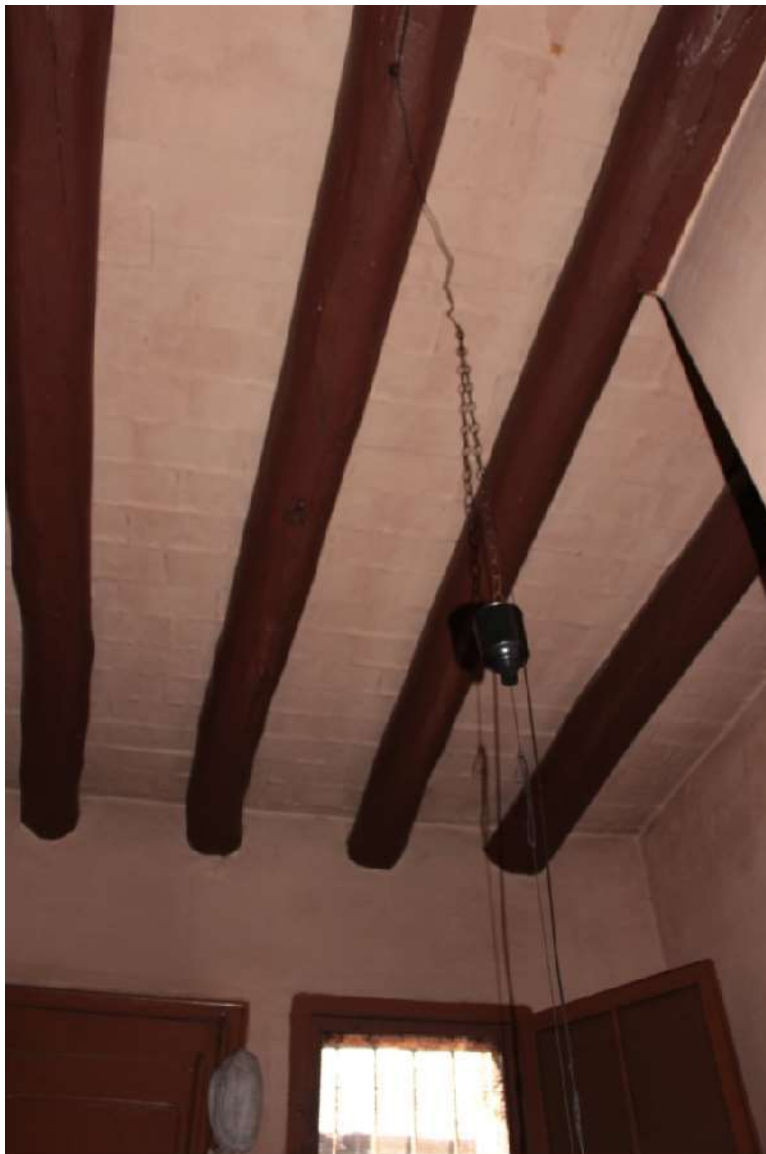
Forjat de la cuina, amb les bigues de fusta i les rajoles en pla
