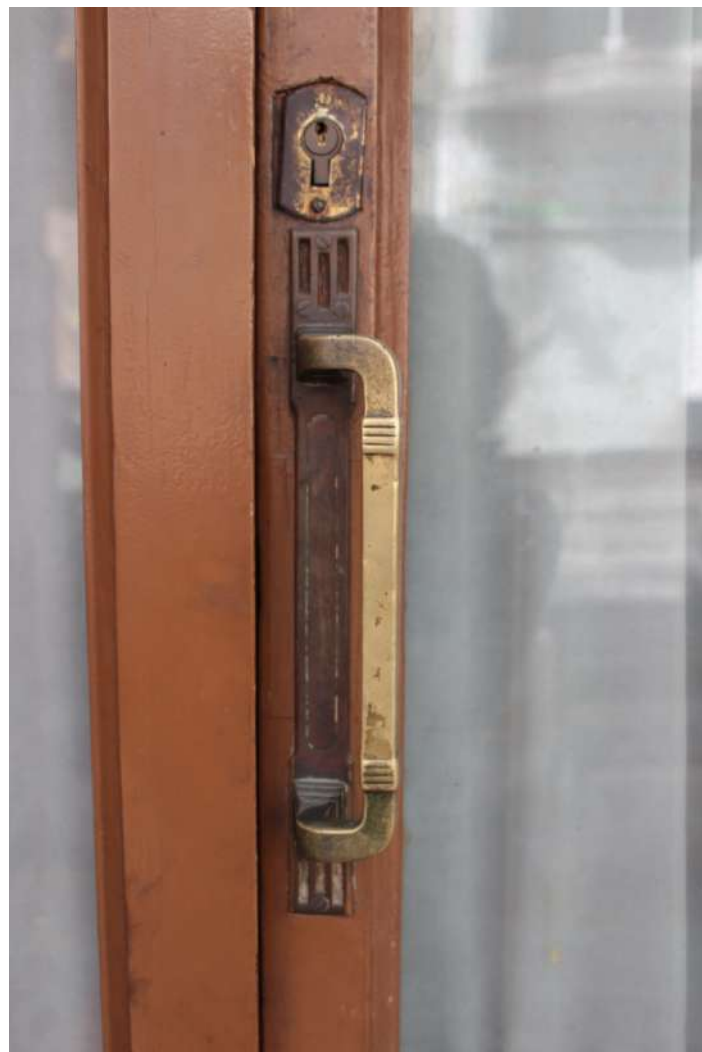
Sobre aquestes línies, detall del pom de la porta d'entrada A la dreta, vistes interiors de la porta i de la finestra, on poden observar-se els motius geomètrics decoratius a partir dels llistons dels quadrants dels vidres. El de la finestra –a baix- sembla modificat
