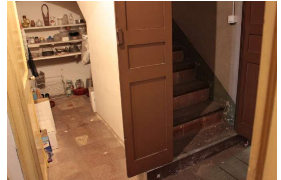
Caixa d'escala amb accés a la part inferior i arrencada del tram
