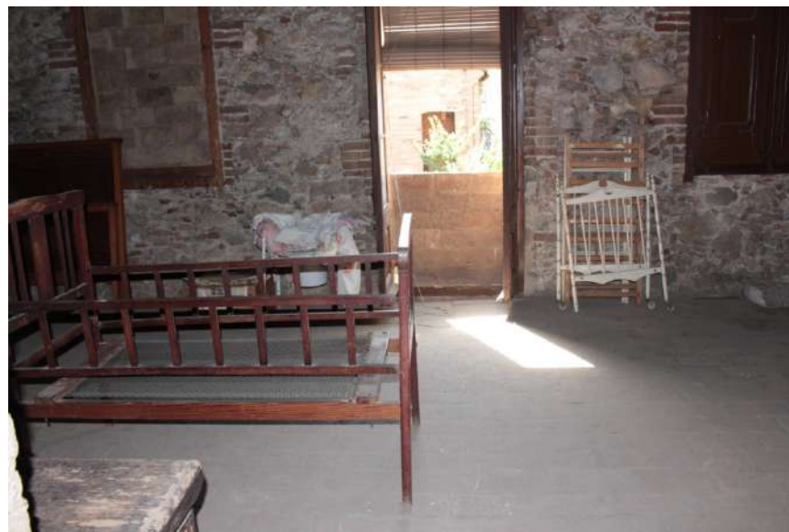
Diverses imatges de de l'espai. La manca de revestiment permet veure la factura de l'obra, amb la façana de paredat i els murs d'obra de fàbrica. La mitgera més oriental mostra el recreixemnt de la finca objecte d'estudi respecte la finca veïna
