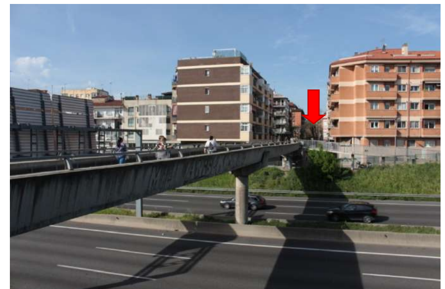
Passarel·la que travessa l'autopista i comunica Ripollet amb el barri del Pont Vell. La passarel·la desemboca en el traçat de la carretera de l'Estació (marcada amb una fletxa)
