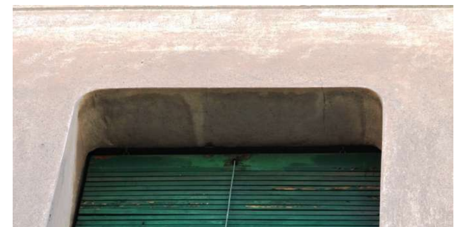
Balcó corregut d'obra del pis superior Observi's com els angles superiors de l'obertura –sense muntants ni llindes- estan arrodonits.
