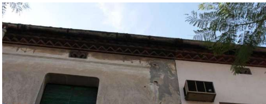
Continuïtat de la cornisa i ràfec entre les dues finques
