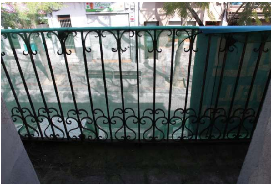
Detall de la barana de forja des del balcó
