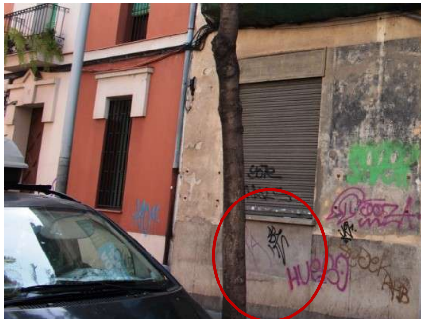
A dalt, vista general de la façana. Sobre aquestes línies, detall de la zona de la finestra on s'indica les possibles traces d'un cegat del que hagués estat originalment una porta
