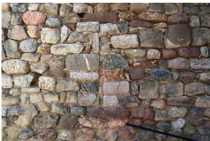
Detall del parament de la façana oest amb una de les espitlleres documentades.
