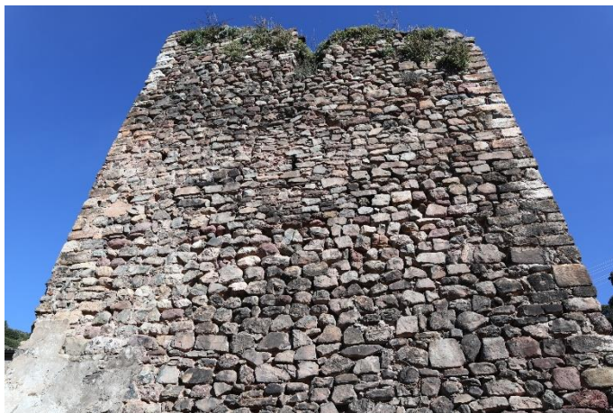
Vista de la façana est. A la part superior s'aprecia el retall UE 06, tapiat amb el mur UE 07 i amb l'espitllera UE 08. A dalt de tot s'aprecia les restes de la finestra UE 12.
