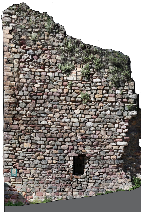
FAÇANA NORD (NW)
