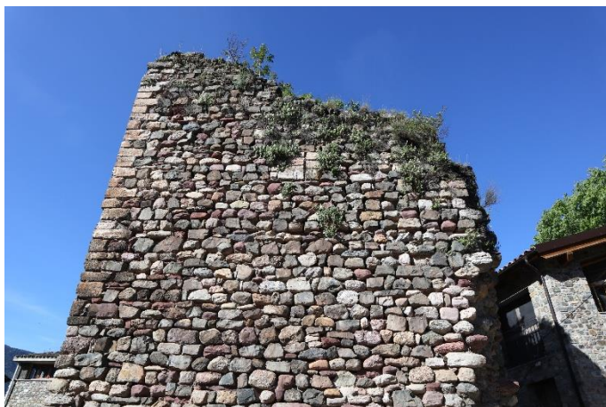
Parament UE 02 de la façana nord. Al centre es documenta l'espitllera UE 15. A l'esquerra s'aprecia la reparació de la cantonera UE 05.
