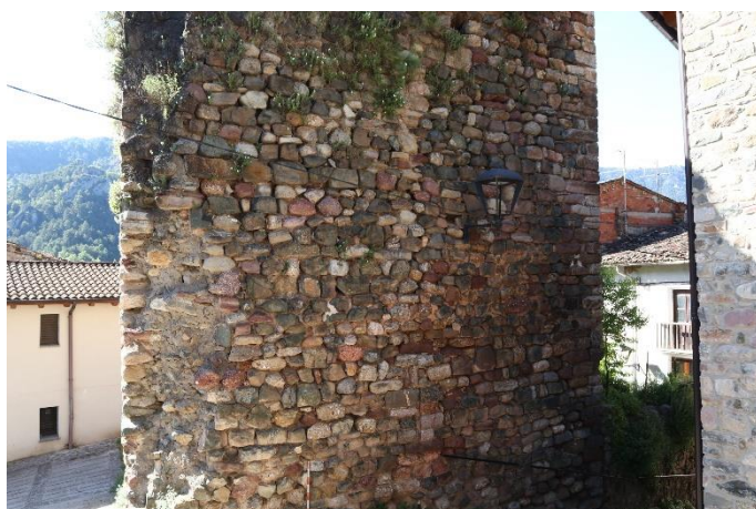
Vista general de la façana oest. Parament UE 03 amb les espitlleres UE 20 i UE 21.
