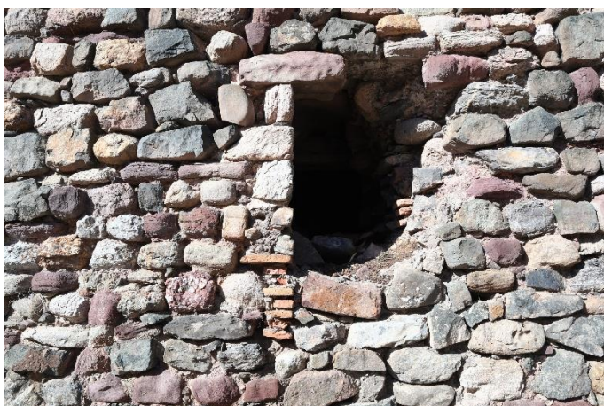
Detall de l'obertura UE 16 amb l'espitllera UE 17, el tapiat UE 18 i la finestra UE 19.
