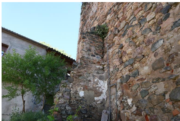
Mur UE 25 adossat al parament UE 04 de la façana sud.
