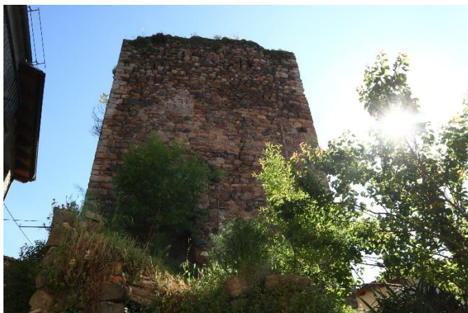
Vista de la façana sud. Parament UE 04 amb les espitlleres UE 22, UE 23 i UE 24. A banda i banda s'aprecia la reparació de la cantonera UE 05.
