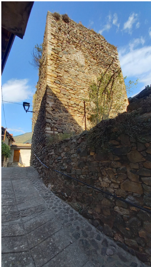
Façana Oest, carrer de la Pau.
