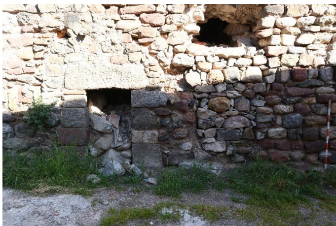
Vista de la porta UE 11 construïda en el retall UE 09 tapiat pel mur UE 10.
