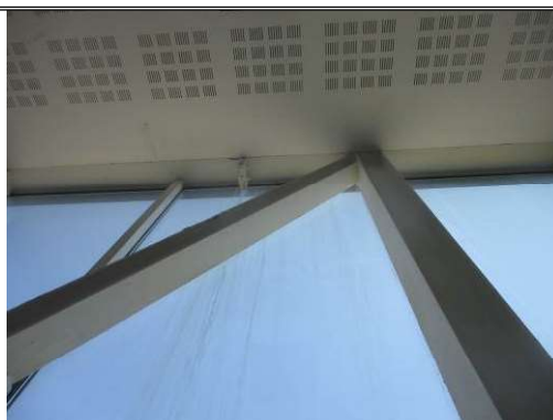
Detalles del interior alcance zona de ensayo
