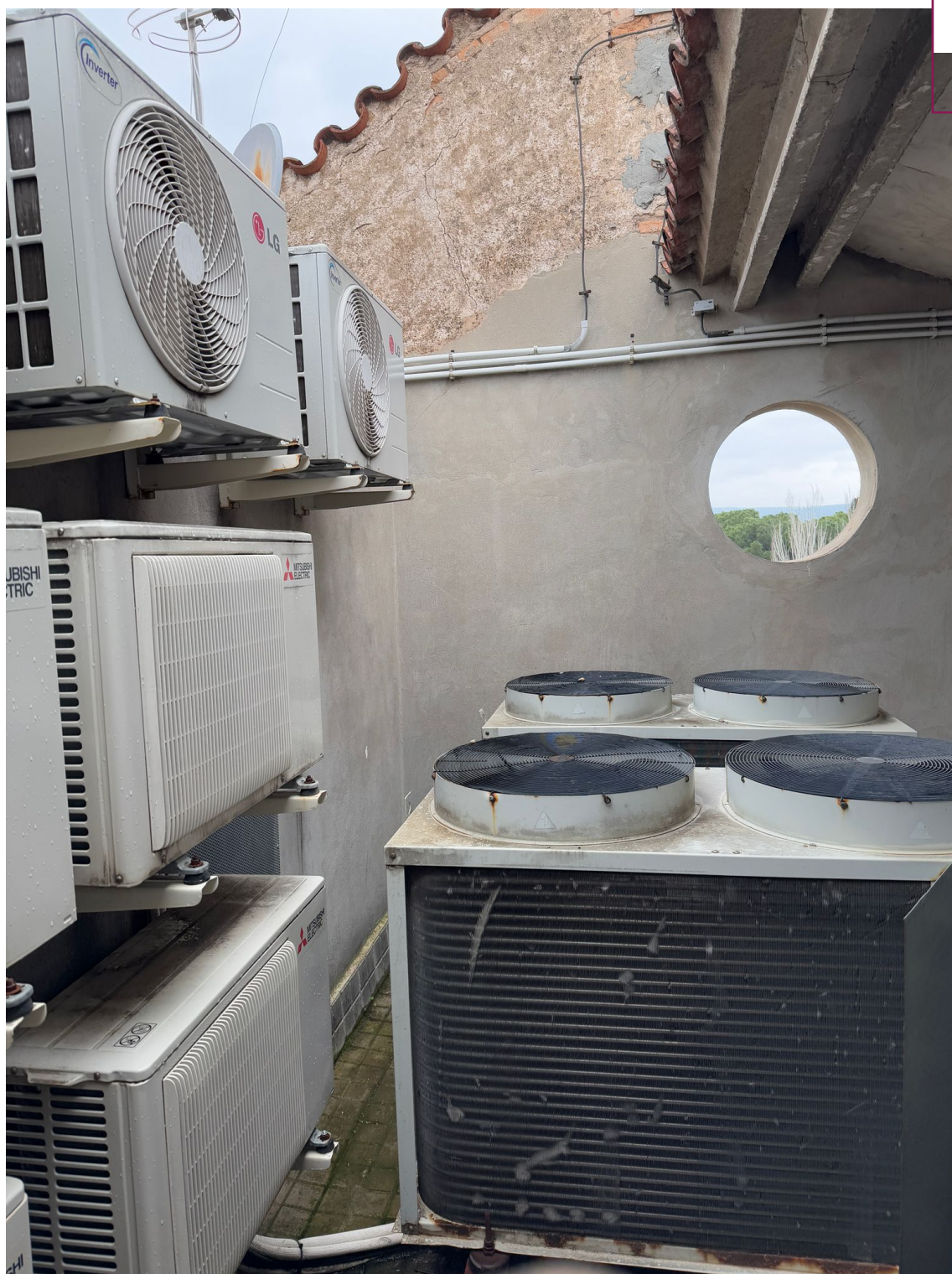
Imatge 20: Entrada de l'espai sota coberta on actualment hi ha equips de climatització
