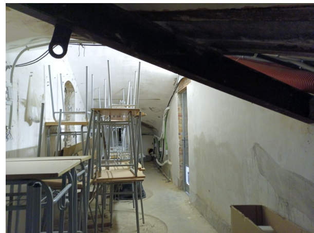
FOTO 4 Espai sota coberta
