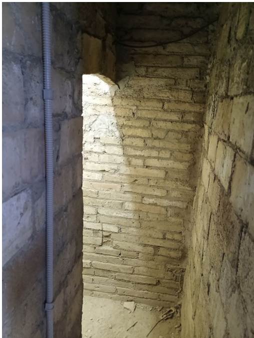
FOTO 7 Espai sota coberta
