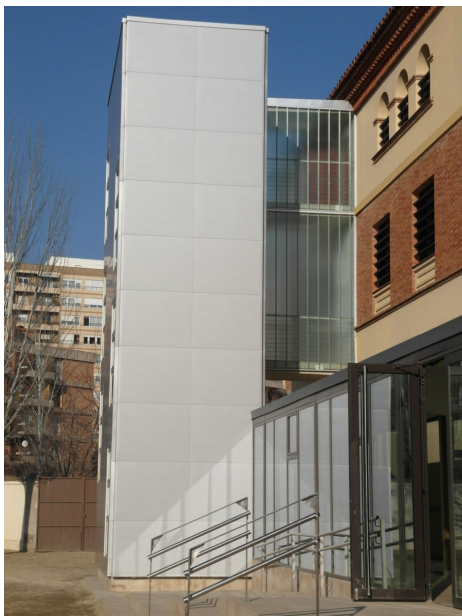
FOTO 3 Detall de la façana posterior de l'edifici i una de les escales d'emergència
