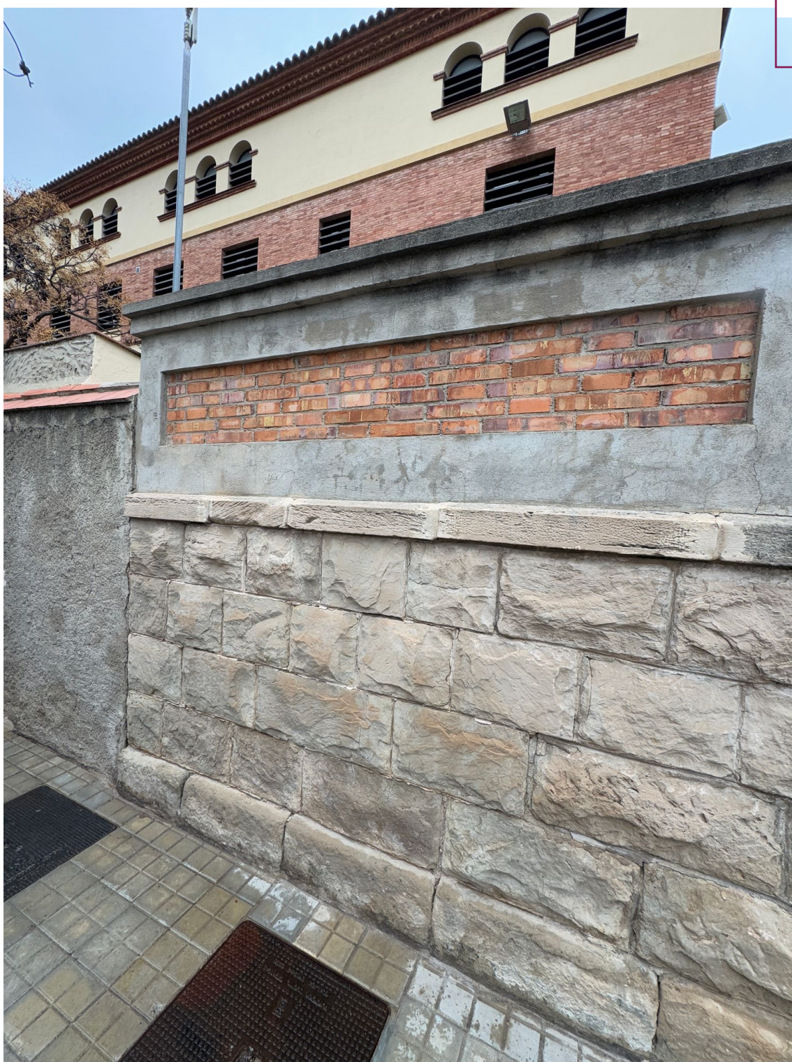
Imatge 18: Espai exterior actual on es projecten els nous armaris. S'hi observa arqueta d'entrada de subministrament.
