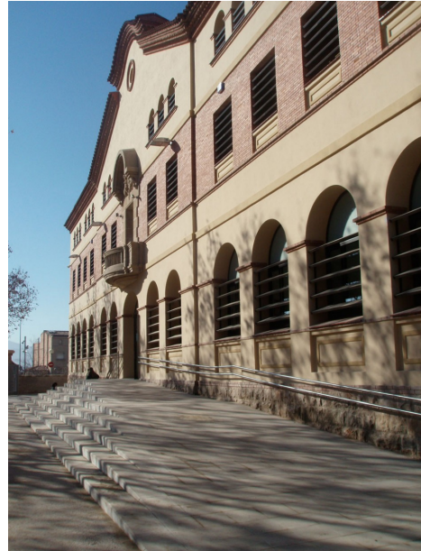
FOTO 2 Detall de la façana de l'edifici
