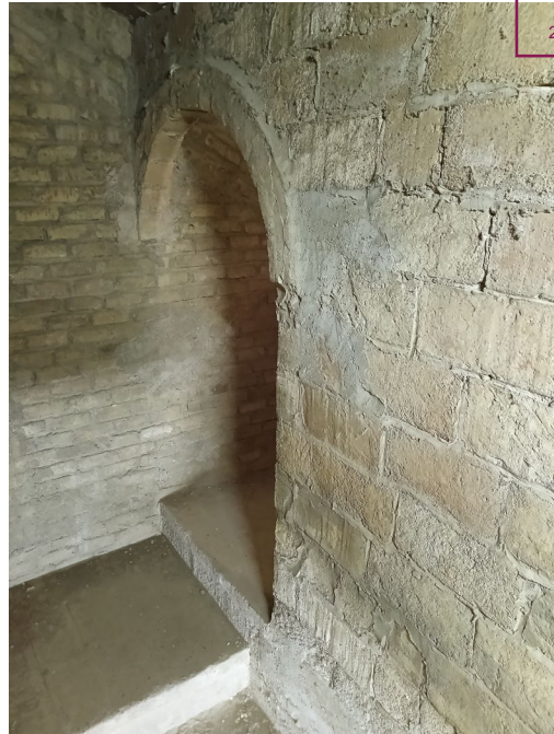
FOTO 6 Espai sota coberta
