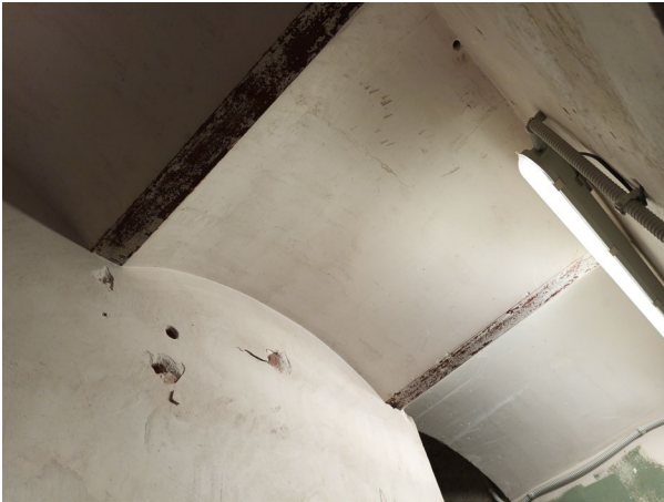
FOTO 5 Espai sota coberta
