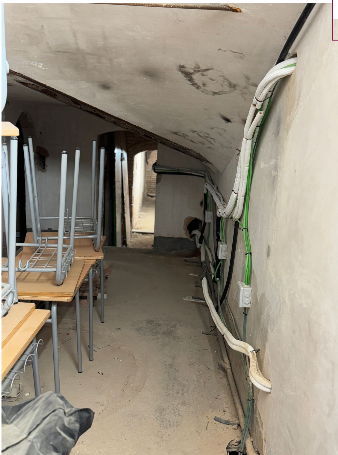
Imatge 19: Espai sota coberta on ubicar inversors i quadres CC i CA
