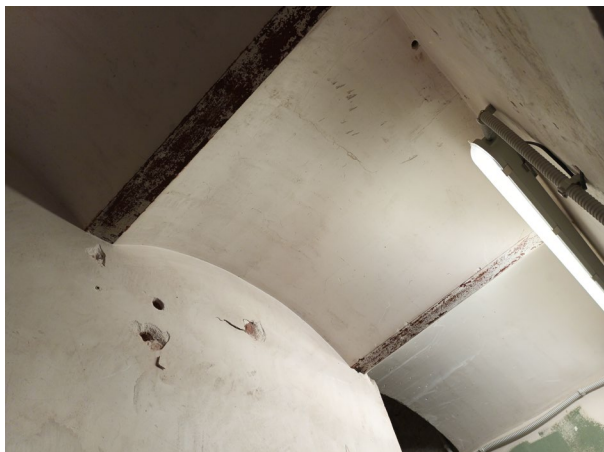
FOTO 5 Espai sota coberta
