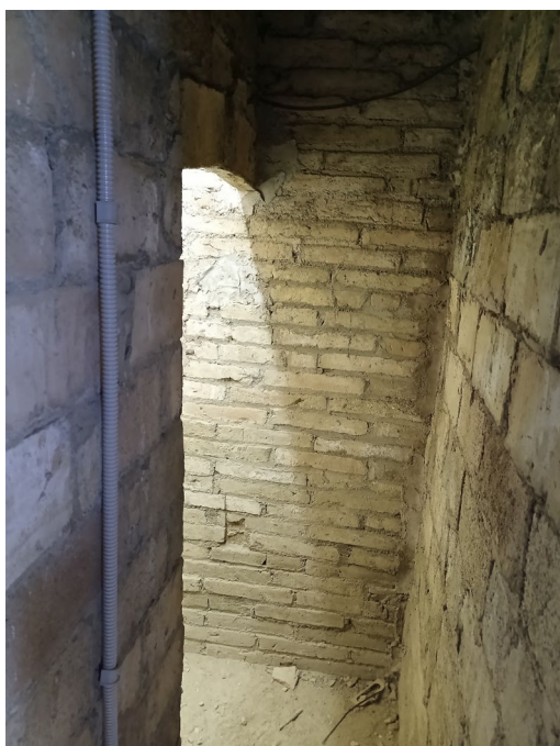
FOTO 7 Espai sota coberta
