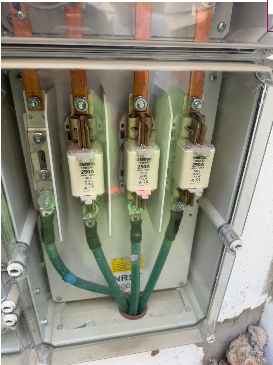
Imatge 27: Detall dels fusibles (no tipus BUC) de la TMF10 existent de consum de l'escola
