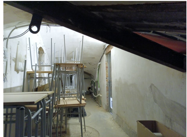
FOTO 4 Espai sota coberta
