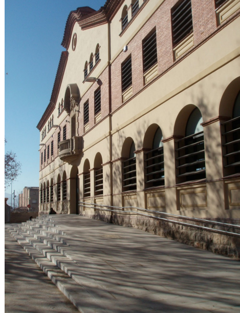
FOTO 2 Detall de la façana de l'edifici
