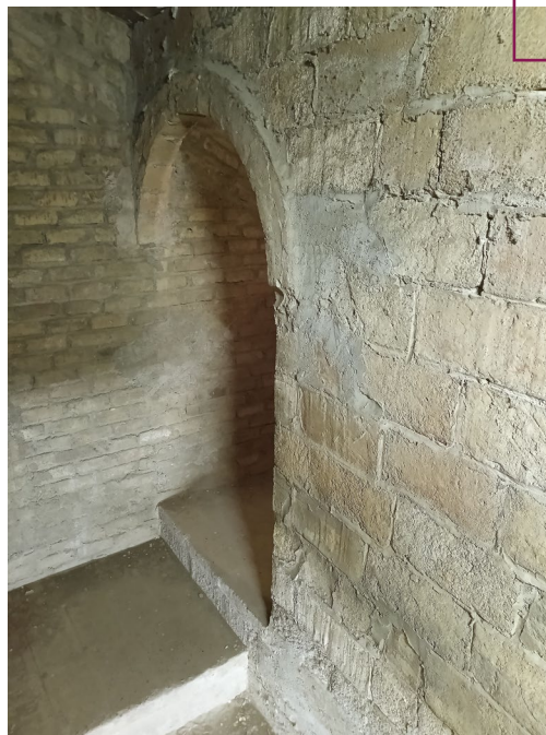
FOTO 6 Espai sota coberta
