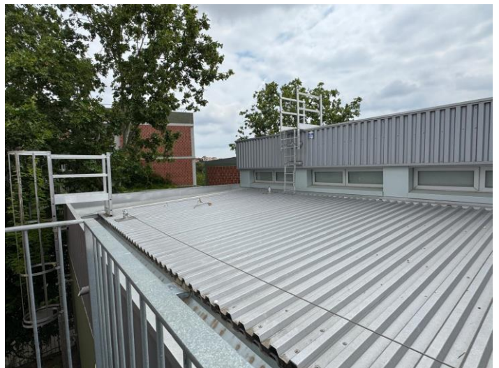
FOTO 8 Coberta d'edifici del gimnàs.
