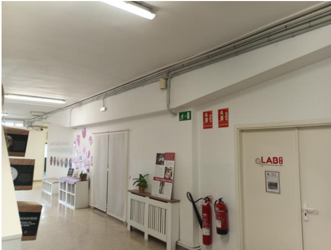
FOTO 5 Detall de l'interior de l'edifici principal, nivell de planta baixa on s'observen els pilars i les jàsseres de cantell
