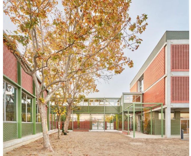
FOTO 2 Edifici de l'institut Badia Margarit i al pasera que connecta l'edifici de l'escola
