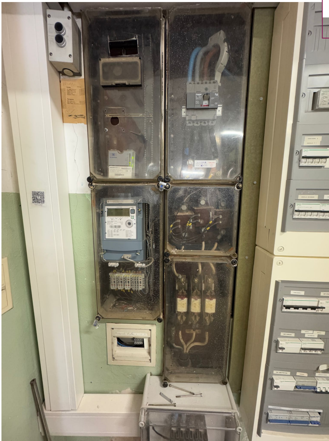
Imatge 19: TMF10 de consum actual situada a l'interior del centre educatiu
