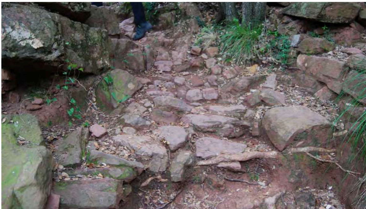
Fragment de paviment de blocs de pedra. 9/OCT/2024 (E. Píriz).
