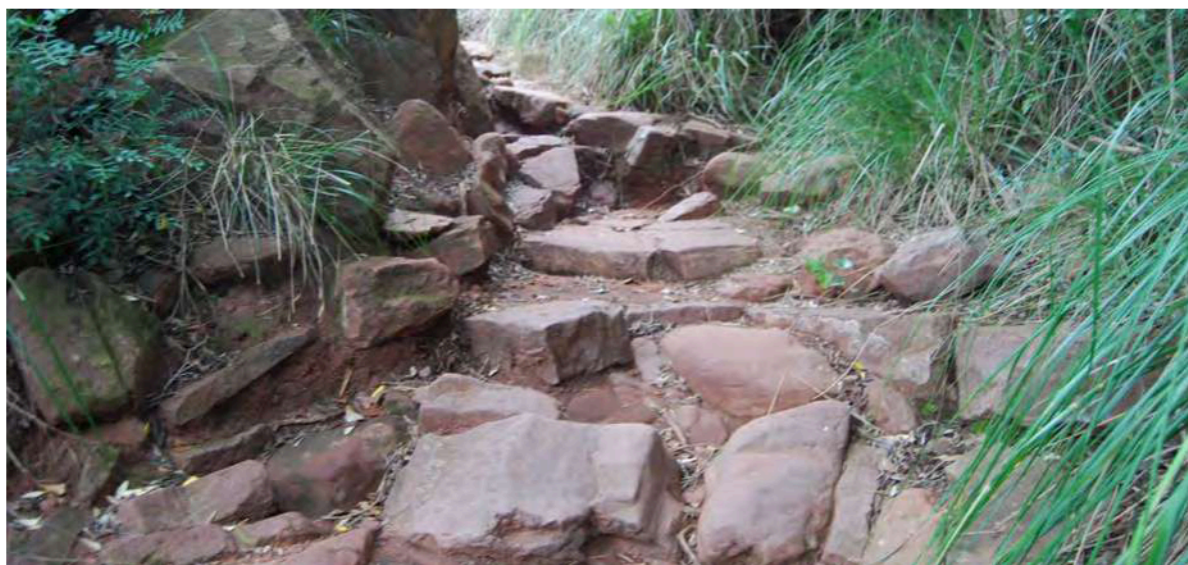
Fragment de paviment de blocs de pedra. 9/OCT/2024 (E. Píriz).
