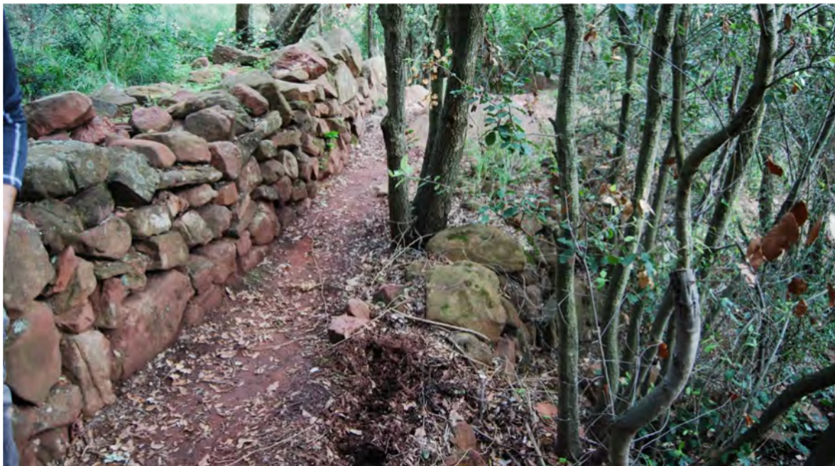
Detall del mur de gran secció i del camí format per una subestructura de pedra. 9/OCT/2024 (E. Píriz).
