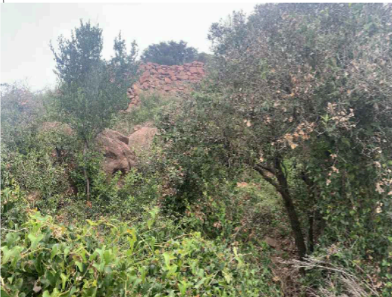
Contrafort vist des del Tram 4B.4 Font: Roger Guitart i Domingo
