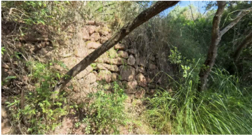
1. Mur de pedra Font: Sphere (CAPTAE)
