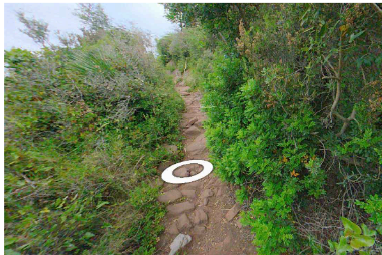
3. Restes de paviment de pedra Font: Sphere (CAPATE)
