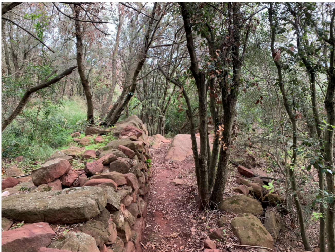
Mur de gran secció i estructura inferior de pedra Font: Roger Guitart i Domingo
