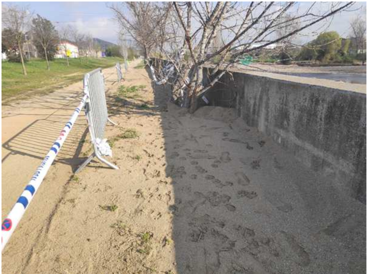
Imatge d'una part de l'esvoranc al camí fluvial. A prop es trobava el col·lector d'aigües residuals i la canonada de regenerada
