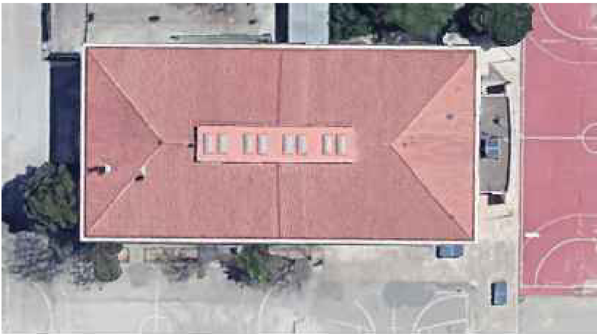
Imatge 1: Teulada a instal·lar línia de vida
