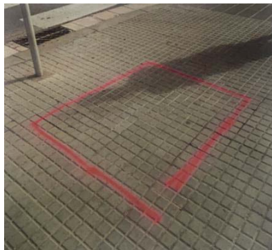
ENSAYO PERMEABILIDAD EN ZANJA
