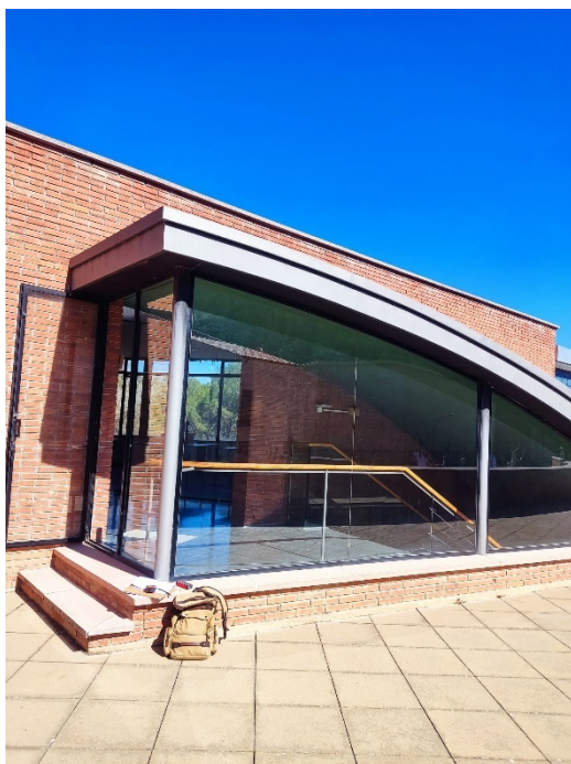
Accés a coberta
