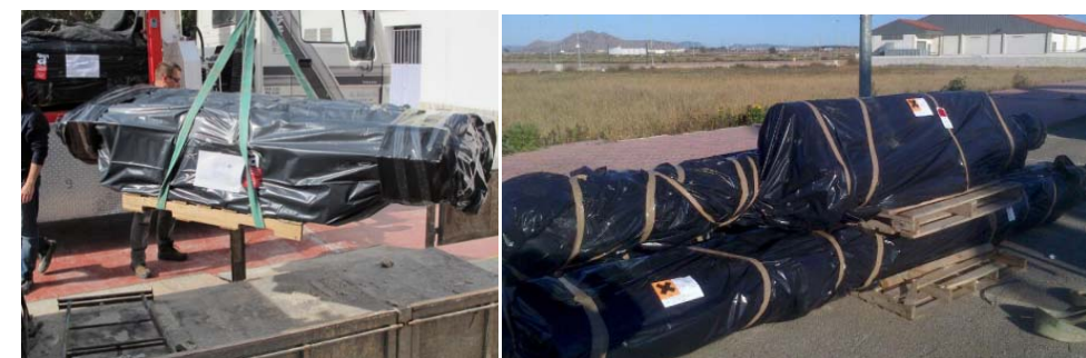
Exemple d'emmagatzematge temporal de tubs de fibrociment
