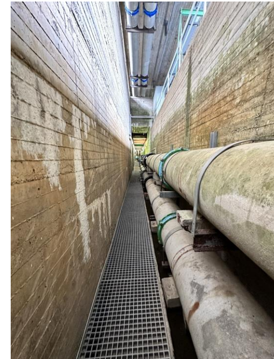
Imatge de les canonades d'aigua de rentat
