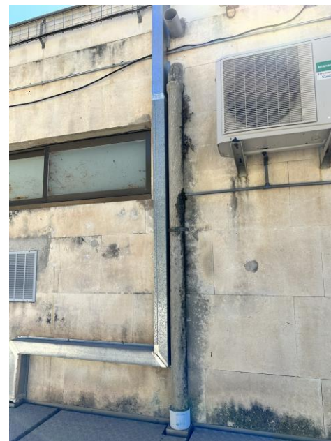
Imatge general de la part posterior de l'edifici on es troben els tubs de fibrociment
