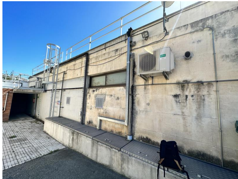
Imatge general de la part posterior de l'edifici on es troben els tubs de fibrociment
