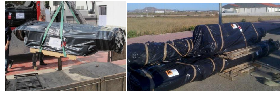
Exemple d'emmagatzematge temporal de tubs de fibrociment
