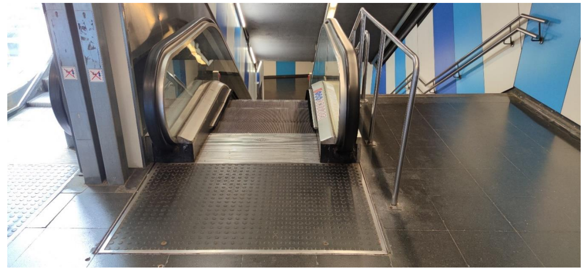
Imatge 87. Fossat de l'embarcament superior de les escales E5 de l'estació Ciutadella de línia 4
