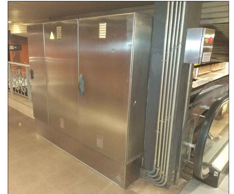
ACABATS DE QUADRE TIPUS ESCALA MECÀNICA I ENTRADA TUBS METÀL·LICS ESCALA: S/E
