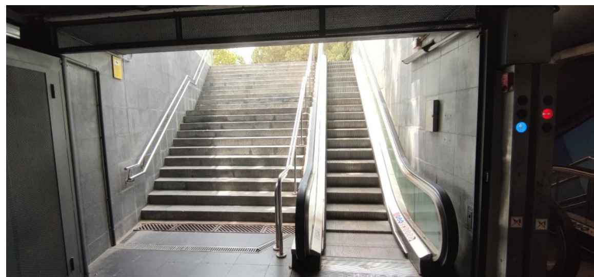
Imatge 89. Part inferior de les escales E6 de l'estació Ciutadella de línia 4
