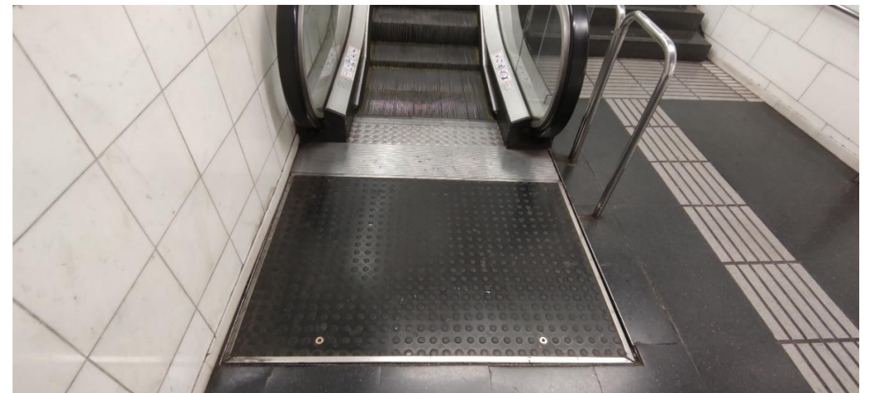
Imatge 21. Fossat de l'embarcament inferior de les escales E2 de l'estació Fondo de línia 1
