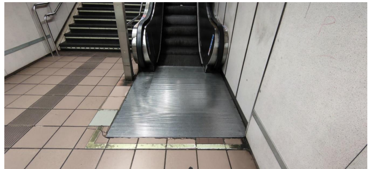
Imatge 63. Fossat de l'embarcament inferior de les escales E1 de l'estació Fontana de línia 3
