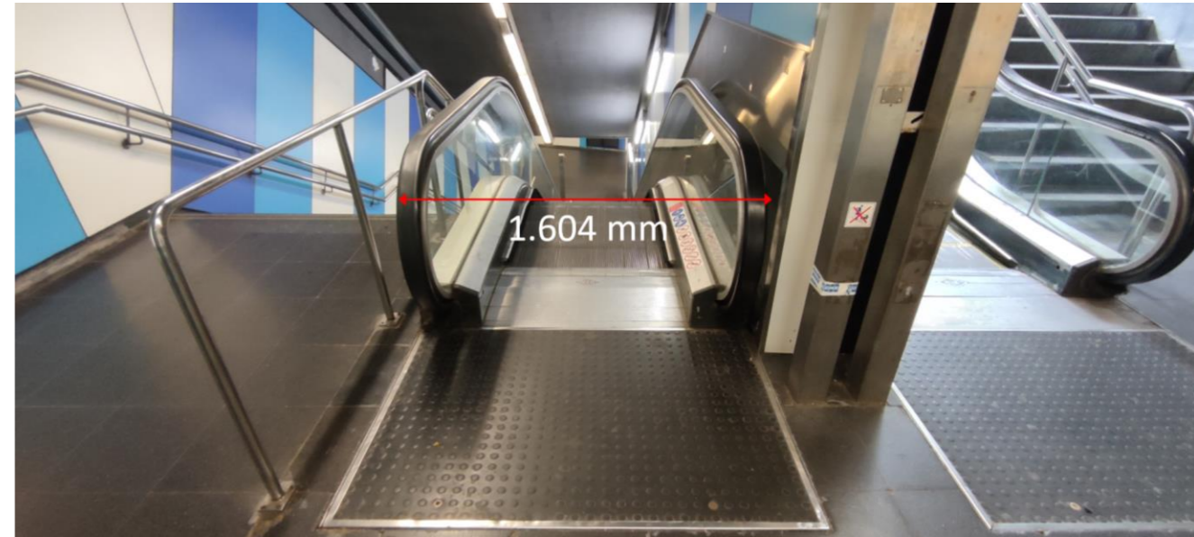
Il·lustració 49. Part superior de les escales E3 de l'estació Ciutadella de línia 4
