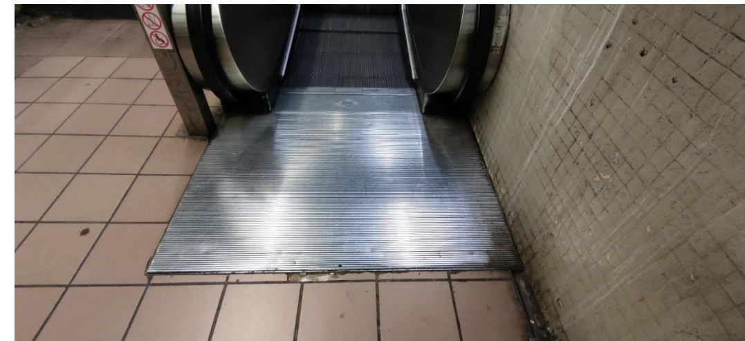
Imatge 51. Fossat de l'embarcament inferior de les escales E1 de l'estació Lesseps de línia 3
