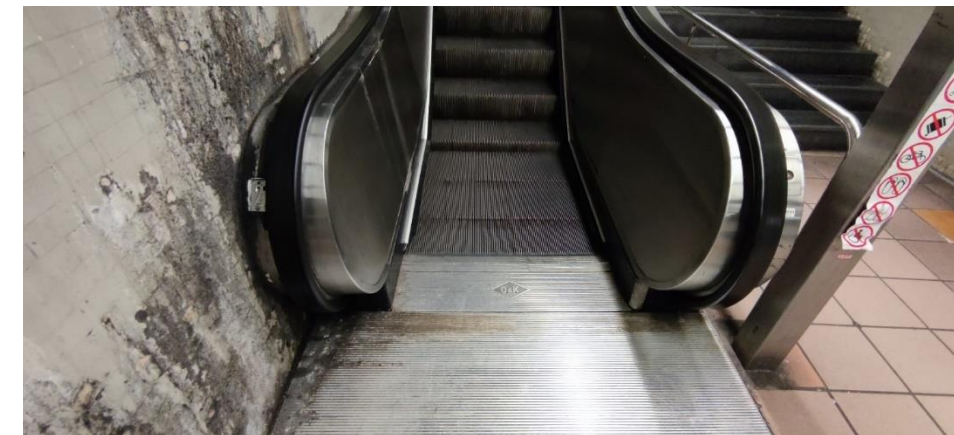
Imatge 57. Fossat de l'embarcament inferior de les escales E2 de l'estació Lesseps de línia 3
