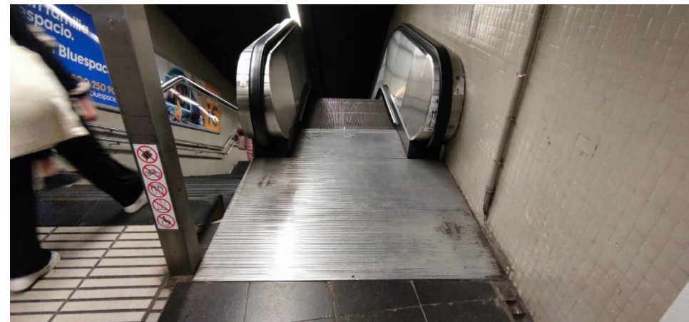
Imatge 60. Fossat de l'embarcament superior de les escales E2 de l'estació Lesseps de línia 3
