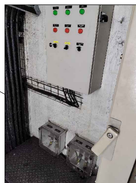
UBICACIÓ DE NOU ARMARI P-9. AMB DESPLAÇAMENT PREVI DE CAIXES DE SECCIONAMENT DE TERRES I ARMARI DE BOMBES
