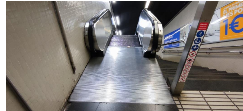
Imatge 54. Fossat de l'embarcament superior de les escales E1 de l'estació Lesseps de línia 3
