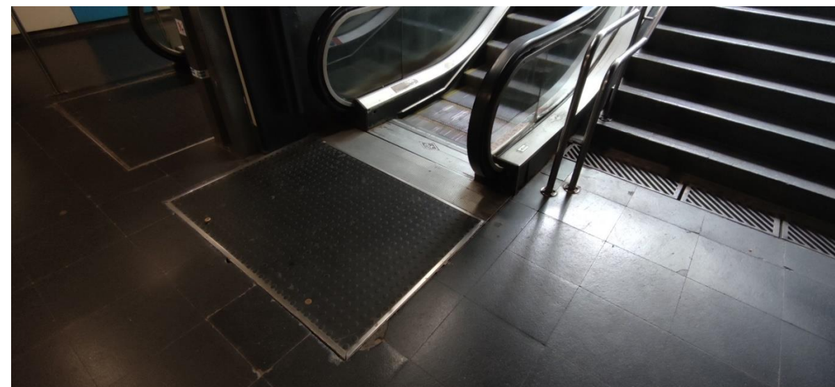
Imatge 78. Fossat de l'embarcament inferior de les escales E4 de l'estació Ciutadella de línia 4
