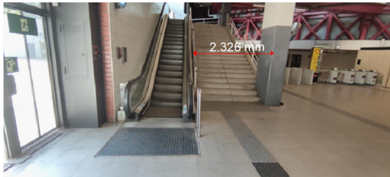
Il·lustració 2. Part inferior de les escales E2 de l'estació Trinitat Vella de línia 1
