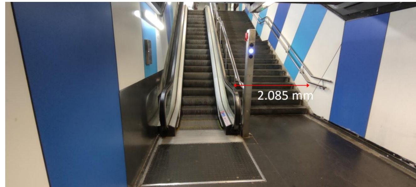
Il·lustració 50. Part inferior de les escales E3 de l'estació Ciutadella de línia 4
