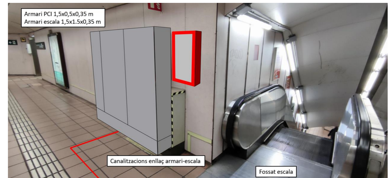
Il·lustració 48. Ubicació del nou quadre de les escales E2 de l'estació Fontana de línia 3. Es mostra també la nova ubicació de l'extintor.
