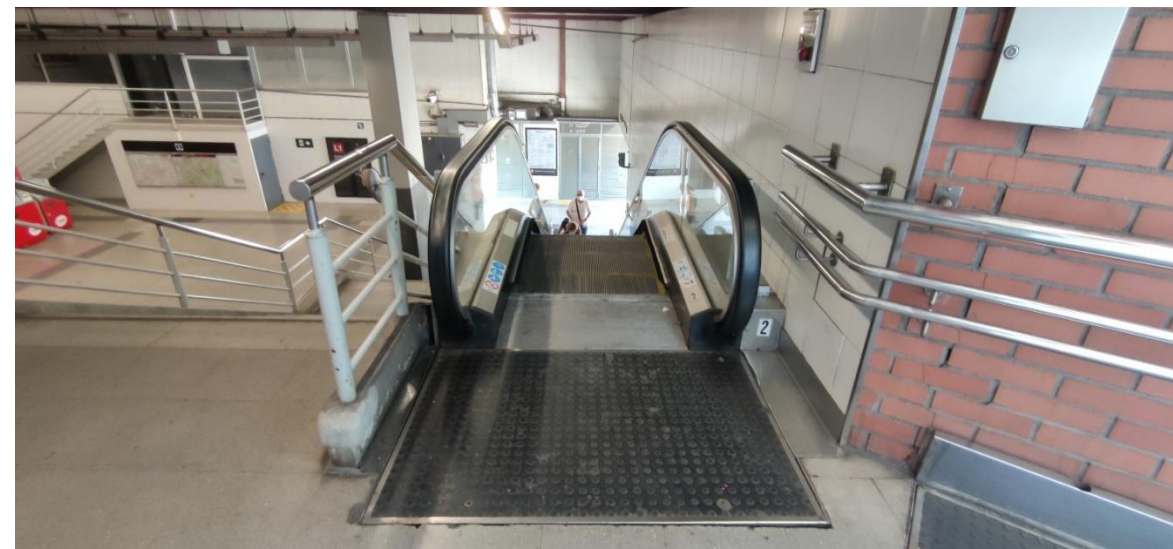
Imatge 6. Fossat de l'embarcament superior de les escales E2 de l'estació Trinitat Vella de línia 1
