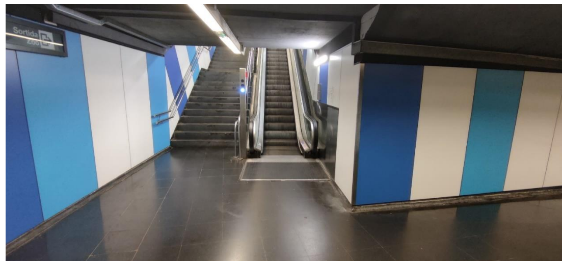
Imatge 83. Part inferior de les escales E5 de l'estació Ciutadella de línia 4
