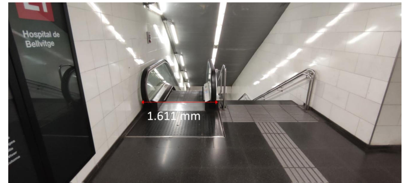
Il·lustració 17. Part superior de les escales E3 de l'estació Fondo de línia 1
