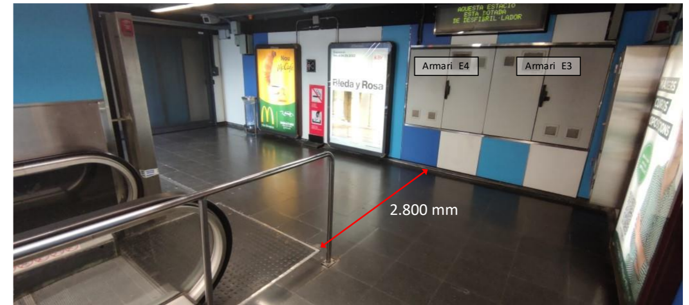
Il·lustració 51. Ubicació del quadre existent i distància fins al fossat superior de les escales E3 de l'estació Ciutadella de línia 4
