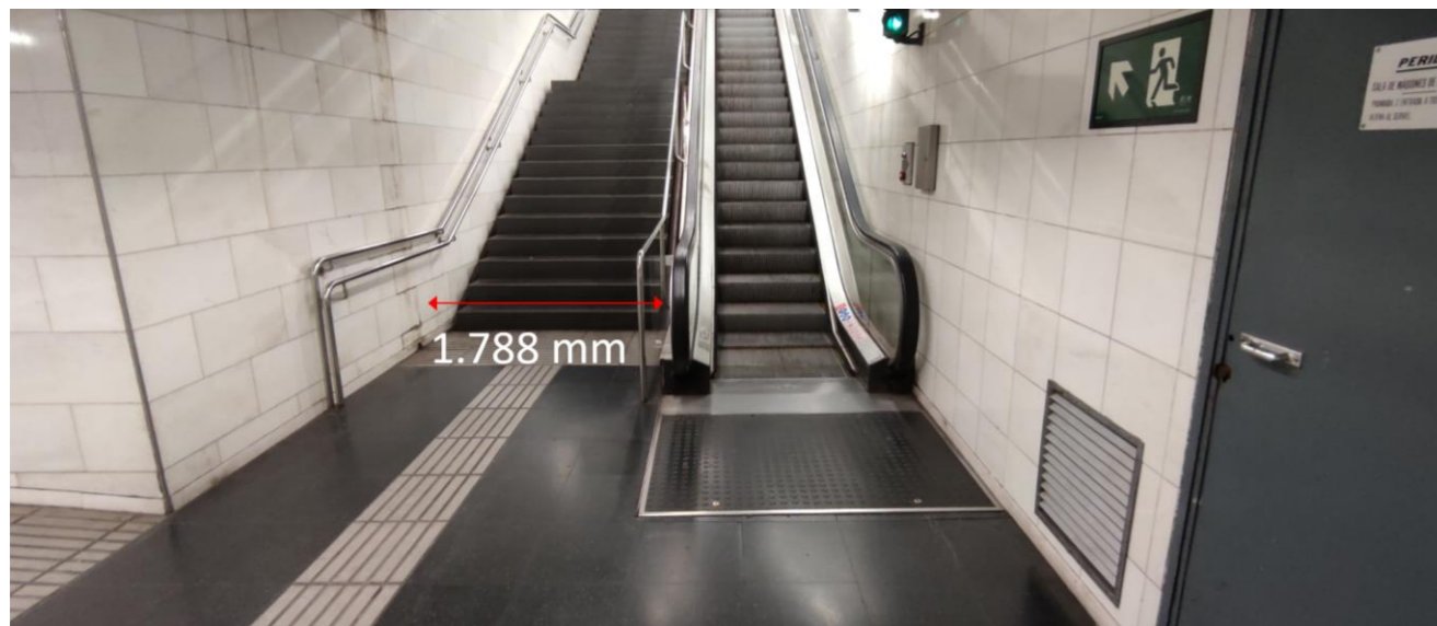
Il·lustració 18. Part inferior de les escales E3 de l'estació Fondo de línia 1
