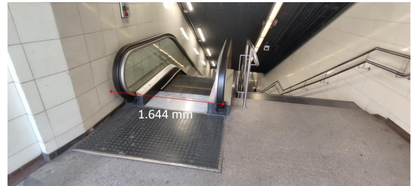
Il·lustració 21. Part superior de les escales E6 de l'estació Fondo de línia 1
