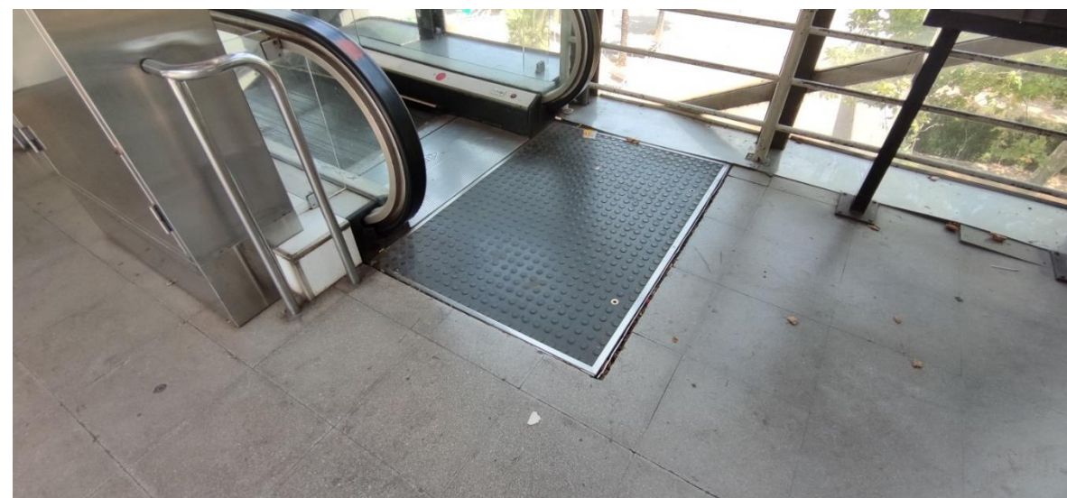
Imatge 12. Fossat de l'embarcament superior de les escales E3 de l'estació Trinitat Vella de línia 1.
