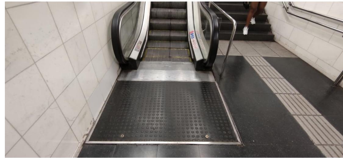
Imatge 15. Fossat de l'embarcament inferior de les escales E1 de l'estació Fondo de línia 1
