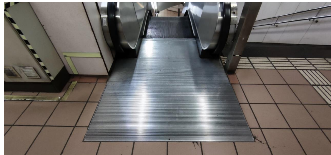
Imatge 72. Fossat de l'embarcament superior de les escales E2 de l'estació Fontana de línia 3
