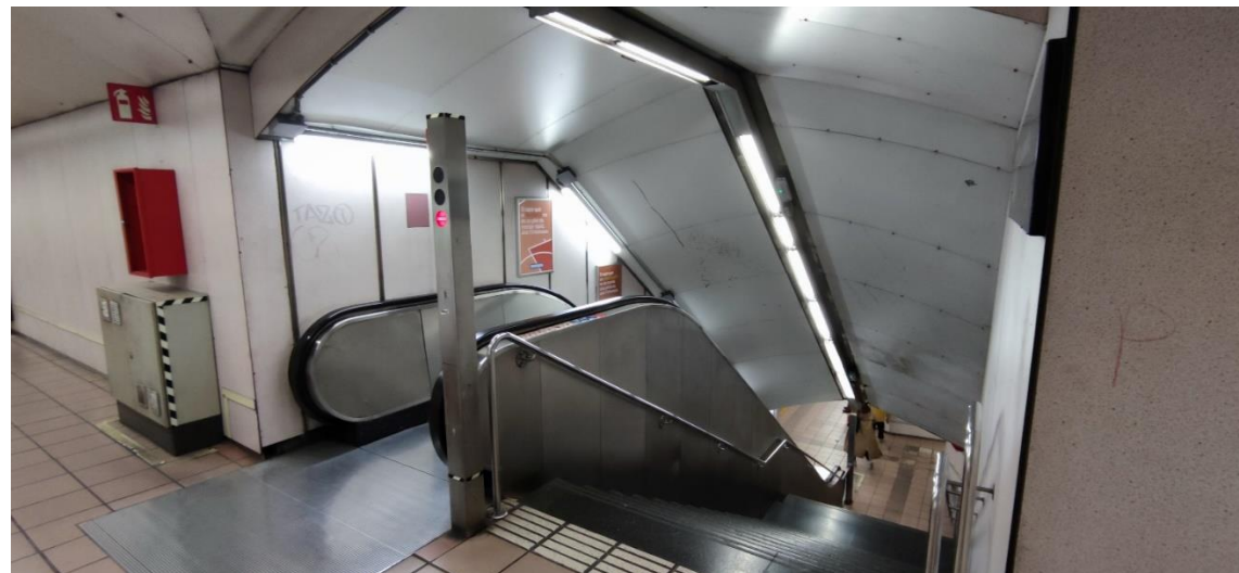
Imatge 71. Part superior de les escales E2 de l'estació Fontana de línia 3
