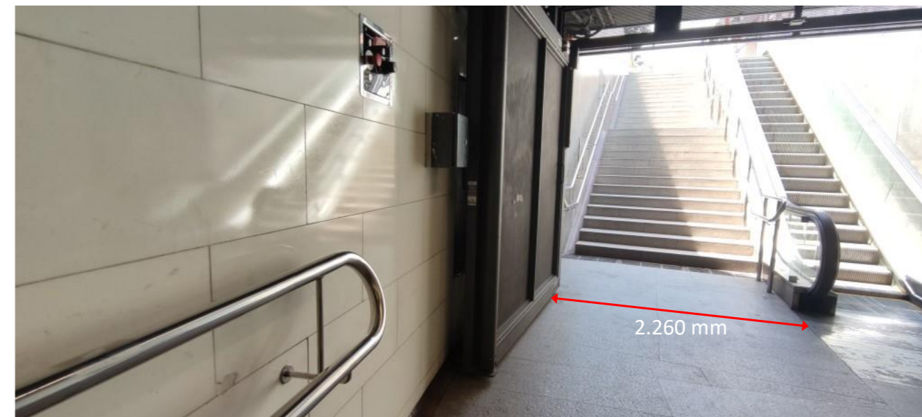
Il·lustració 27. Ubicació del quadre existent i distància fins al fossat inferior de les escales E7 de l'estació Fondo de línia 1
