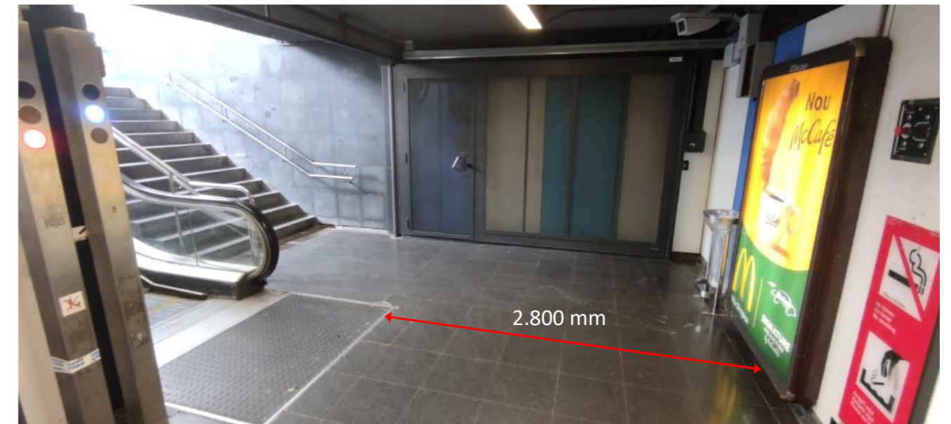
Il·lustració 55. Distància fins al fossat inferior de les escales E4 de l'estació Ciutadella de línia 4
