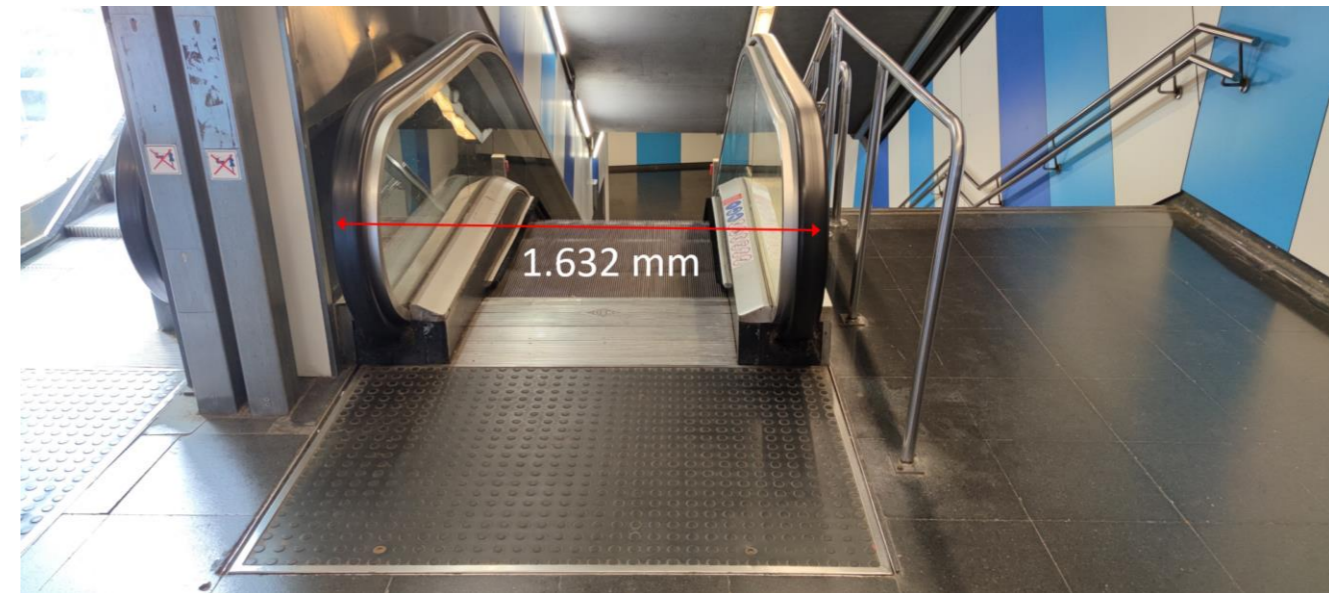
Il·lustració 57. Part superior de les escales E5 de l'estació Ciutadella de línia 4
