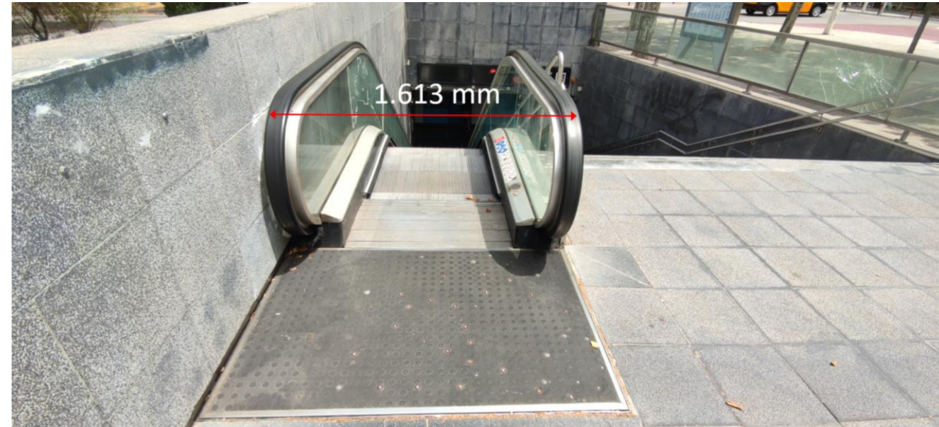
Il·lustració 61. Part superior de les escales E6 de l'estació Ciutadella de línia 4
