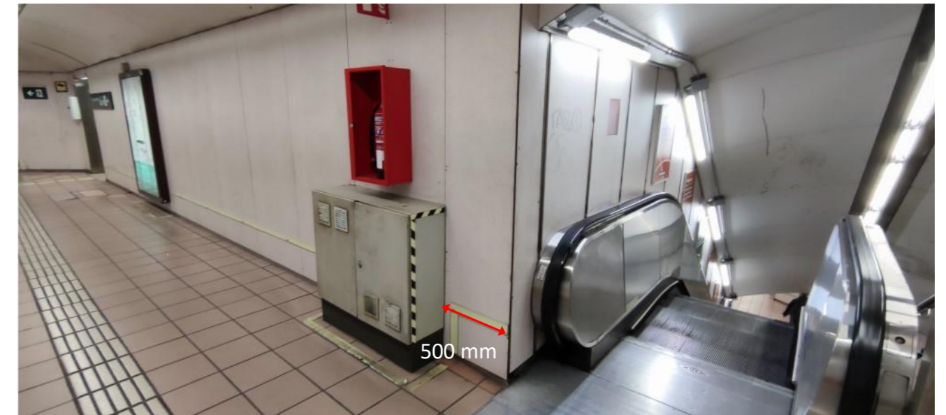
Il·lustració 47. Ubicació del quadre existent i distància fins al fossat superior de les escales E2 de l'estació Fontana de línia 3
