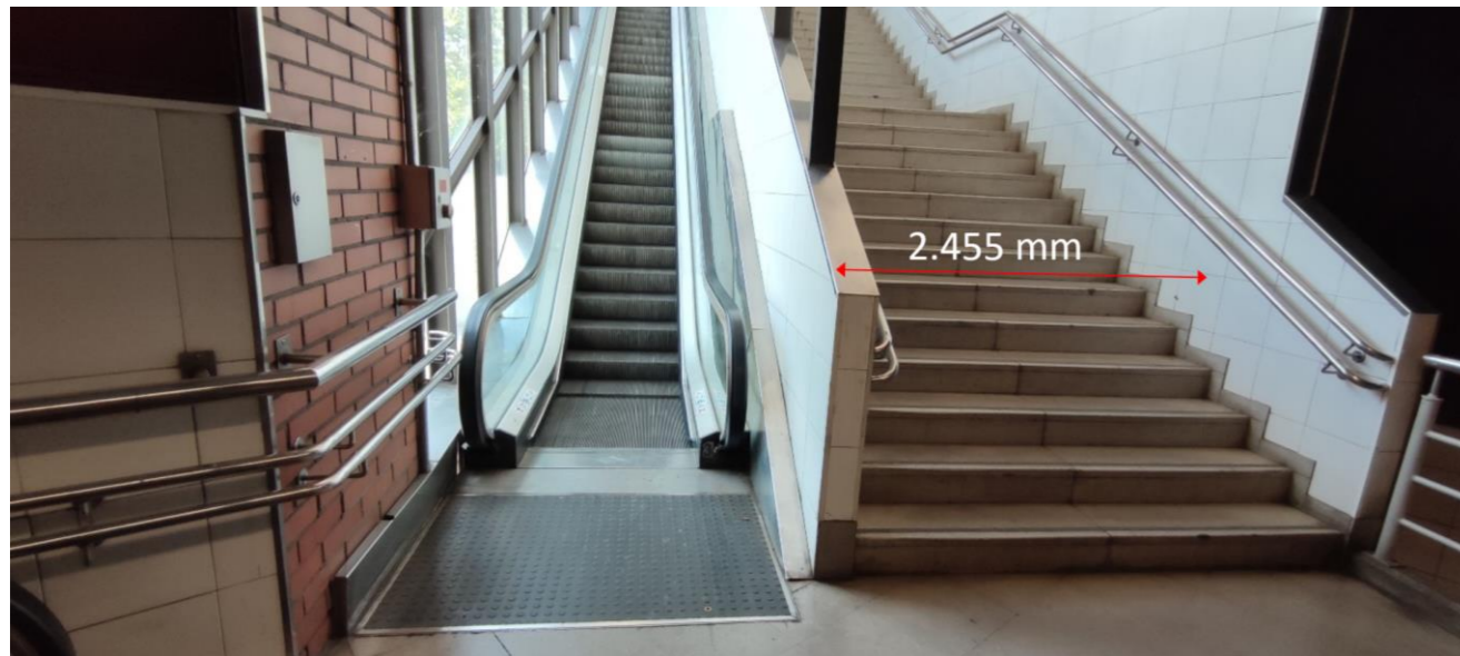
Il·lustració 6. Part inferior de les escales E3 de l'estació Trinitat Vella de línia 1
