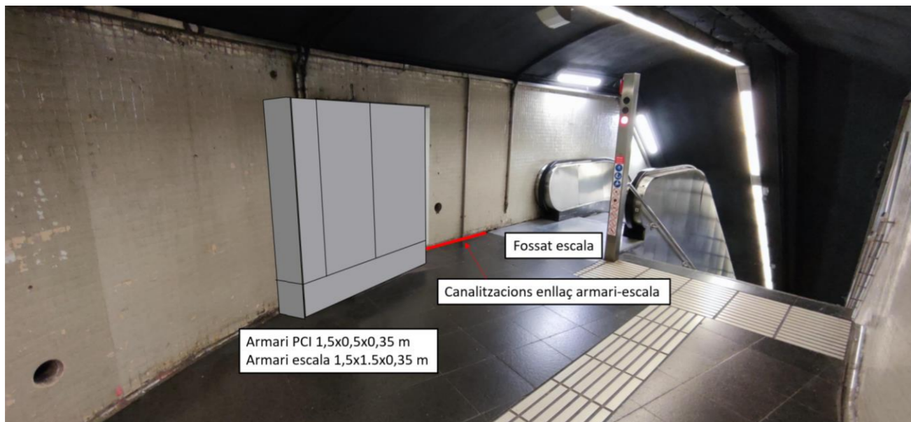
Il·lustració 35. Ubicació del nou quadre de les escales E1 de l'estació Lesseps de línia 3
