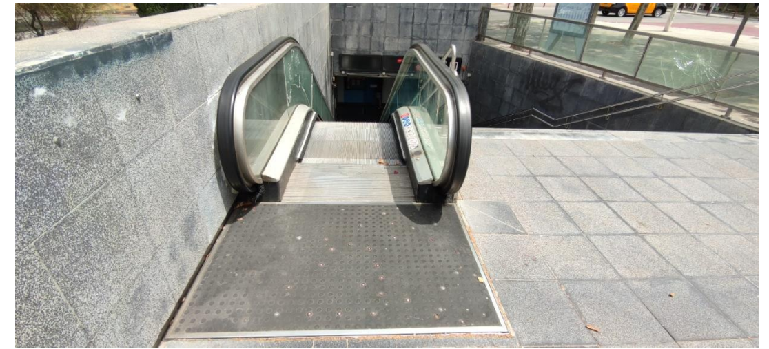
Imatge 93. Fossat de l'embarcament superior de les escales E6 de l'estació Ciutadella de línia 4
