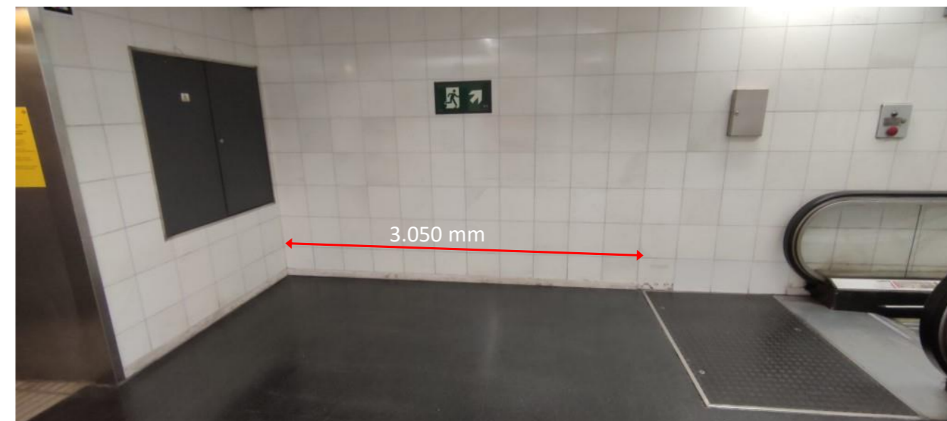
Il·lustració 11. Ubicació del quadre existent i distància fins al fossat inferior de les escales E1 de l'estació Fondo de línia 1
