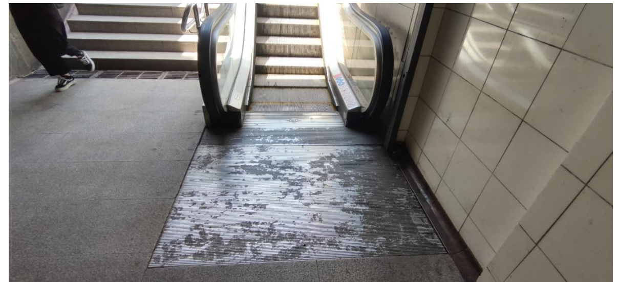
Imatge 39. Fossat de l'embarcament inferior de les escales E7 de l'estació Fondo de línia 1
