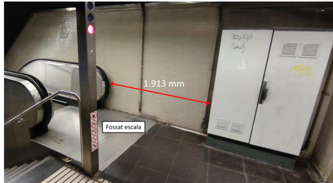
Il·lustració 38. Ubicació del quadre existent i distància fins a la part superior de la barana de les escales E2 de l'estació Lesseps de línia 3
