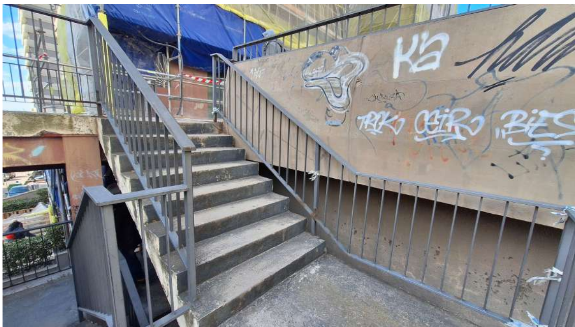
Imatge general de l'escala de l'accés nord de la passera.
