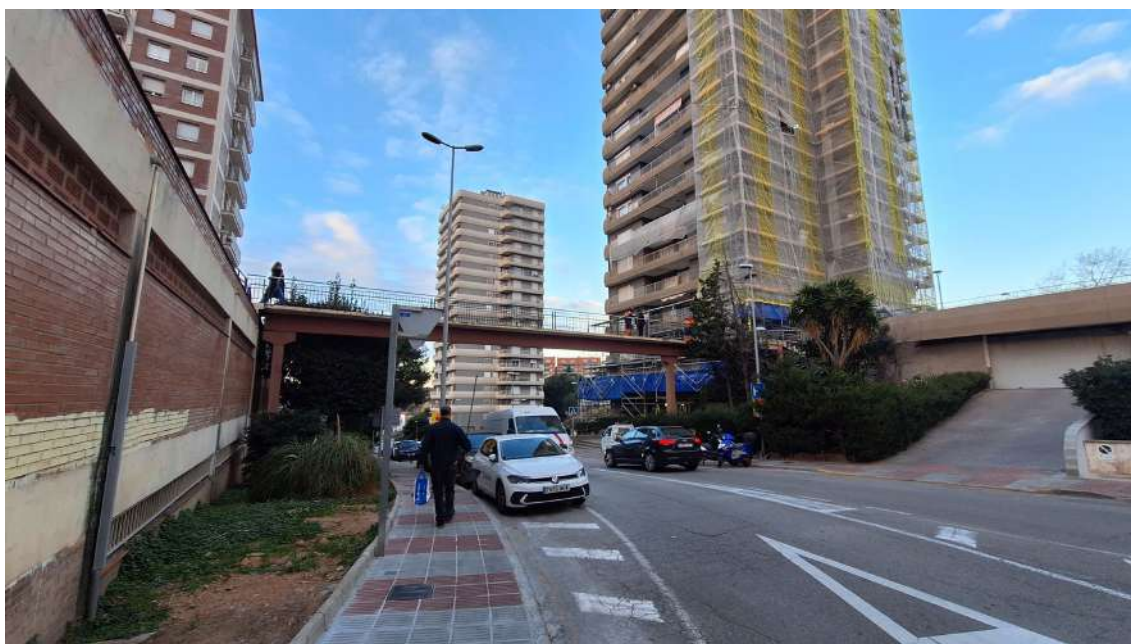
Imatge general de la passera de vianants sobre l'avinguda del Turó.
