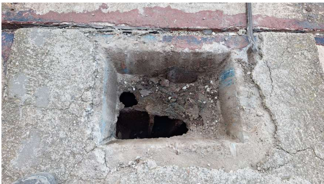
Imatge de la cala realitzada a sobre del taulell de formigó
