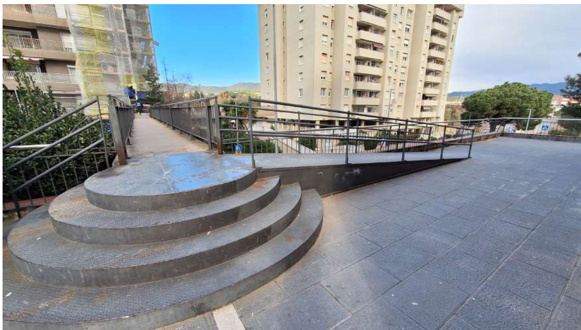
Imatge general de l'escala i rampa de l'accés sud de la passera.
