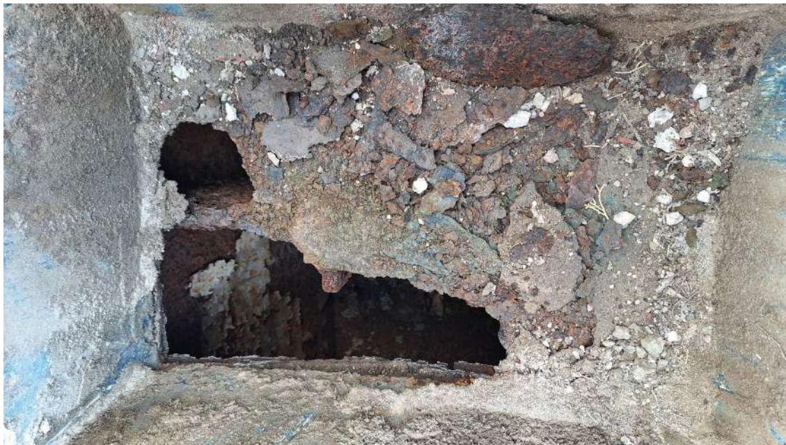
Imatge de l'estat extern de la xapa superior de la biga
