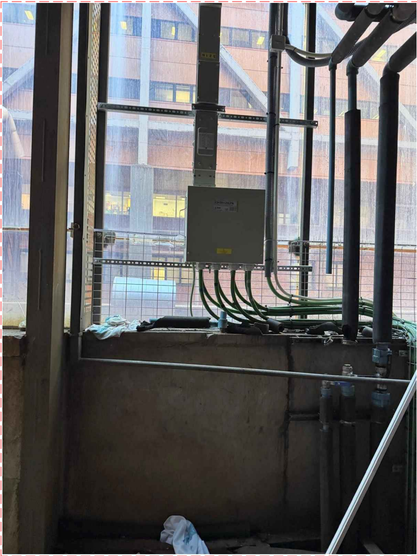
EXEMPLE DETALL CONEXIÓ SAFATA-CABLE AMB BLINDO
