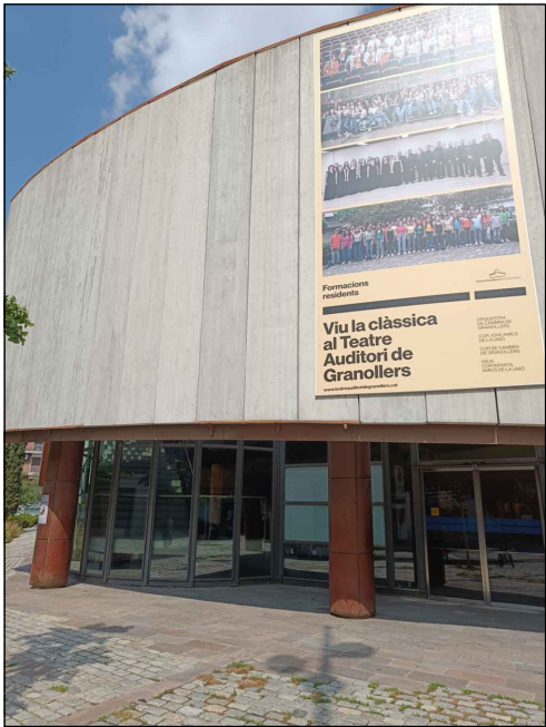
F1 - FAÇANA DES DE CARRER JOSEP TORRES I BAGES
