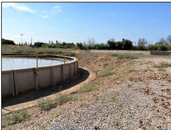
Vista del talús del decantador secundari on es preveu la construcció d'un muret de contenció de terres
