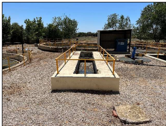
Vista d'arquetes en mal estat on les tapes s'han oxidat, es substituiran per tapes de PRFV
