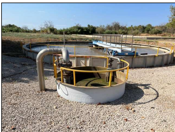
Vista de les arquetes de recirculació, purga i drenatges a instal·lar sistema d'elevació
