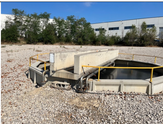
Foto Núm. 17 Espesidor de fangs
