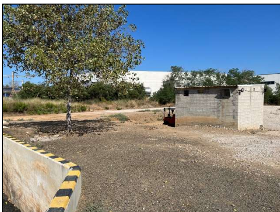
Vista de la zona on es construirà el nou cobert metàl·lic diàfan on es col·locaran les centrífugues
