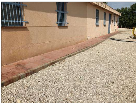
Vista de la façana de la part davantera de l'edifici de control a sanejar i pintar
