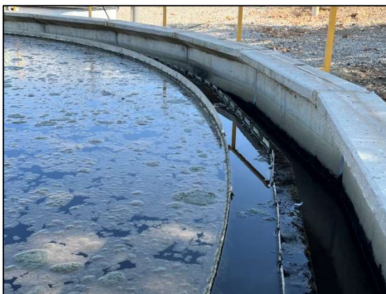
Vista del vessador tipus Thompson del perímetre del decantador secundari a substituir
