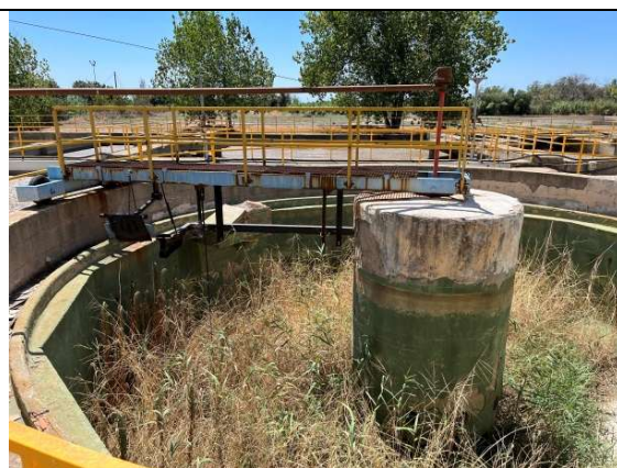
Vista decantador primari línia antiga a reparar
