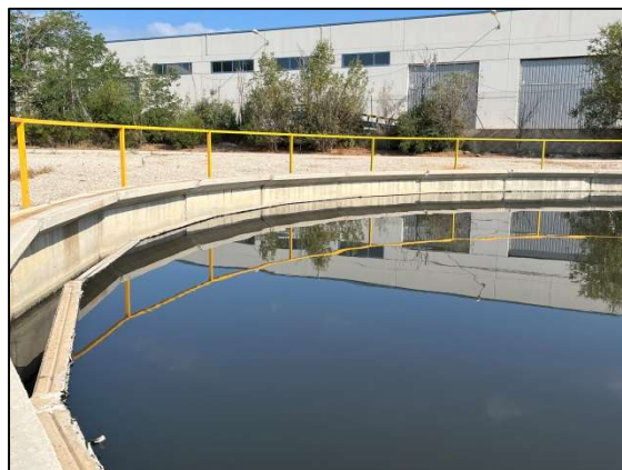
Vista del perímetre del decantador primari on s'ha d'instal·lar un vessador tipus Thompson
