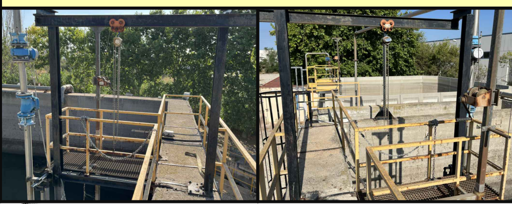
AMPLIACIÓ DE LA PLATAFORMA EXISTENT PER INSTAL·LACIÓ D'UN SISTEMA D'ELEVACIÓ I EXTRACCIÓ DE L'AGITADOR SUBMERGIT DEL DIPÒSIT D'HOMOGENITZACIÓ 2
