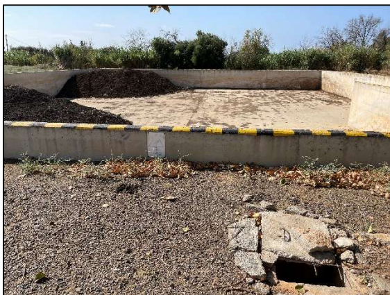
Vista d'arquetes en mal estat on les tapes s'han oxidat, es substituiran per tapes de PRFV
