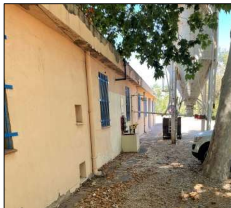
Vista de la façana de la part posterior de l'edifici de control a sanejar i pintar. Zona a protegir davant l'atac dels arrels dels arbres
