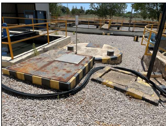
Vista d'arquetes en mal estat on les tapes s'han oxidat, es substituiran per tapes de PRFV
