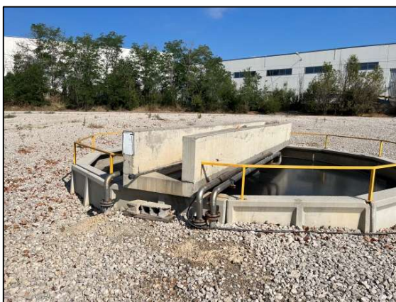
Vista de la passarel·la de l'espessidor a dotar d'accés amb la instal·lació d'una escala
