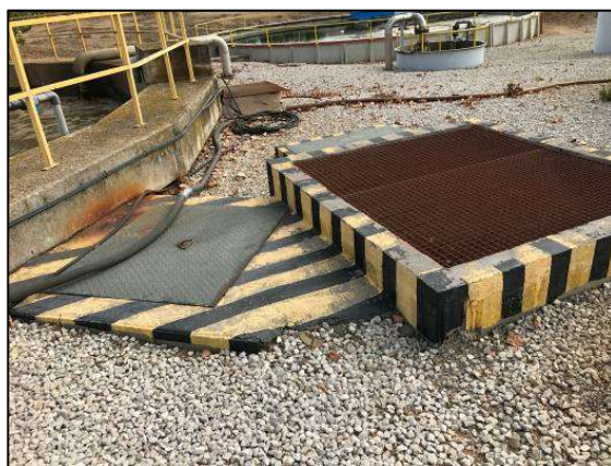
Vista d'arquetes en mal estat on les tapes s'han oxidat, es substituiran per tapes de PRFV
