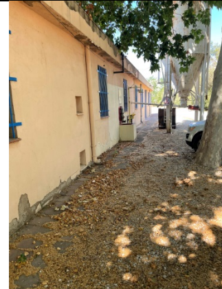
Foto Núm. 24 Façana posterior edifici control
