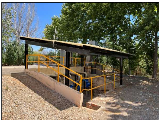
Vista de la zona de pretractament on es preveu la construcció d'unes escales
