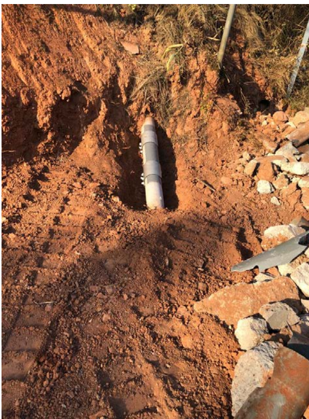
Fotografia 14. Canonada baixada dipòsit reparació
