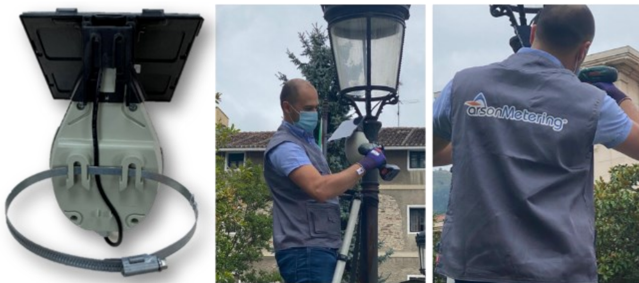
Imágenes de instalación de Gateways solares en ubicaciones del mobiliario urbano.
