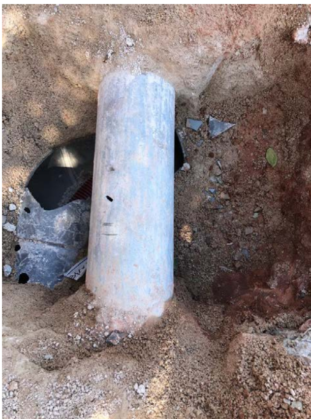
Fotografia 13. Canonada baixada dipòsit punxada
