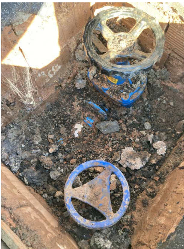
Fotografia 10. Arqueta maniobra entrada poble 200 FB i PE 50mm
