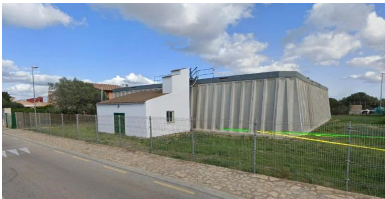
Imágenes de instalación de Gateways solares en los depósitos del servicio de aguas
