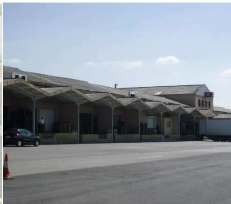
Façana Nord Edifici Mercavallès
