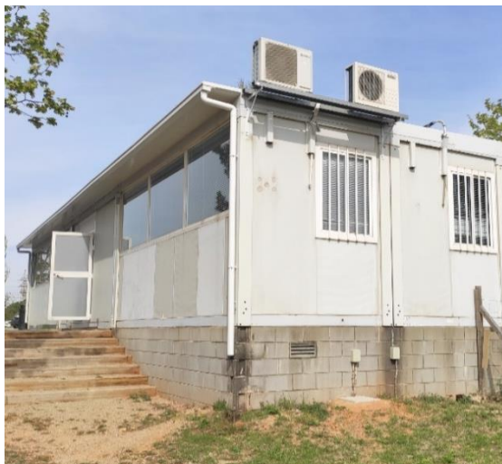
Façana Est Edifici La Mola
