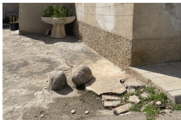
Erosió del sòl amb aflorament de base de paviment formigó
