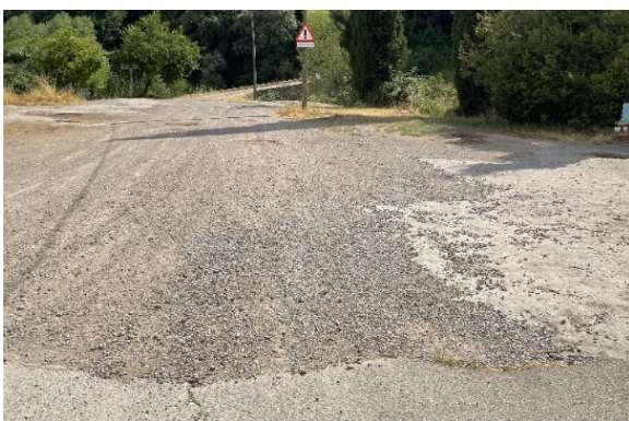
Erosió del sòl amb aflorament de paviment de roca natural a les vores
