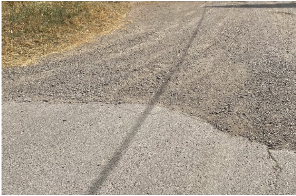
Paviment d'asfalt amb contacte amb paviment de formigó disgregat
