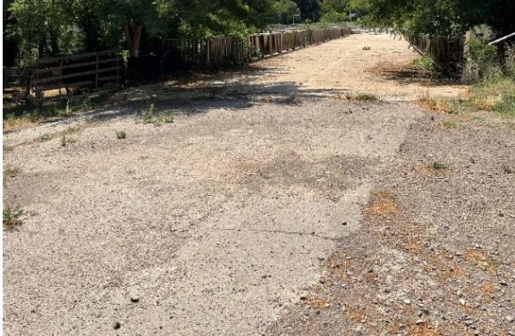
Erosió del sòl amb aparició de base de formigó preexistent
