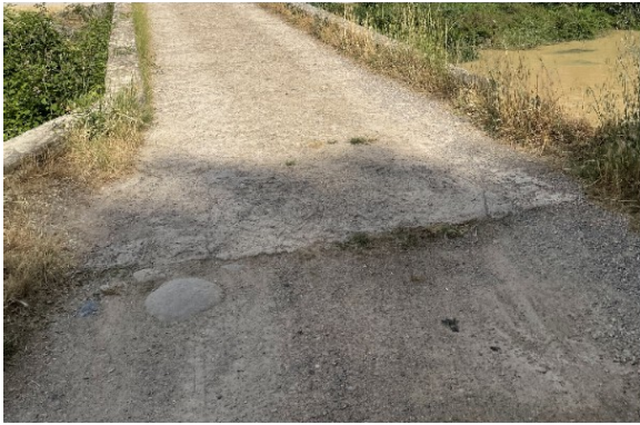
Paviment de formigó amb contacte amb terreny natural
