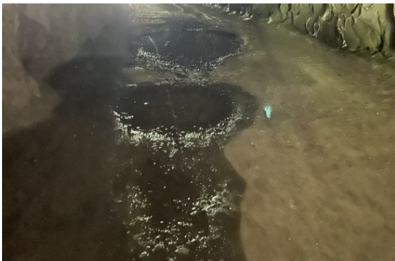
Erosió del sòl provocant baldons i reguerons a causa de l'aigua
