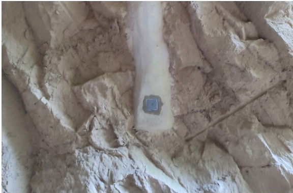
Polsador del sistema d'il·luminació a l'accés del túnel
