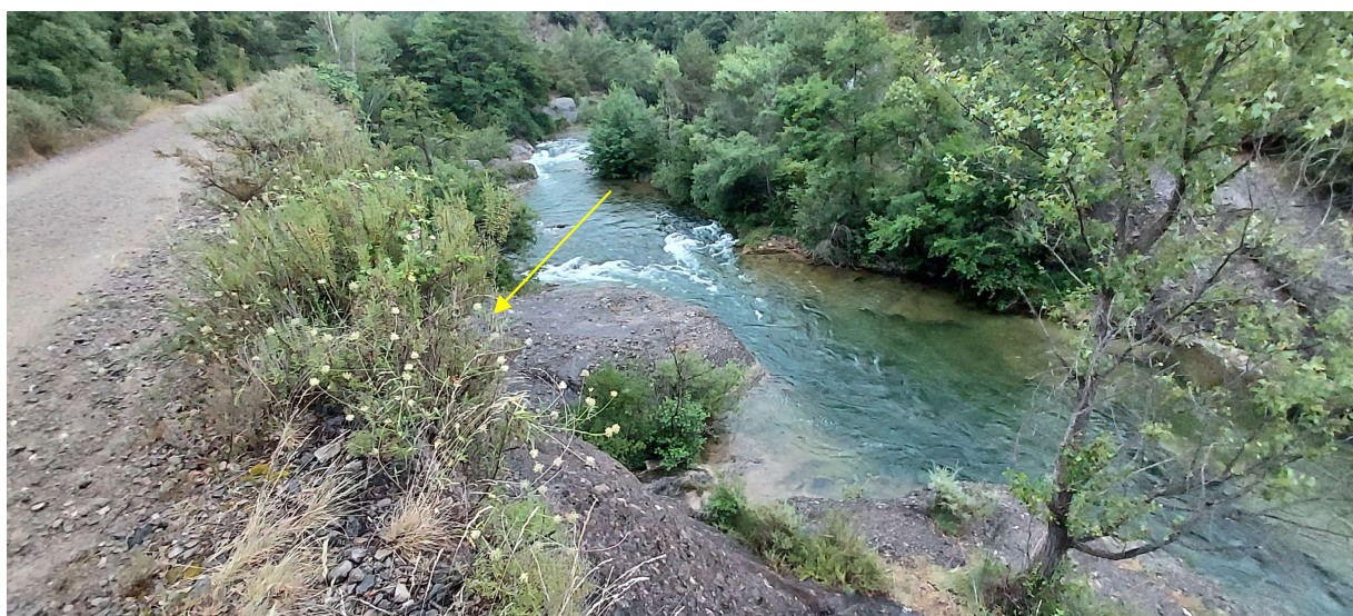
Vista del camí en la zona del PK aprox. 0+345 a 0+370 on el riu erosiona, en un suau meandre (fletxa), la zona de sota del camí, en aquest sector fet amb terres sobreposades (terraplè) sobre el rocam de conglomerats.
