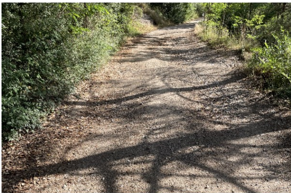
Erosió del sòl provocant baldons al llarg del camí
