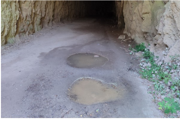
Baldó a l'entrada del túnel amb acumulació d'aigua estancada
