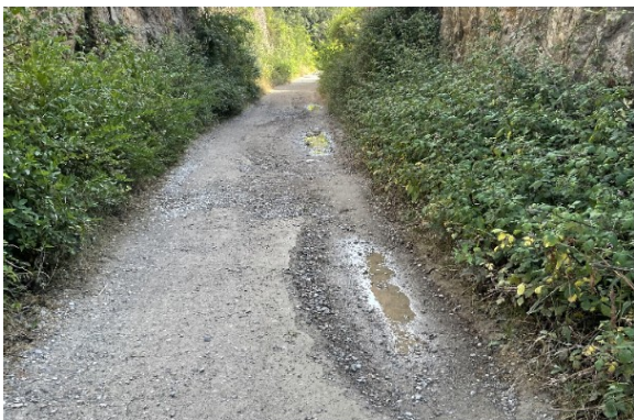
Erosió reiterada del sòl amb acumulació puntual d'aigua en les parts més profundes
