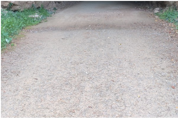
Erosió del sòl pronunciada provocant baldons a l'accés del túnel
