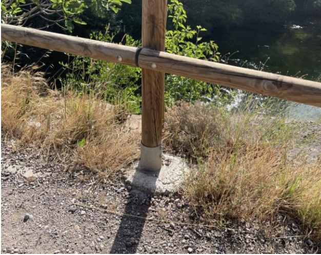
Fonamentació de barana de fusta al Mirador del Pont de Ferro (1)
