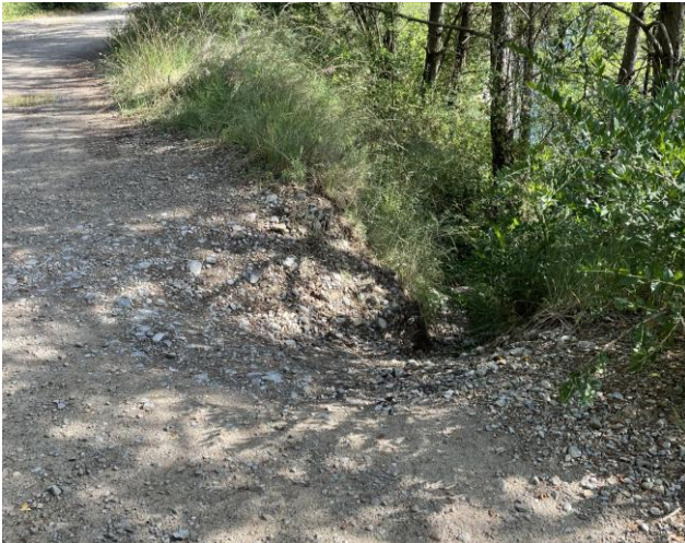
Erosió en el paviment que disminueix secció de camí
