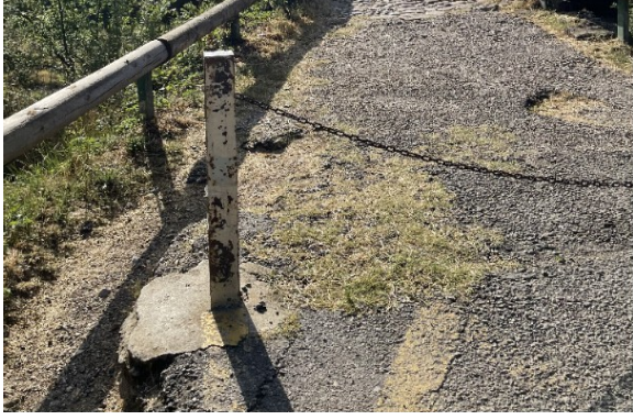
Erosió del sòl provocant afloració de fonamentació de l'element de la tanca metàl·lica
