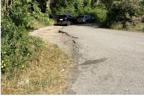
Erosió pronunciada del sòl amb desaparició parcial del mateix
