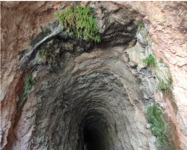
Filtracions d'aigua, creixement vegetal i aparició element invasiu (2)
