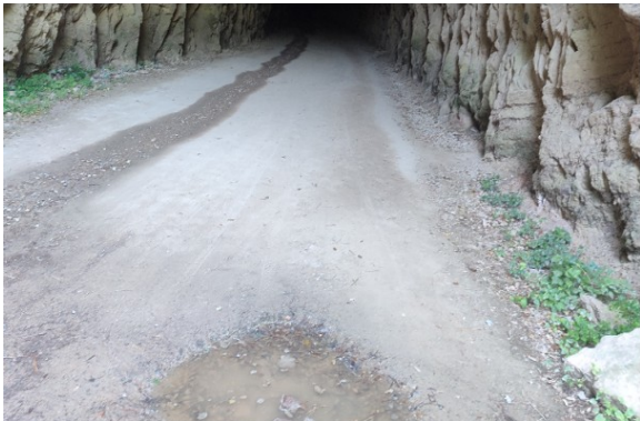
Reguerons al llarg de tot el túnel a causa de l'aigua
