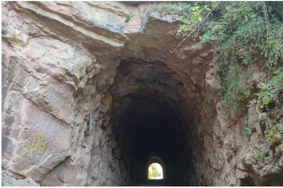
Falta d'il·luminació del túnel i morfologia pronunciada de la roca del túnel en un dels accessos
