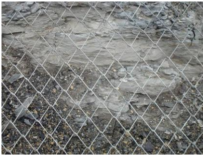
Exemple de malla de simple torsió
