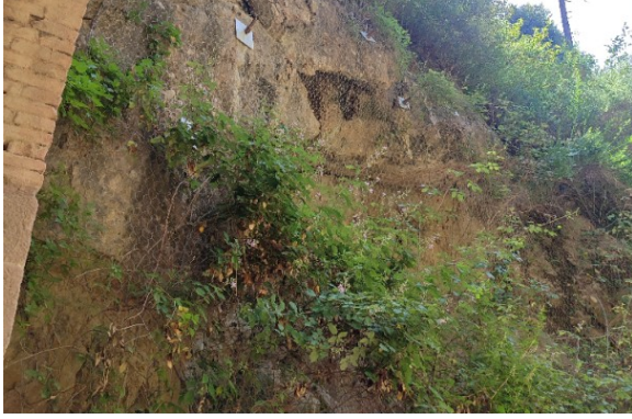
Zona amb risc de despenjaments tot i disposar d'una malla metàl·lica protectora de triple torsió
