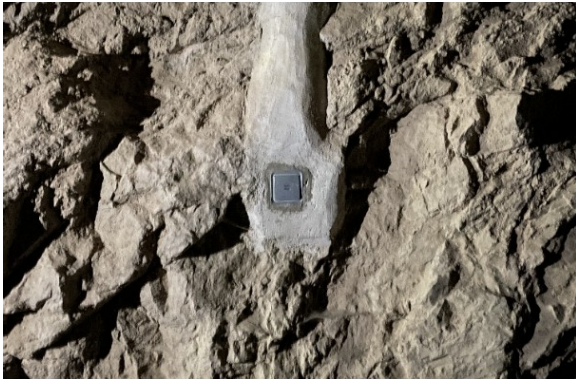
Polsador del sistema d'il·luminació a la zona mitja del túnel
