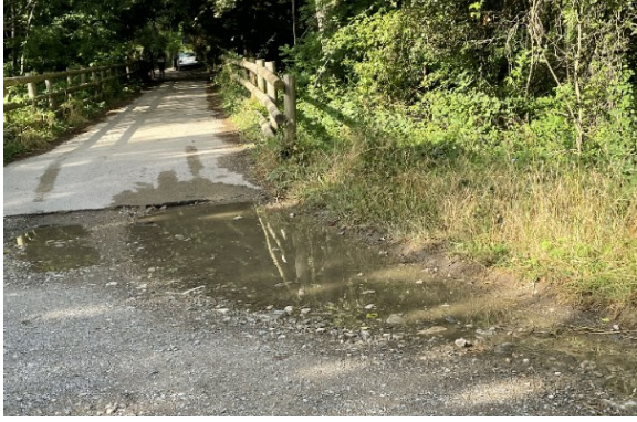
Erosió del sòl provocant baldons amb acumulació d'aigua
