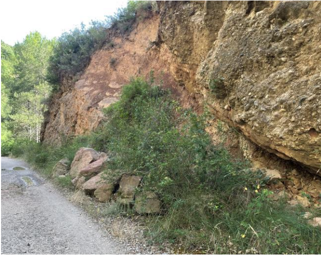
Esllavissada del talús vertical est
