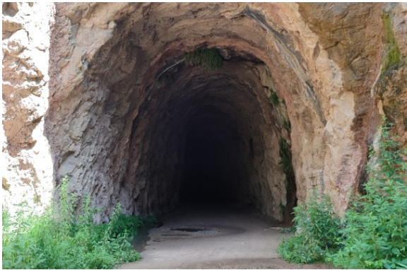
Accés túnel amb erosions del sòl i afloracions vegetals a les zones altes
