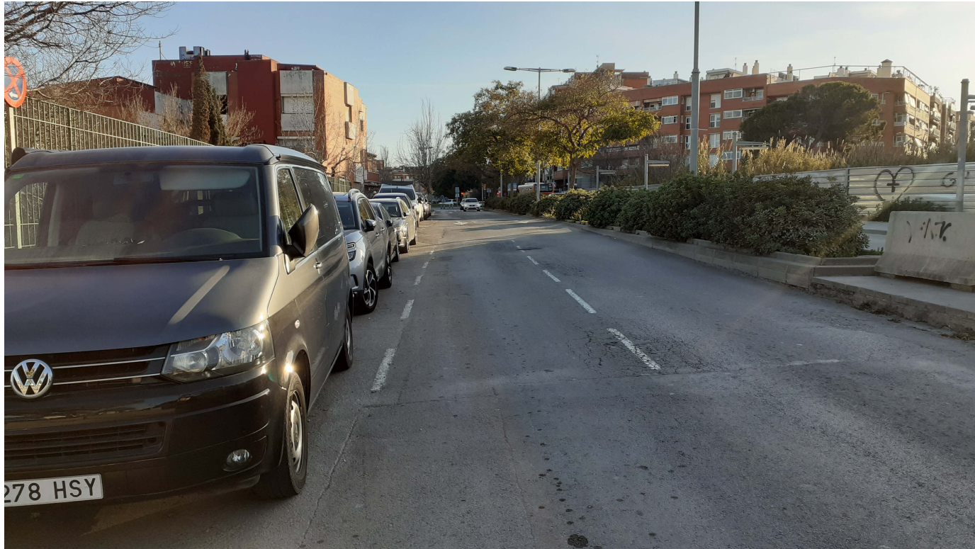
Calçada del carrer Bonaventura Calopa dins de l'àmbit, amb una banda d'estacionament en línia i calçada amb dos carrils i mitjana enjardinada i amb enllumenat.
