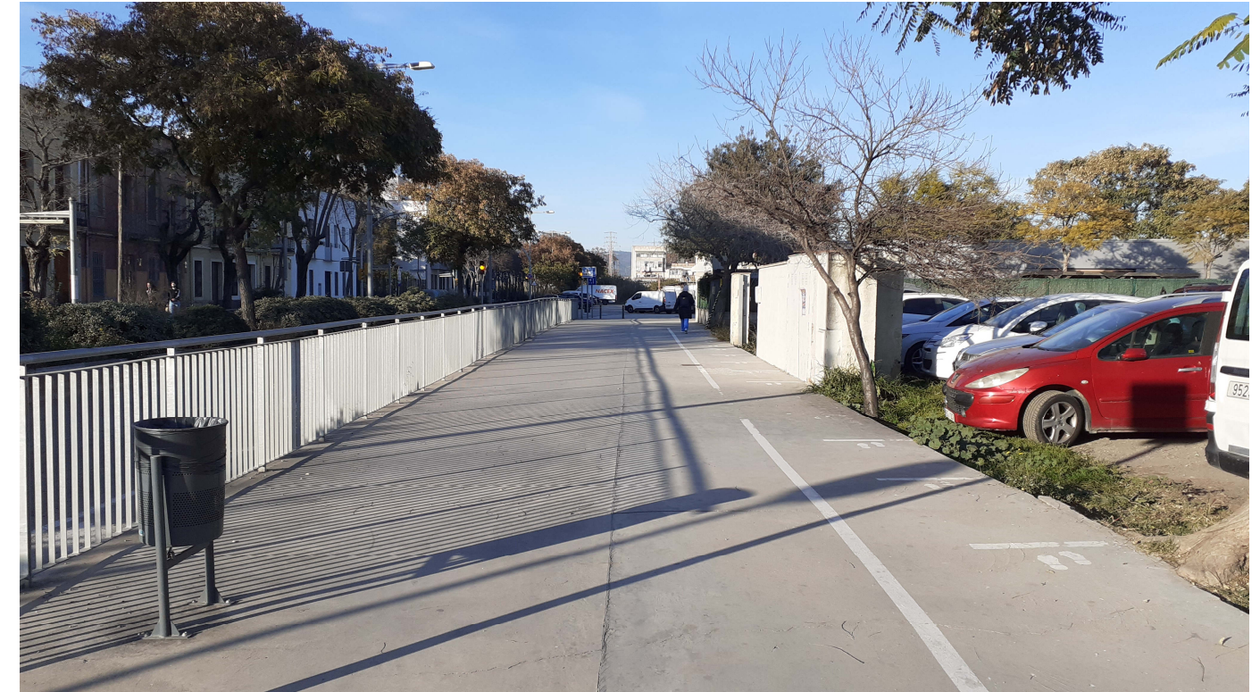
Zona de la vorera de paviment de formigó al solar d'estacionament i entorns de l'escola Bressol La Susa, amb protecció amb barana.
