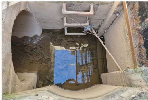
08. Comporta canal dreita
