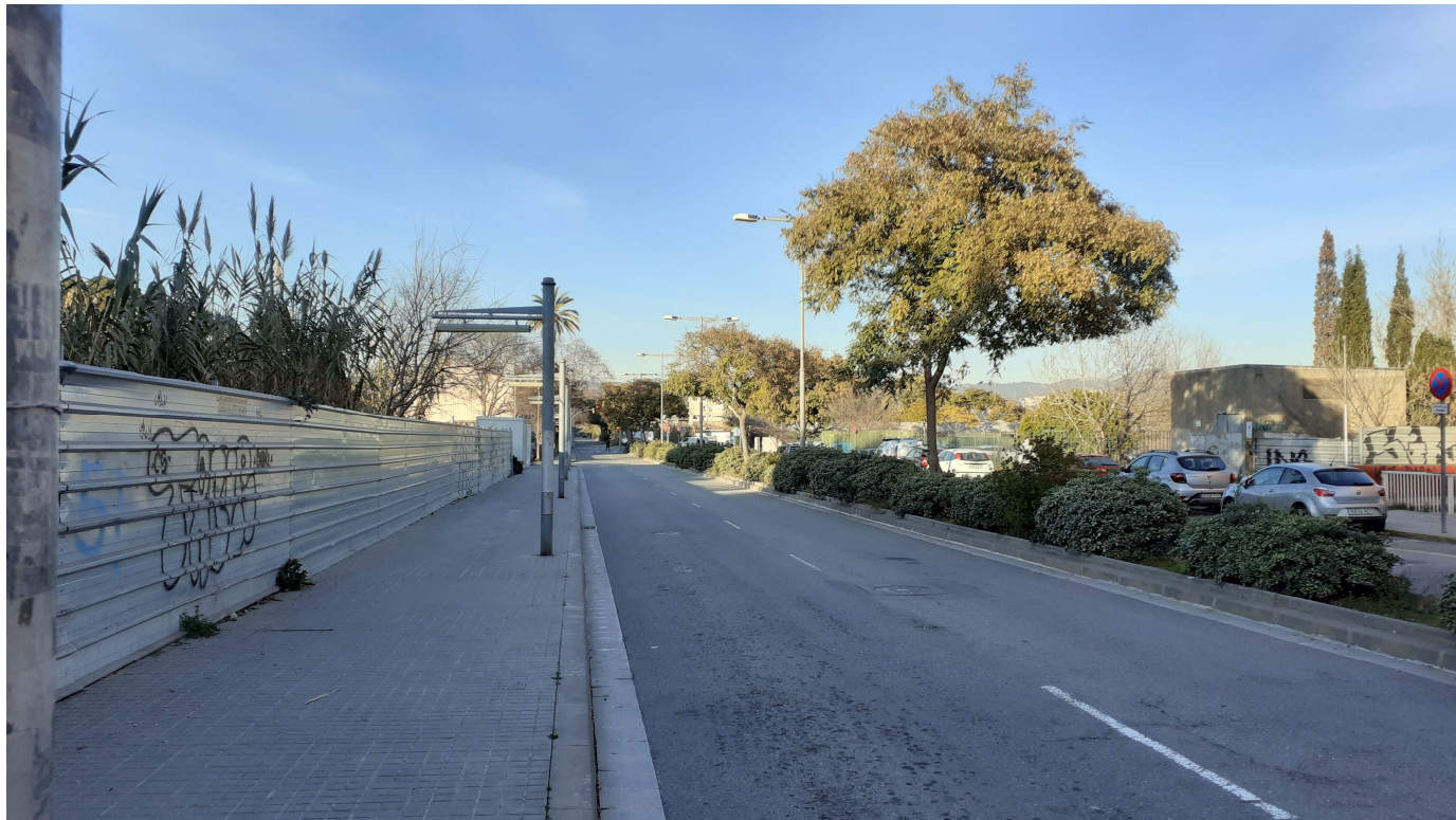
Calçada oest del carrer Bonaventura Calopa, fora del sector, amb dos carrils de circulació, vorera de paviment de panot, amb enllumenat específic, i mitjana enjardinada i amb enllumenat. Tapes de registre dels dos col·lectors existents de pluvials i fecals.
