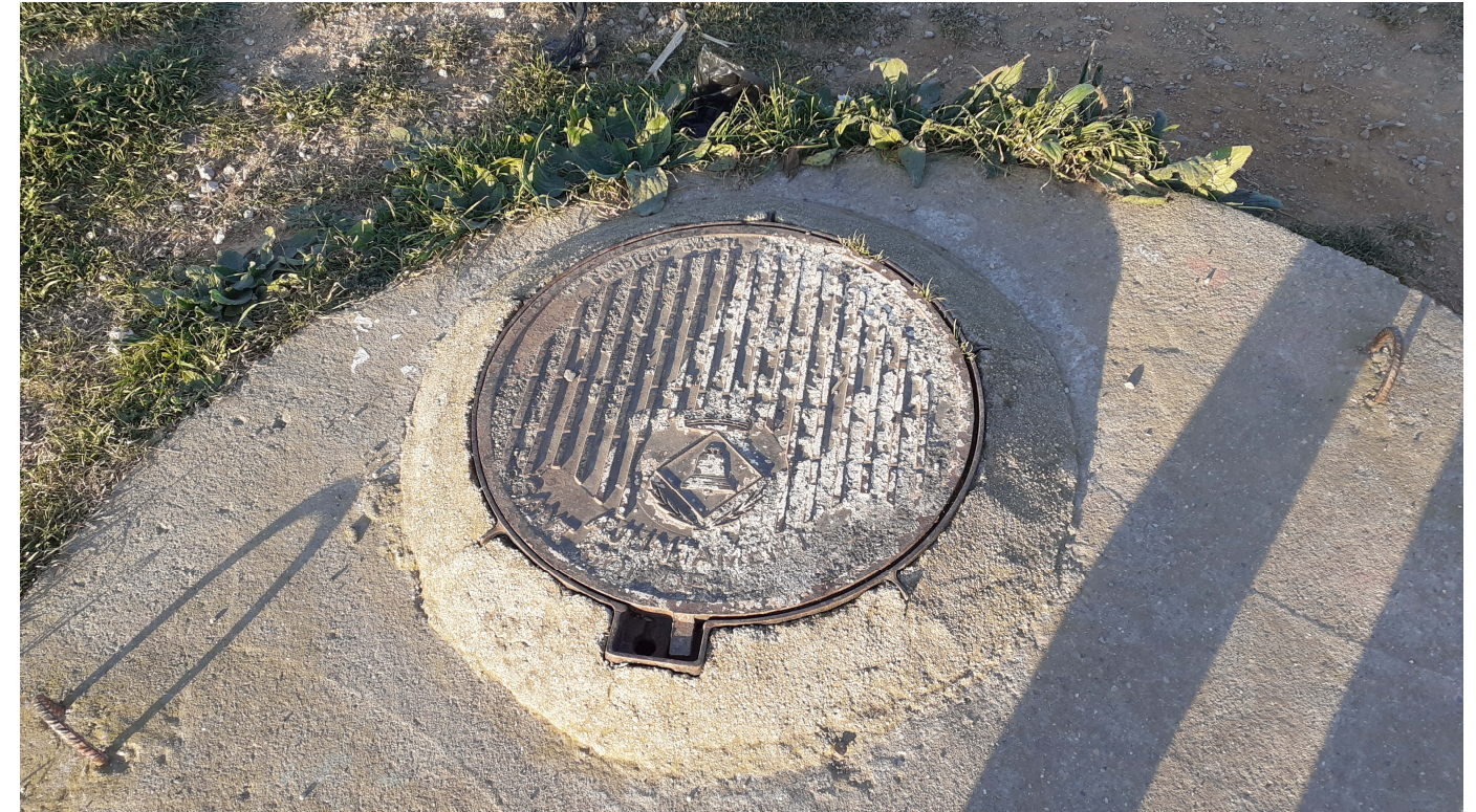
Pou de registre d'un col.lector d'aigües pluvials municipal situat a la zona de l'estacionament provisional, inclòs dins de la zona verda.
