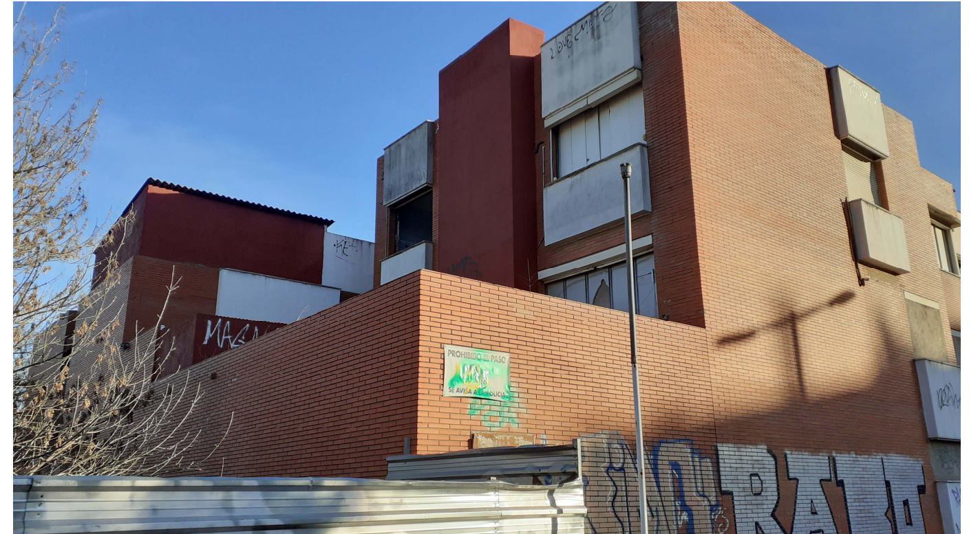
Antic edifici del hospital, a enderrocar segons projecte de desconnexió independent del present projecte.
