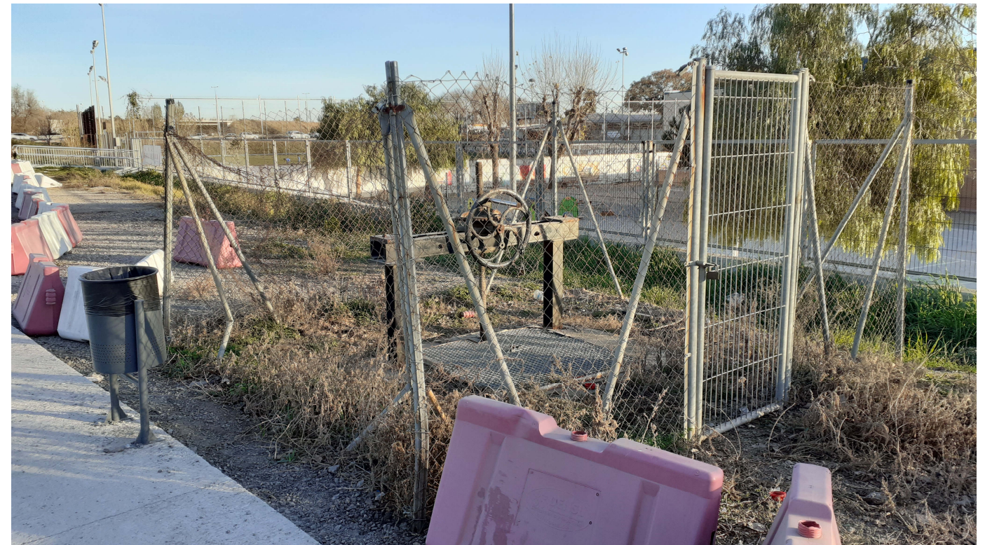
Arqueta de reg del canal dret del Llobregat, situada als entorns del centre esportiu.
