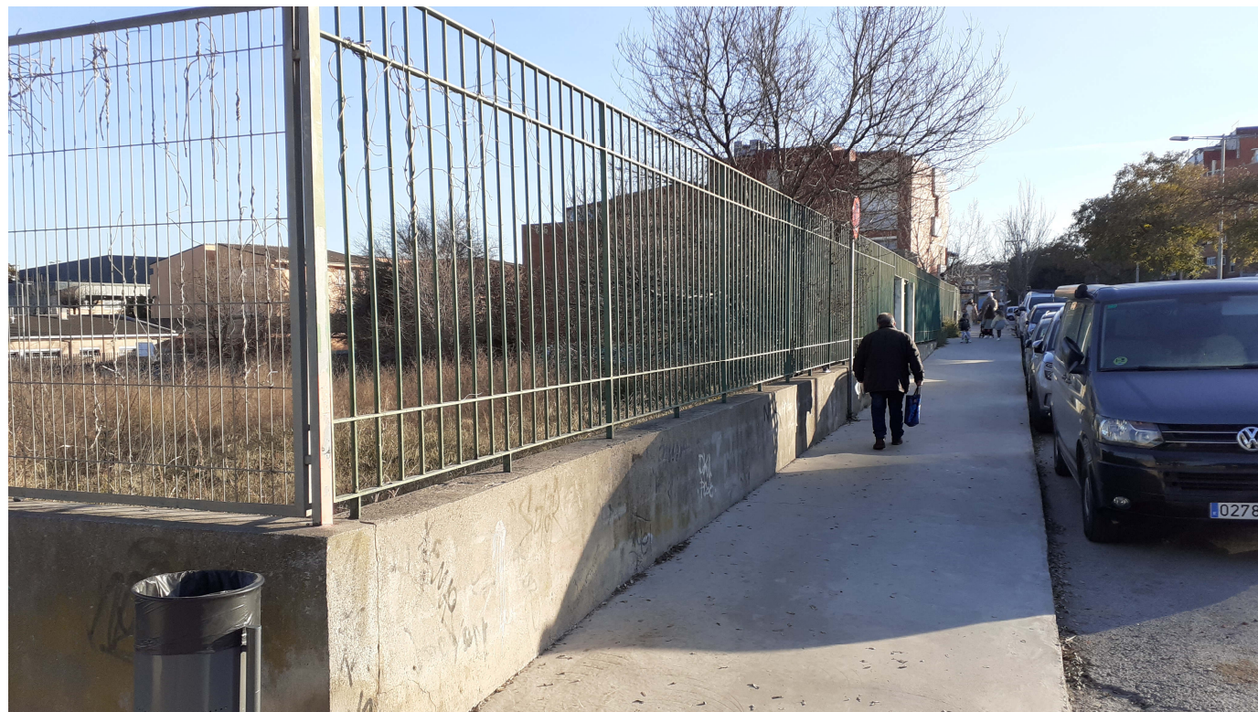
Vorera del carrer Bonaventura Calopa, davant del solar existent, entre l'antic hospital i l'aparcament provisional. Vorera de paviment de panot i de formigó. Franja d'estacionament.
