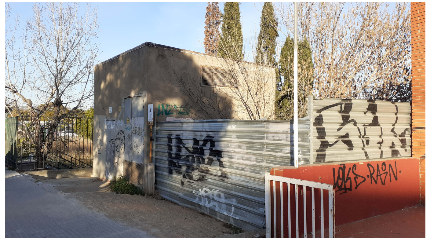
Centre transformador existent d'ENDESA, al costat del antic hospital, amb edifici, ventilacions i accés per la vorera del carrer Bonaventura Calopa.
