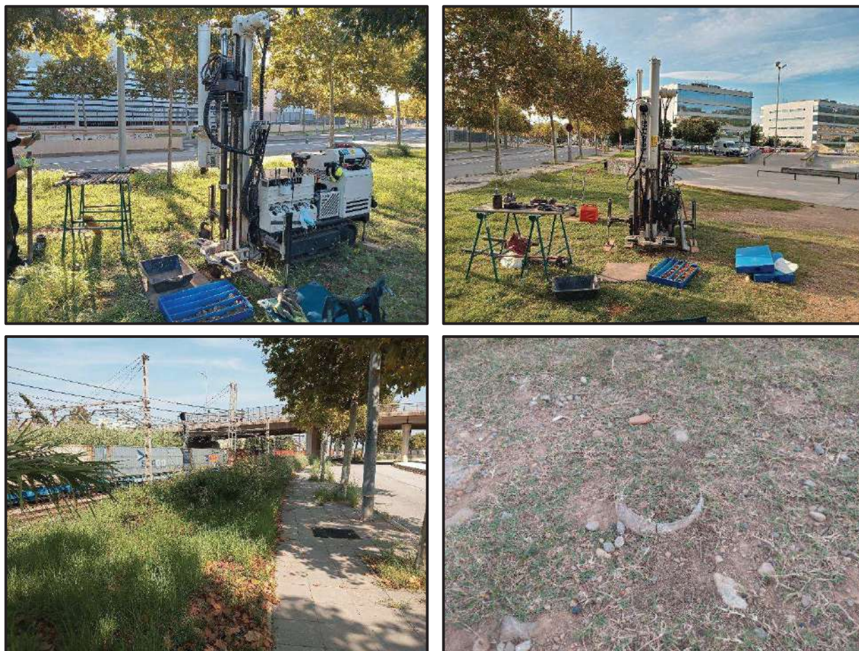
A dalt, diferents vistes de la zona d'estudi amb la maquinària de sondeigs emplaçada, amb el sondeig S-1 a l'esquerra i el sondeig S-2 a la dreta. A baix a l'esquerra, detall de la franja de terra més estreta situada al nord de la zona d'estudi, on la presència de serveis dificulta l'emplaçament de nous sondeigs. A la dreta, detall de restes d'uralita en superfície.
