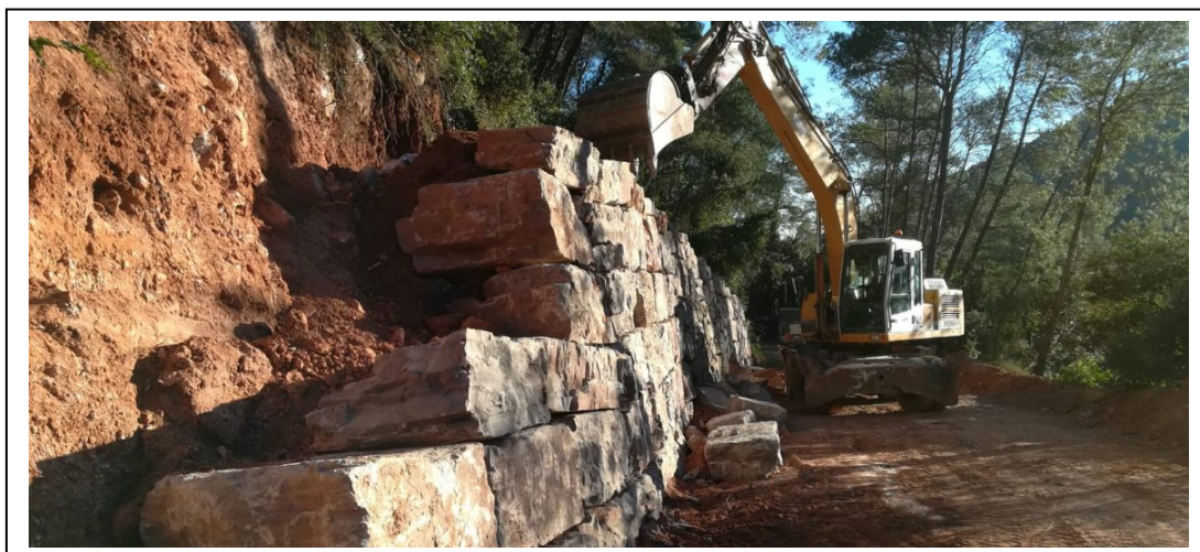
Imatge 26: Construcció d'una escullera.(Foto empres DuoCAstellà)
