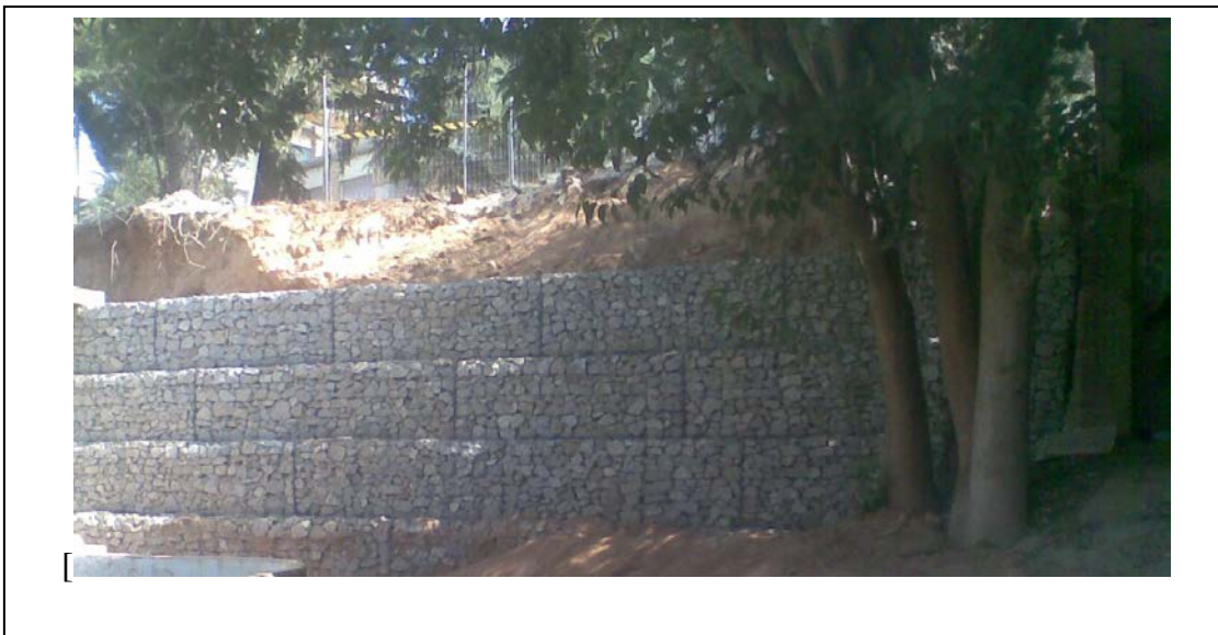
Imatge 23: Exemple mur de gabions.
