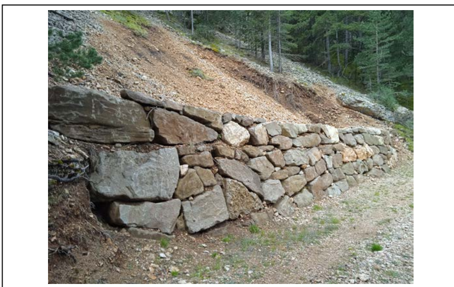
Imatge 20: mur escullera construïda en un altre fase
