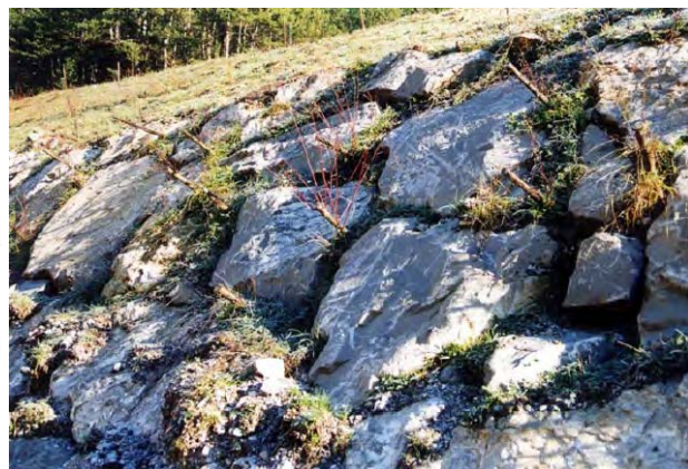
Figura 10. Esquerra: detall constructiu de mur d'escullera amb vegetació (Font: MMAMRM). Dreta: exemple de mur d'escullera amb plantació d'estaques vives.
