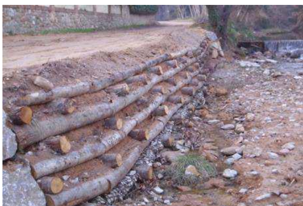
Figura 7. Superior: diagrama amb detall de les característiques d'un entramat viu entre dues parets o mur Krainer (Font: ACA). Inferior: exemples d'entramats vius entre dues parets o murs Krainer en funcionament (Font: Naturalea).
