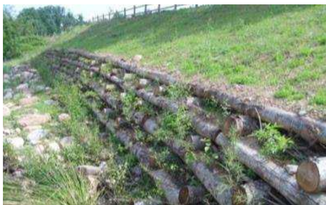
Figura 7. Superior: diagrama amb detall de les característiques d'un entramat viu entre dues parets o mur Krainer (Font: ACA). Inferior: exemples d'entramats vius entre dues parets o murs Krainer en funcionament (Font: Naturalea).
