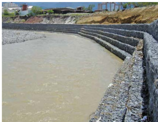
Figura 12. Exemple de mur de gabions.
