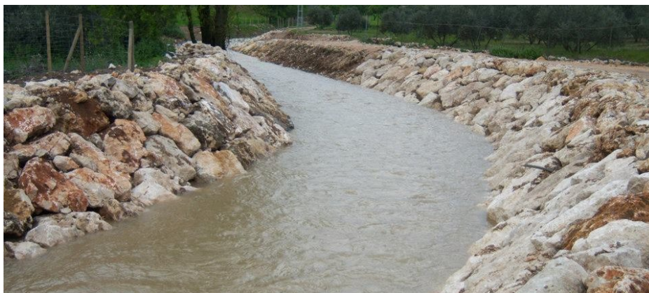
Figura 11. Exemple de mur d'escullera
