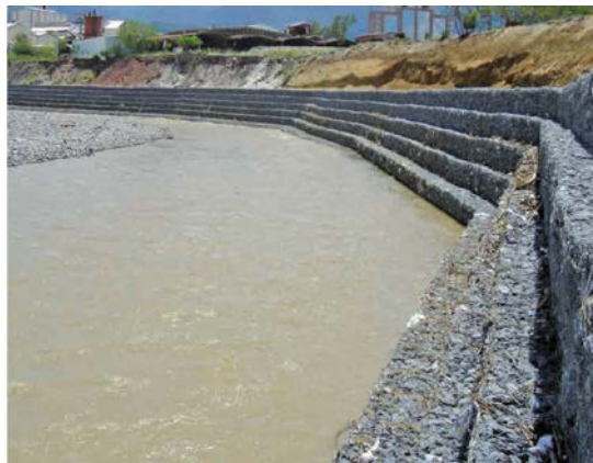
Figura 30. Exemple de mur de gabions.
