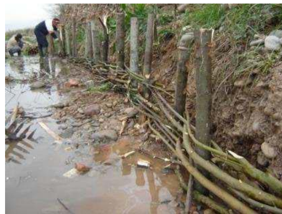
Figura 20. Esquerra: esquema d'estacades trenades (Font: ACA). Dreta: instal·lació d'estacades trenades amb material viu (Font: Naturalea).
