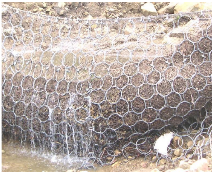
Figura 1. Fenomen de flux de detrits, retintut per una barrera Geobrugg UX/VX.
