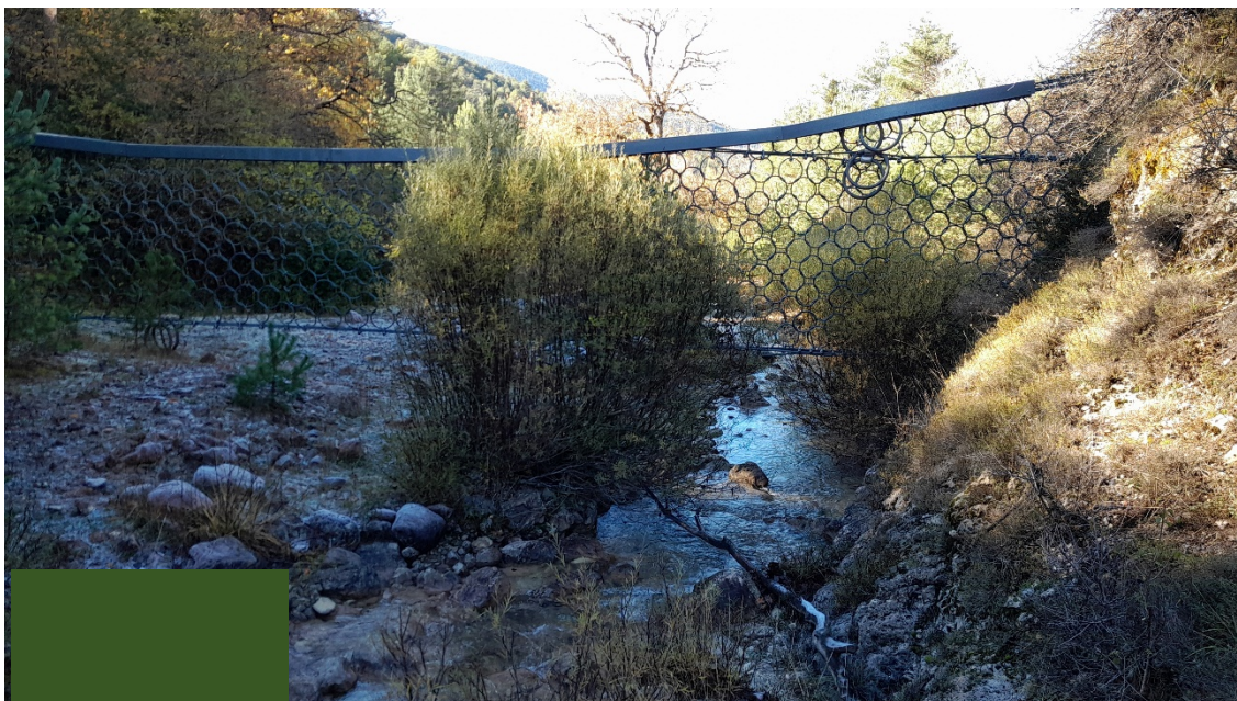
Figura 44. Vista general del dic 6, on es pot veure el seu bon estat general, així com l'abundant vegetació.
