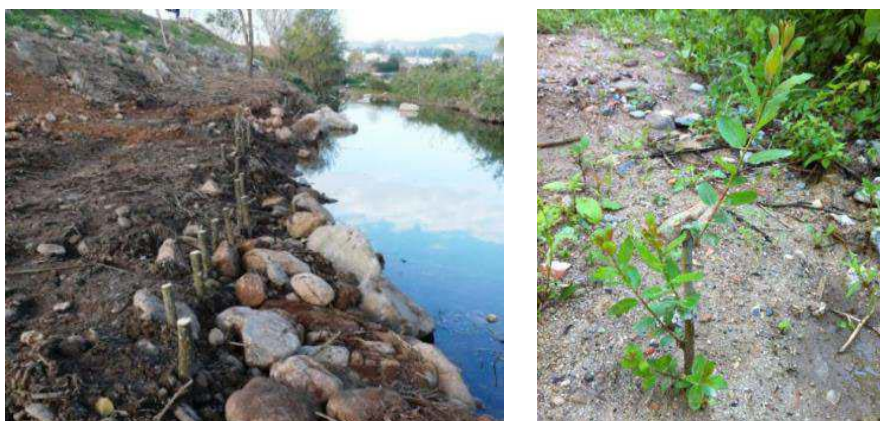
Figura 17. Esquerra: instal·lació d'estaques vives per la restauració d'una ribera fluvial (Font: Naturalea). Dreta: correcta foliació d'estaques després d'un èxitós arrelament (Font: Naturalea).
