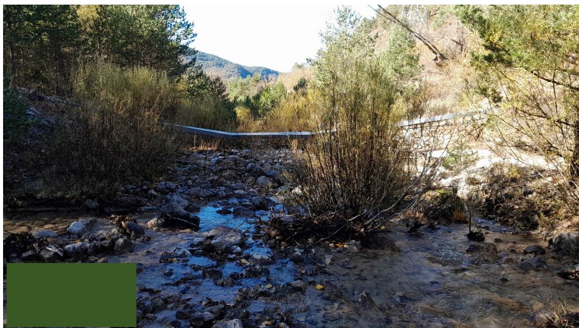
Figura 43. Vista general del dic 5, on es pot veure el seu bon estat general, així com l'abundant vegetació.
