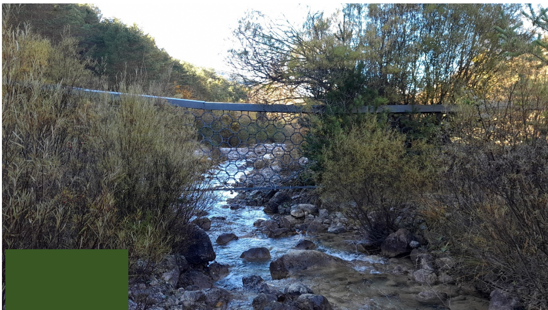
Figura 45. Vista general del dic 7, on es pot veure el seu bon estat general, així com l'abundant vegetació.
