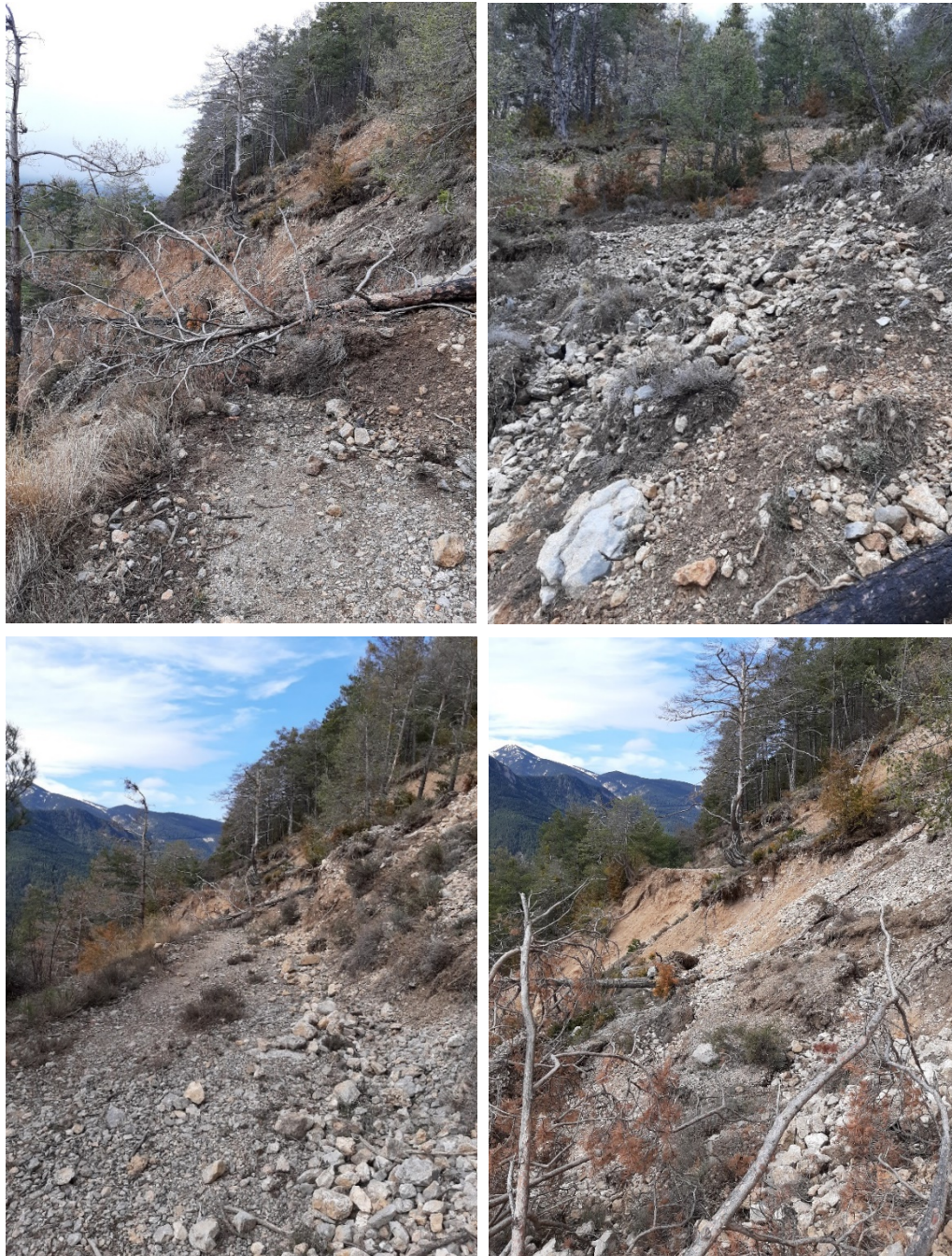
Figura 3. Imatges que mostren l'estat del camí de Can-Deu-Serra just després de l'esllavissada provocada pel temporal Glòria (Font: Meritxell Martí Solé).
