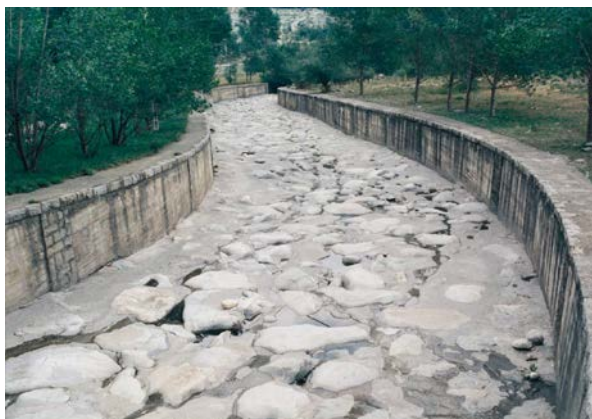
Figura 28. Exemple de solera de blocs reblert amb formigó (Font: MMAMRM).
