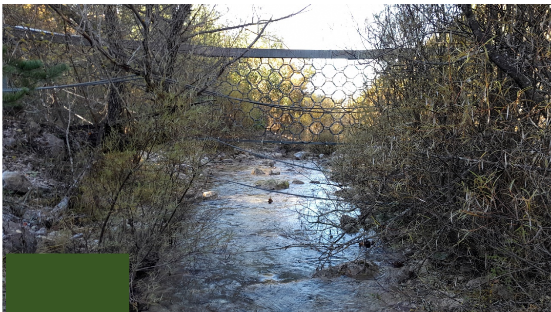
Figura 42. Vista general del dic 4, on es pot veure el seu bon estat general, així com l'abundant vegetació.
