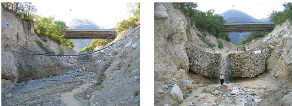
Figura 2. Exemple de perfecte funcionament de dic flexible en un torrent. Esquerra: situació del dic immediatament després de la seva instal·lació. Dreta: situació del dic després d'una crescuda extraordinària. Es pot observar que el dic ha estat capaç de retenir tots els materials grollers mentre que la fracció líquida ha estat capaç de travessar-lo.
