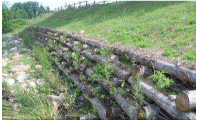
Figura 24. Superior: diagrama amb detall de les característiques d'un entramat viu entre dues parets o mur Krainer (Font: ACA). Inferior: exemples d'entramats vius entre dues parets o murs Krainer en funcionament (Font: Naturalea).
