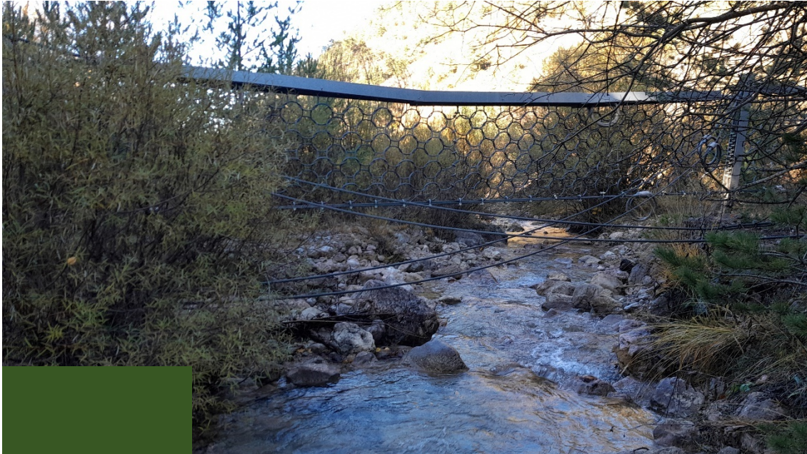
Figura 41. Vista general del dic 3, on es pot veure el seu bon estat general, així com l'abundant vegetació.
