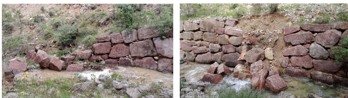
Figura 34. Diferents exemples de punts on l'escullera s'ha malmès, mostrant la disponibilitat de les pedres caigudes a la pròpia llera del riu.
