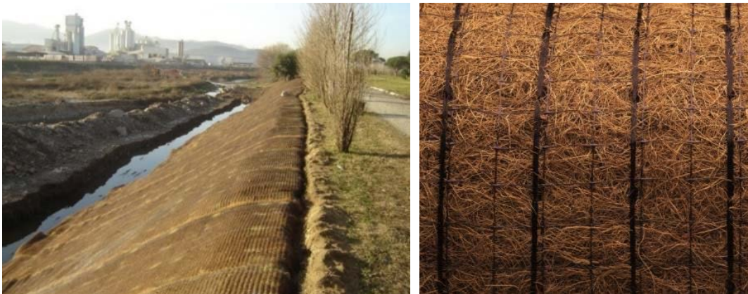
Figura 18. Esquerra: geomalla permanent (Font: Naturalea). Dreta: manta orgànica (Font: Naturalea).
