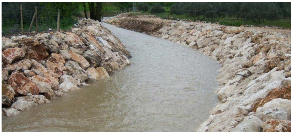
Figura 29. Exemple de mur d'escullera
