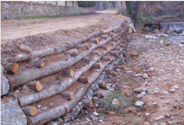
Figura 24. Superior: diagrama amb detall de les característiques d'un entramat viu entre dues parets o mur Krainer (Font: ACA). Inferior: exemples d'entramats vius entre dues parets o murs Krainer en funcionament (Font: Naturalea).
