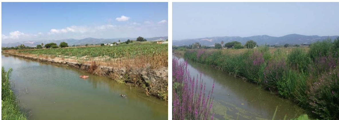
Figura 14. Exemple d'estabilització de canal de reg mitjançant sembra (Font: Naturalea). Esquerra: canal de reg abans de l'actuació. Dreta: canal de reg després de l'actuació.
