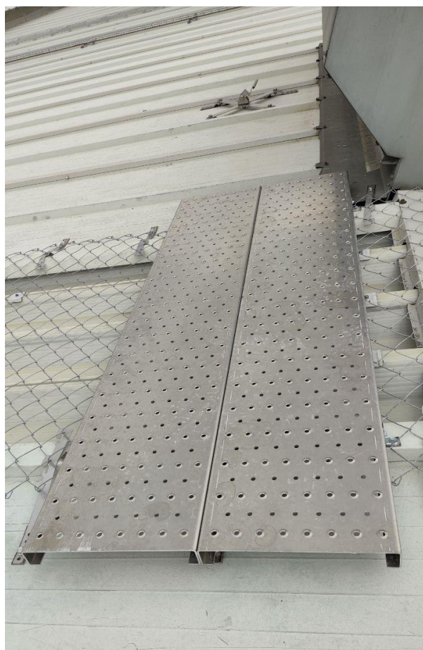
Fig. 21 Exemple malles i passeres per lluernes.
