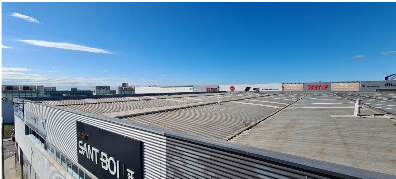
Fig. 9 Vista general coberta de la nau
