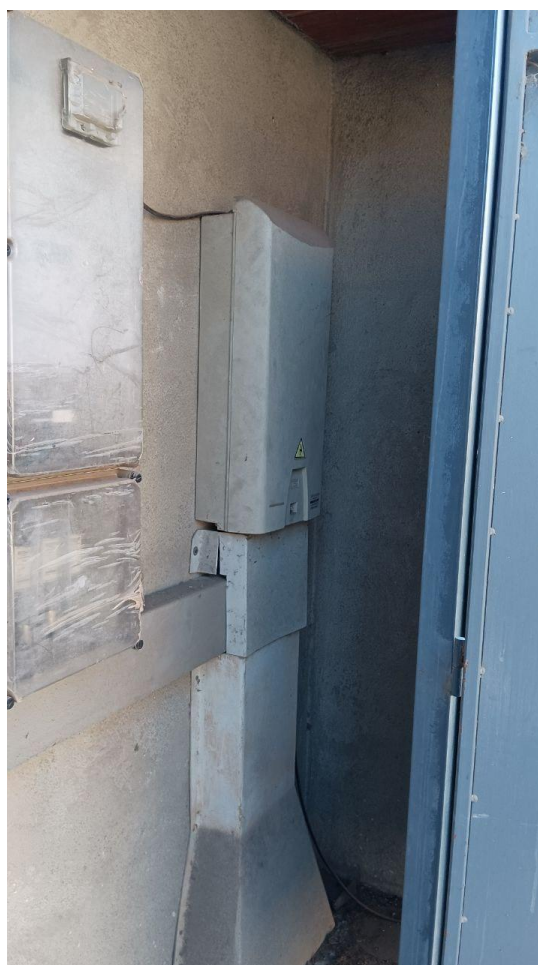
Fig. 16 Detall CGP-9-400A del C/Tints 9
