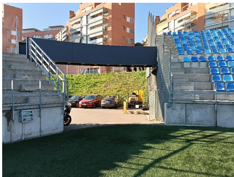
Accés al terreny de joc
