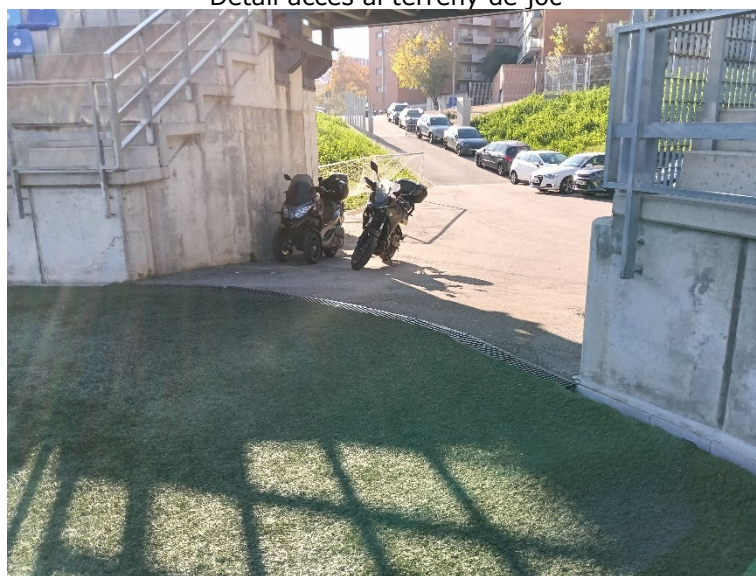
Detall accés al terreny de joc
