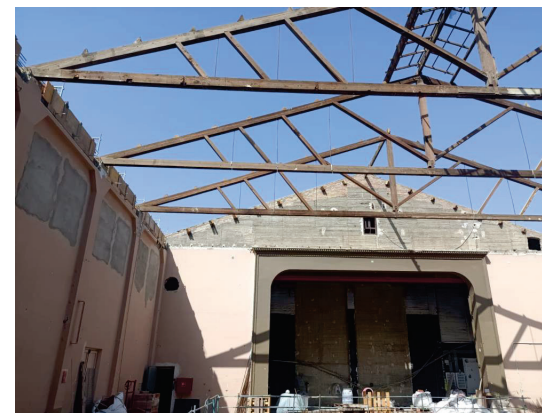
Imatge 3. Imatge de la coberta al moment de redacció del projecte
