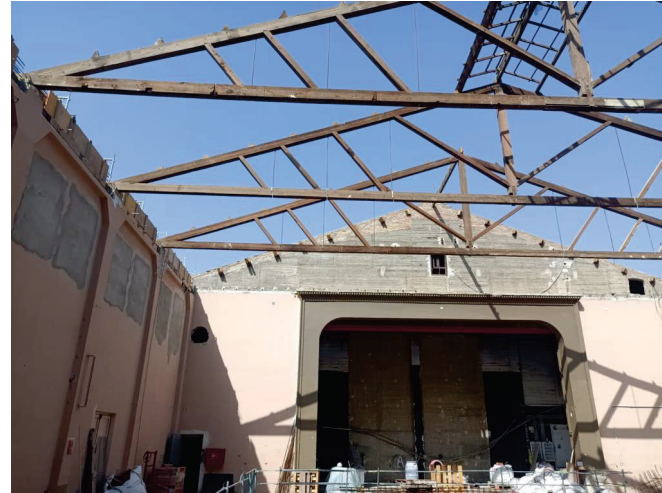
Imatge 17. Coberta en obres
