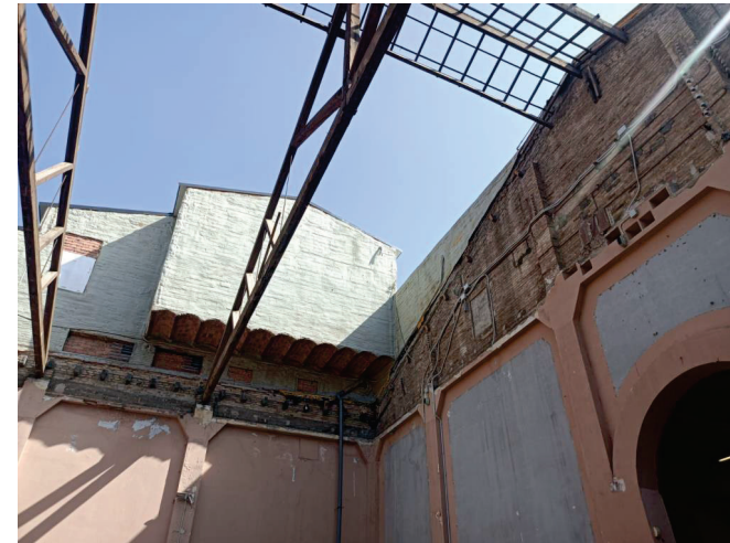
Imatge 18. Espai destinat al terrat d'equips
