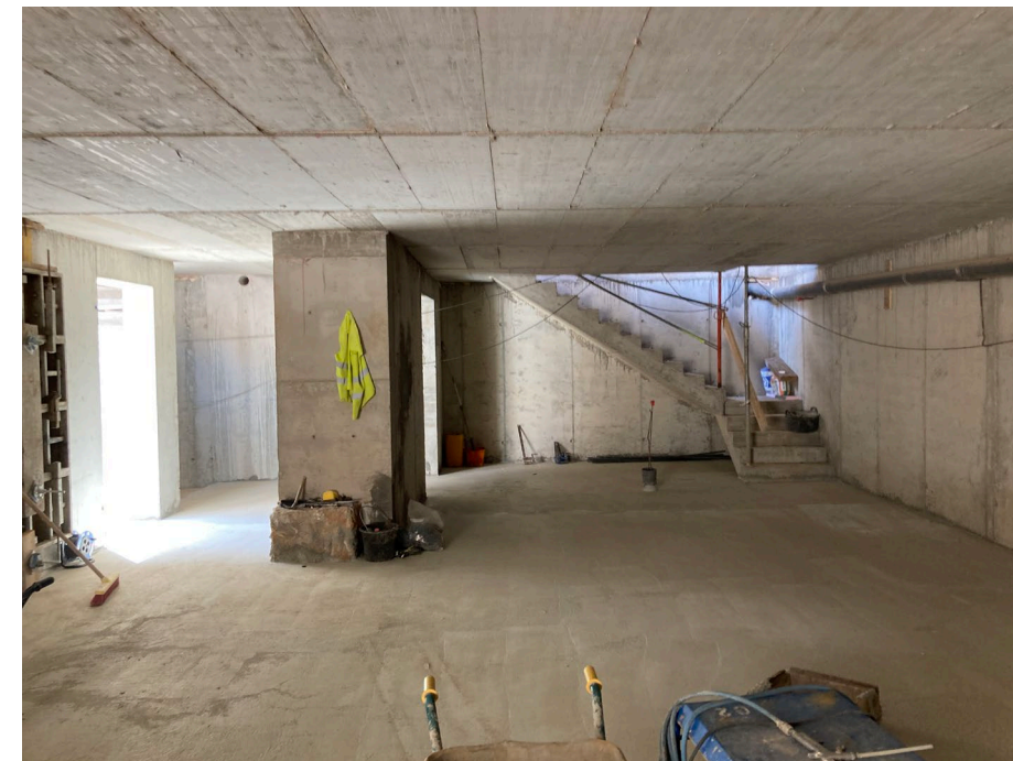
EDIFICI REFORMAT – ESTAT ACTUAL – CAMERINOS
