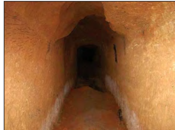
Parets de llims marró amb carbonats. Inici de tram de desprendiments. .
