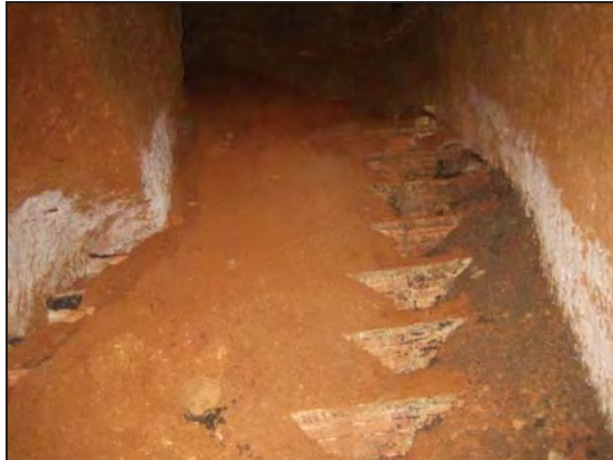
Escales que pugen a la superfície.
