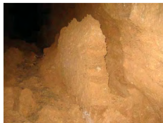
Tram de 6 metres, amb desprendiments de les parets de la galeria.
