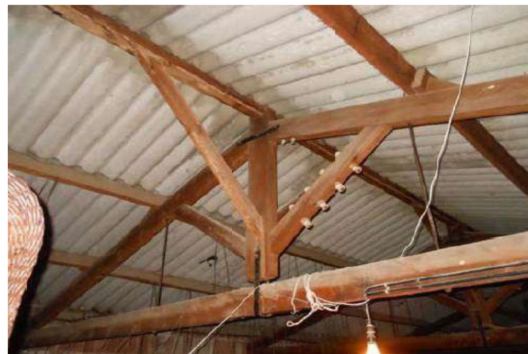
EDIFICI ORIGINAL – COBERTA - ENCAVALLADES
