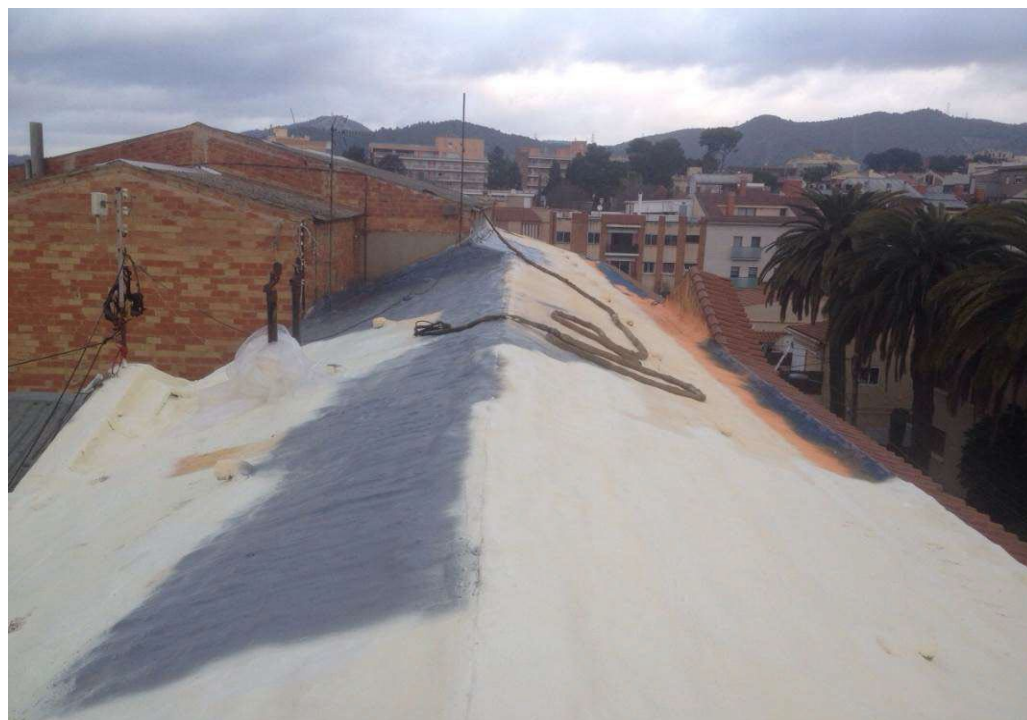
EDIFICI ORIGINAL - COBERTA EDIFICI DE L'ATENEU
