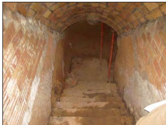
Accés a la galeria. Primer tram.
