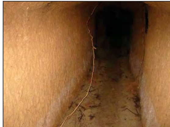
Parets de llims marró amb carbonats. Inici de tram de desprendiments. .
