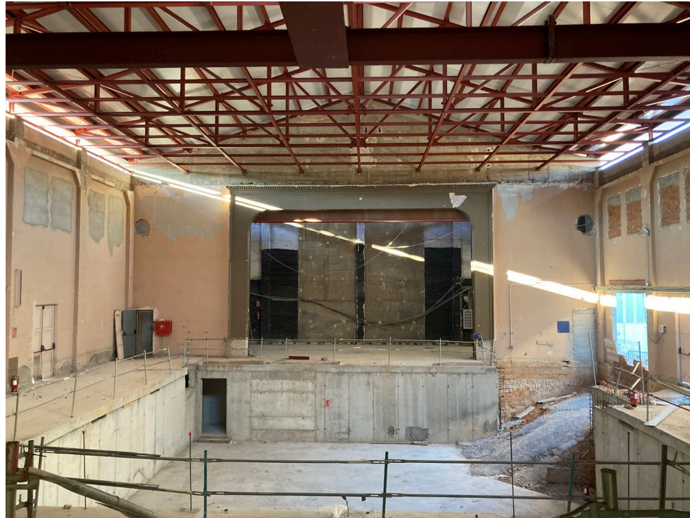
EDIFICI REFORMAT – ESTAT ACTUAL – SALA
