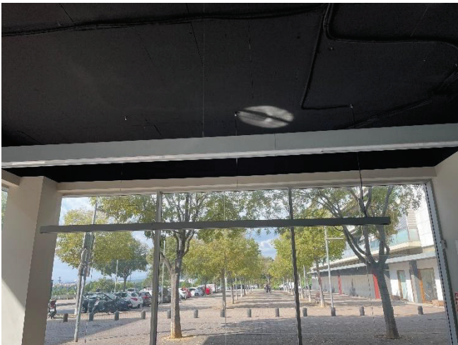
5.Sala: Lluminares en suspensió 2ud de 5m.
