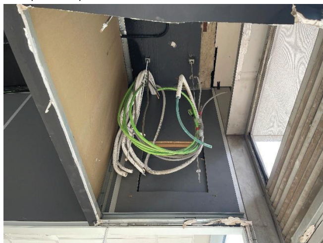
3.Sala: Cablejat màquines aire condicionat.
