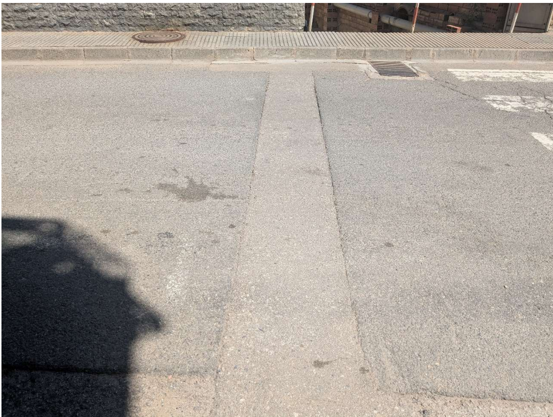
Foto 38: Detall encontre carrer amb el pont. Carrer Barcelona.
