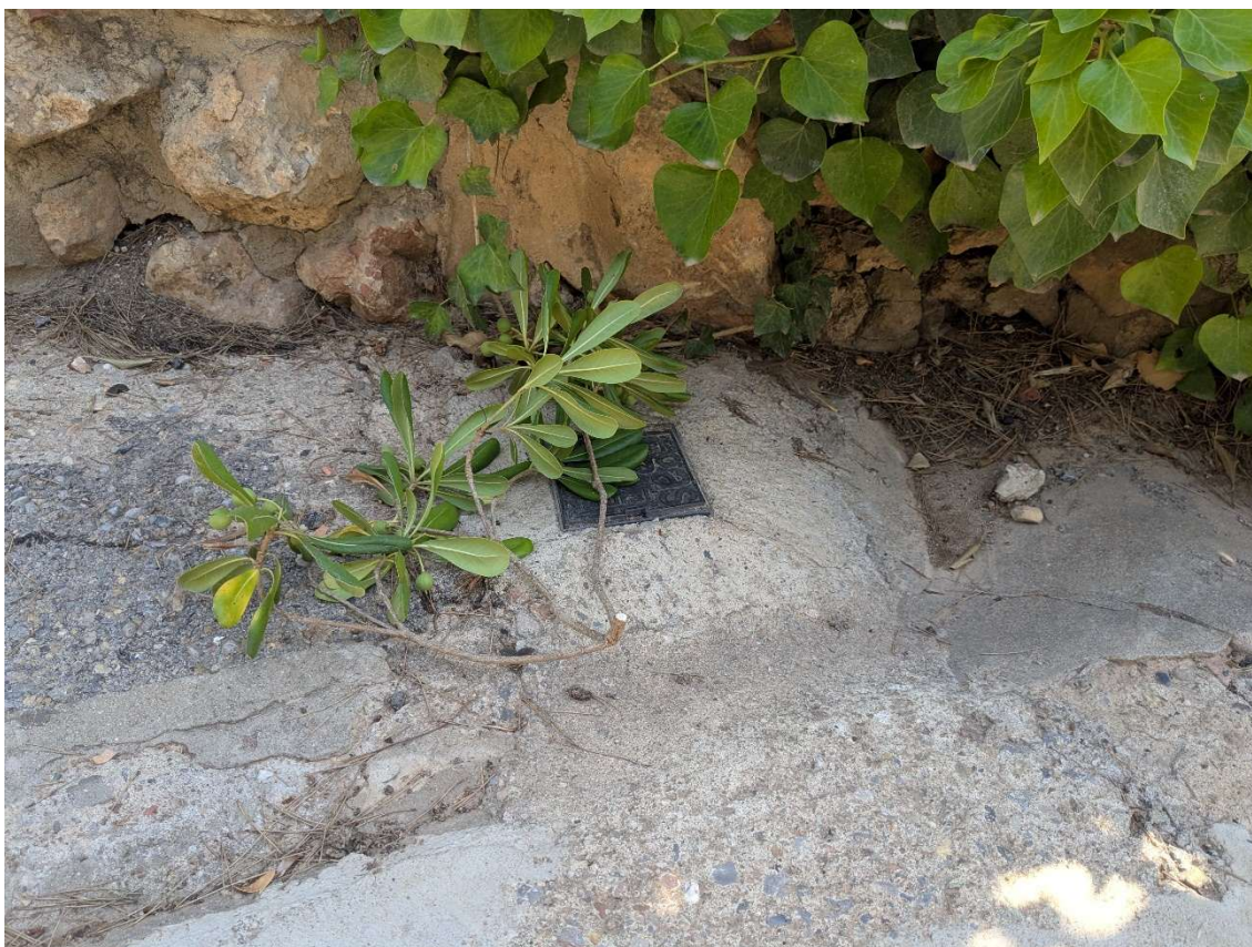
Foto 8: Escomesa Gas càmping l'Estartit. Pujada de la Primavera.
