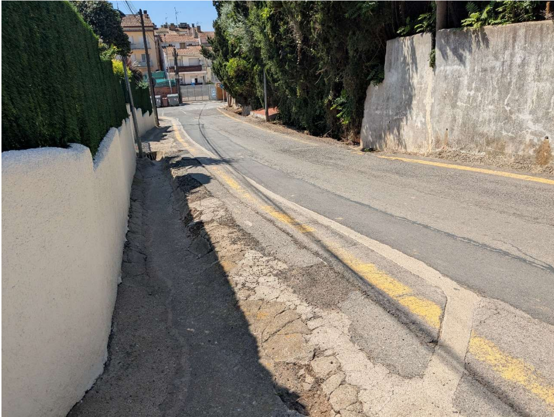
Foto 20: Cuneta i rasa Telecomunicacions. Pujada de la Primavera.
