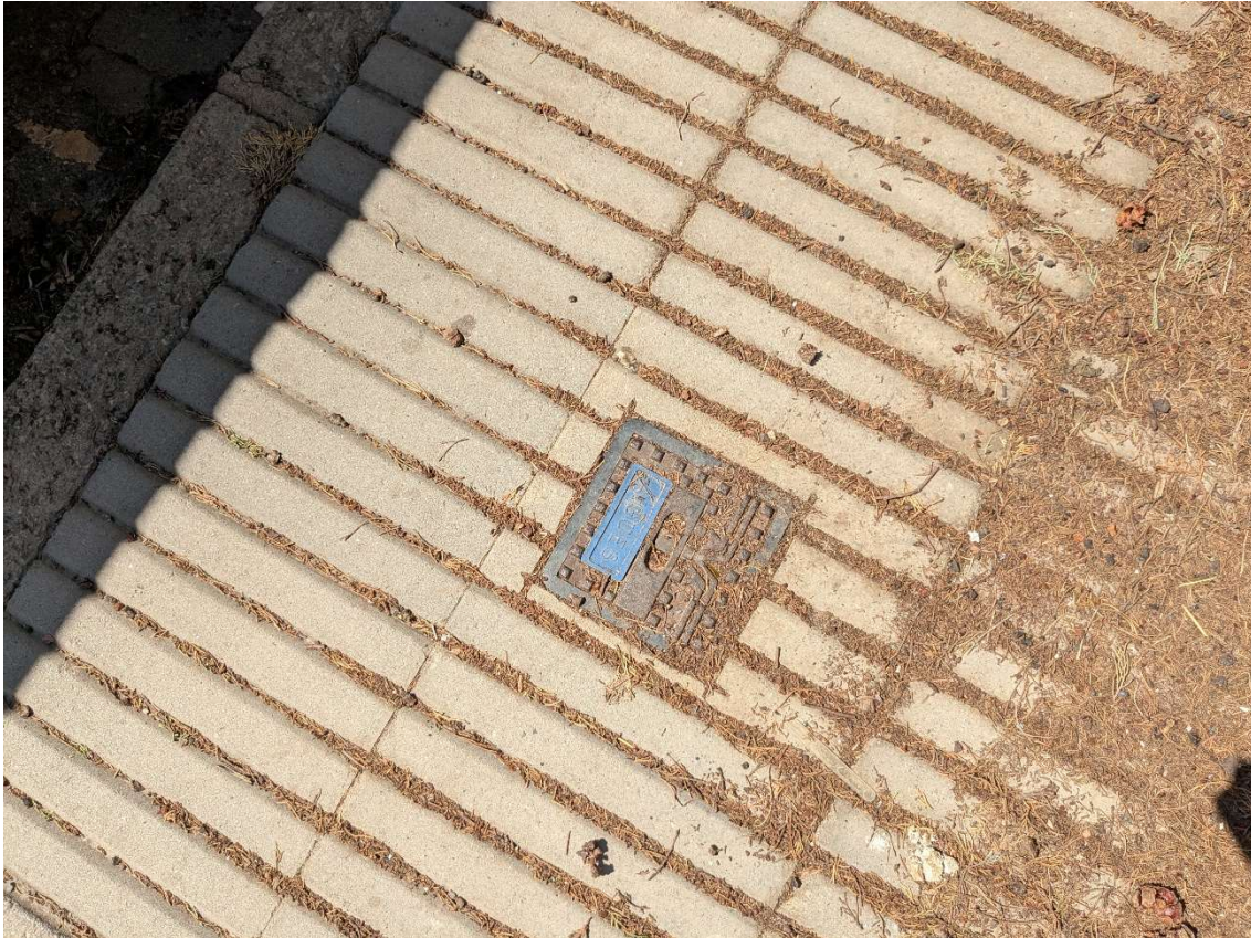
Foto 25: Clau de distribució aigua. Carrer Barcelona cantonada amb Pujada de la Primavera.
