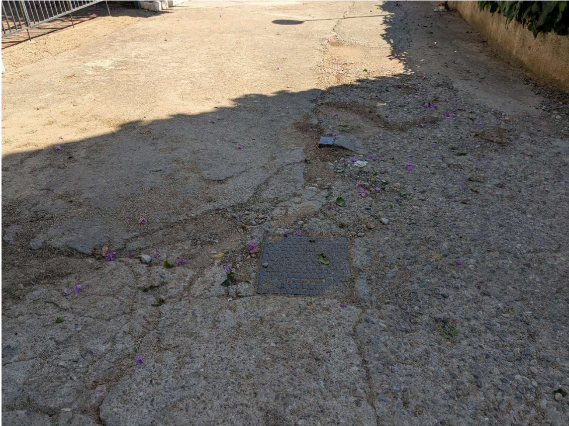
Foto 11: Arqueta d'aigua. Carrer del Volantí.
