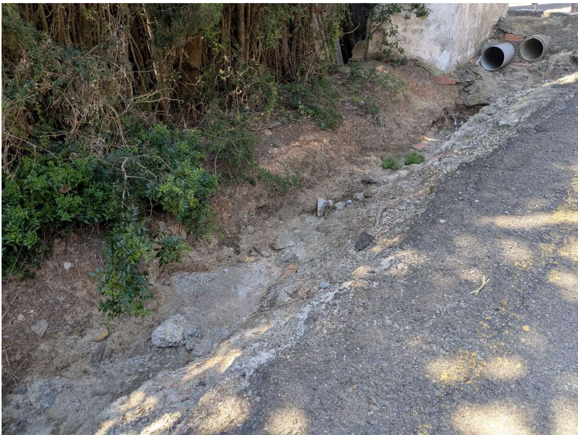
Foto 5: Detall cuneta. Pujada de la Primavera.
