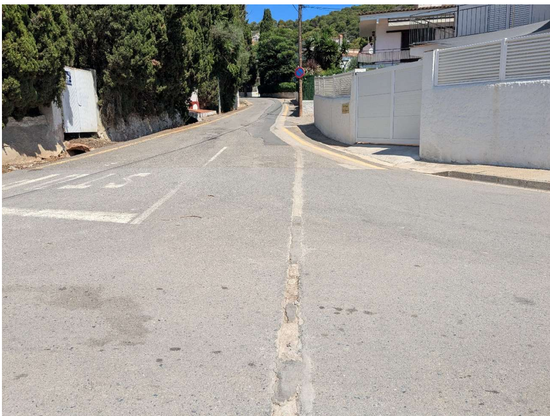
Foto 27: Rasa Telecomunicacions. Carrer Barcelona cantonada amb Pujada de la Primavera.
