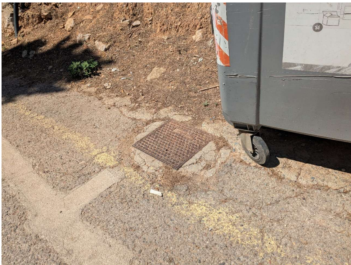
Foto 2: arqueta d'aigua. Carretera de l'Escala a l'Estartit.
