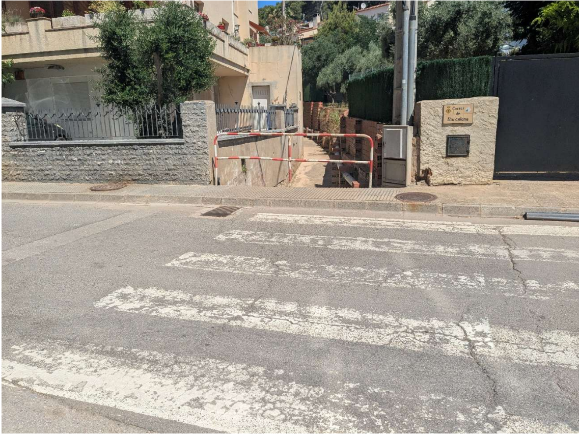
Foto 40: Pont. Carrer Barcelona.
