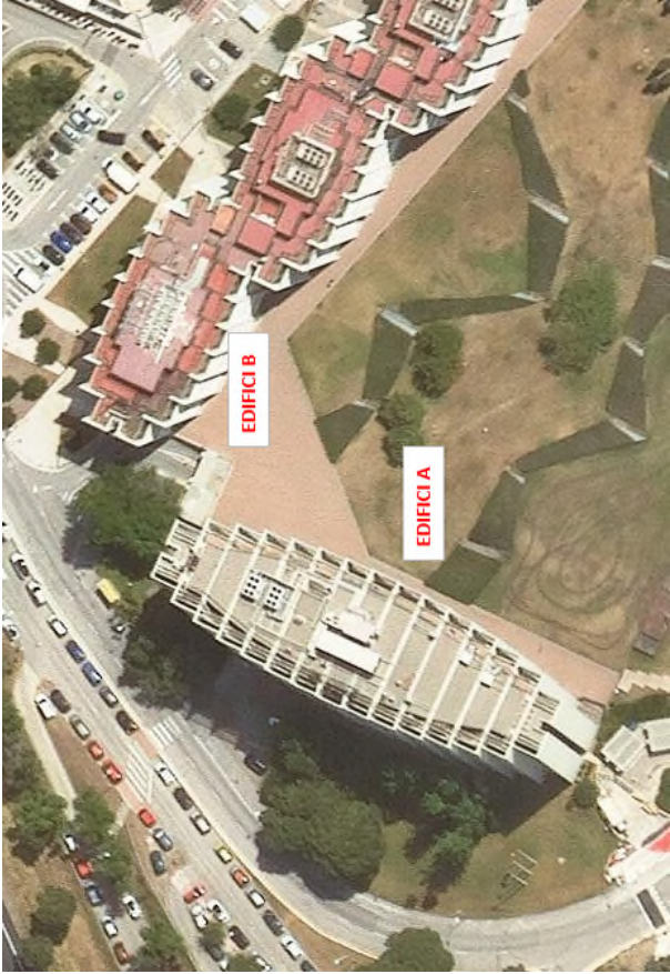
Fotografia 1: ubicació del edificis A i B de l'AMB
