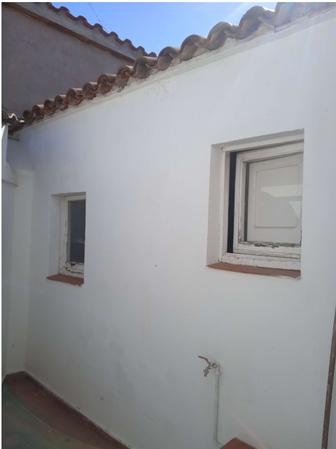
Foto 12: Sant Genís 11: façana de l'edificació original al pati est
