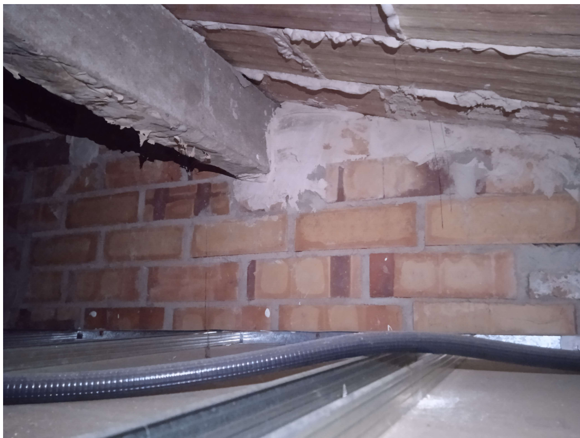
Foto 4: Sant Genís 9: coberta edificació original
