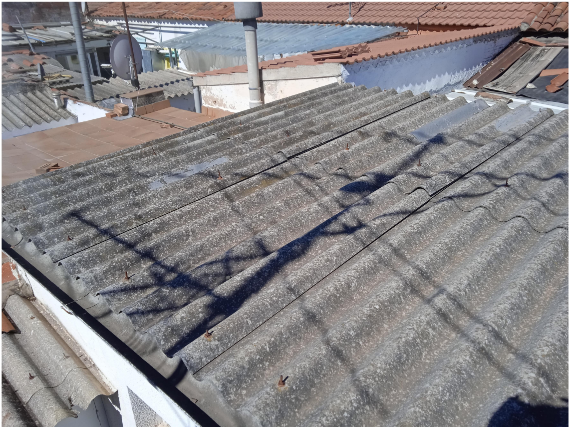
Fig. 2: Sant Genís 9: coberta C2 i canal CL3
