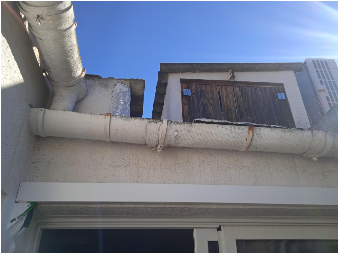
Fig. 4: Sant Genís 9: coberta C3 i canal CL2
