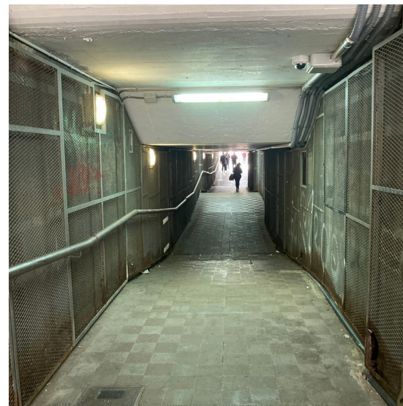
Foto 2. Vista interior del pas subterrani amb detall de paraments metàl·lics
