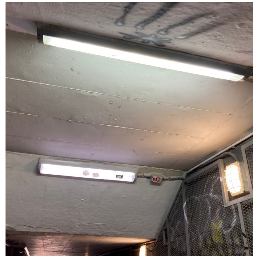
Foto 4. Estat del sostre i sistema d'il·luminació interior del pas inferior
